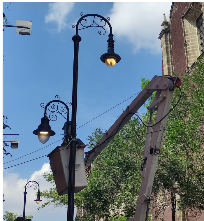
Reparación de luminarias en el Centro Histórico.
