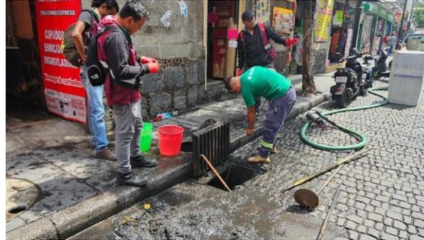
Bombeo y desazolve de drenaje de 4 accesorios pluviales (2 rejillas de piso y 2 de orilla de guarnición, sondeo de 6 metros lineales de atarjea en Regina
