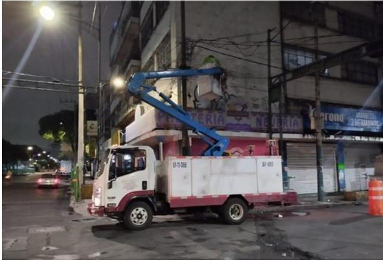
SUSTITUCIÓN DE FOTOCELDA Y LUMINARIA LED 100
