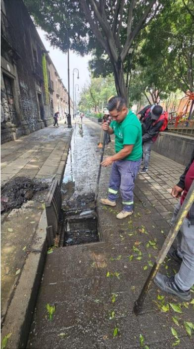
Desazolve de drenaje de 3 accesorios pluviales (rejillas de piso) y sondeo de 50 metros lineales de atarjea en Plaza Vizcaínas
