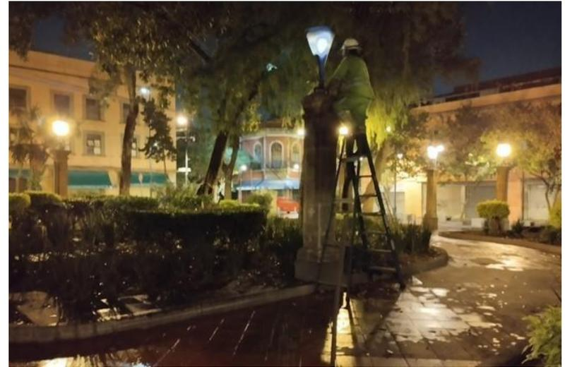
SUSTITUCIÓN DE BALASTRO ELECTRÓNICO
