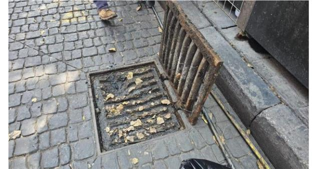
Limpieza y desazolve de 2 accesorios pluviales (2 rejillas de piso y 2 de orilla de guarnición en Mesones, retirando aproximadamente 2.5 M<sup>3</sup> de azolve.
