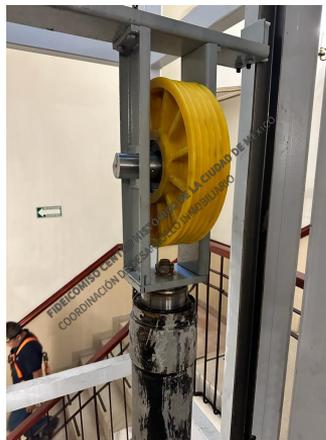
Conclusión del montaje de pistón para el sistema central del elevador
