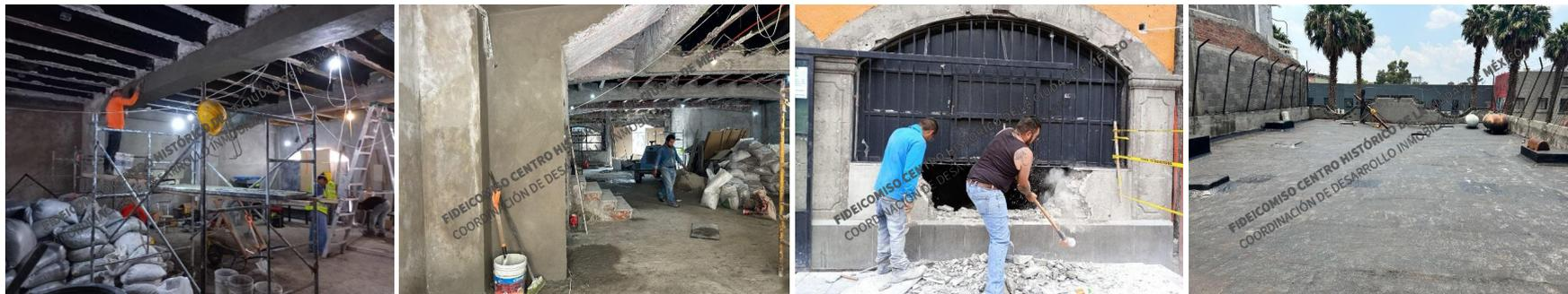
Continuación de trabajos de albañilerías: colocación de aplanado fino en muros existentes de planta baja y planta alta, apertura de vanos y adecuación de los mismos en fachada principal y fachada posterior. Trabajos en azotea para colocación de impermeabilizante.
