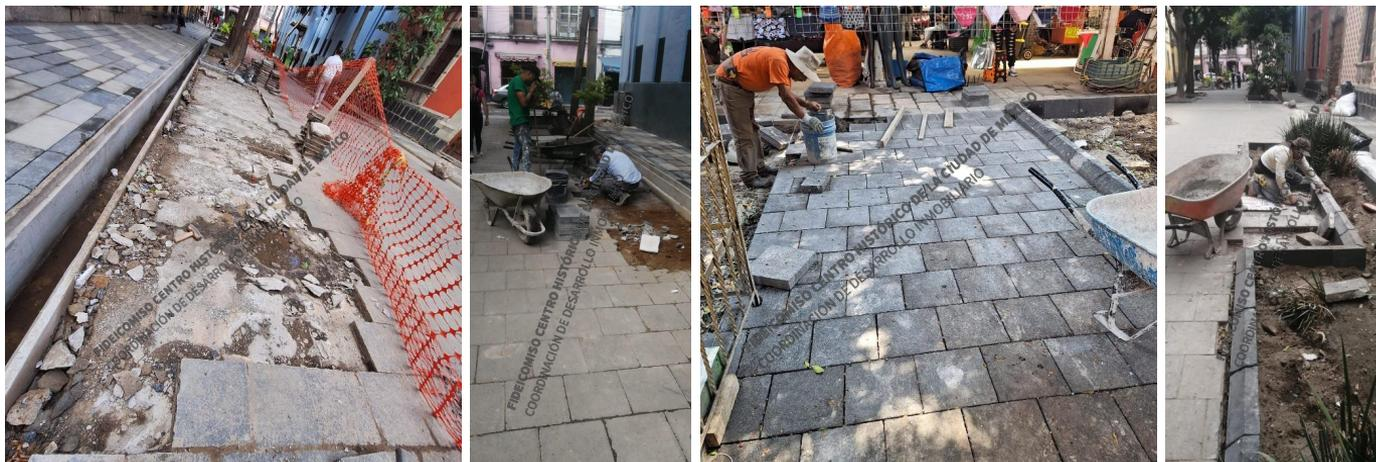
Retiro con recuperación de adoquín para renovación y recolocación, colocación de guarniciones de jardineras.
