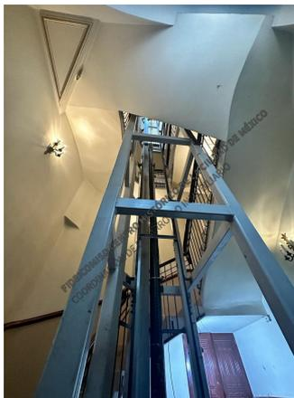
Habilitado de rieles y pistón del sistema hidráulico de elevación del elevador
