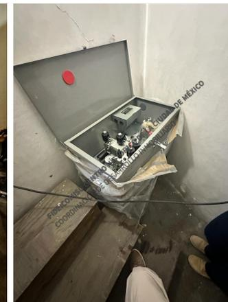
Suministro y colocación de unidad hidráulica para funcionamiento de pistones del sistema de elevador.
