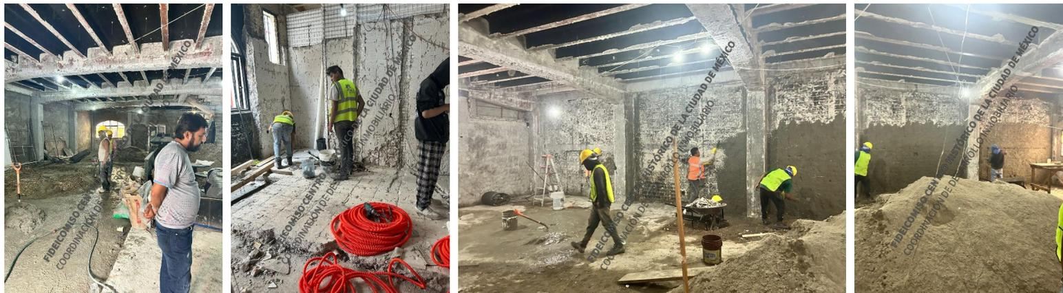
Colocación de aplanados de mortero en muros existentes, ranurado en pisos para alojar instalaciones sanitarias e hidráulicas, construcción de firme de concreto con malla electrosoldada de 12 cm para nivelación del local. Retiro de impermeabilizante existente en azotea, construcción de bases para tinacos de agua y sellado de pasos existentes en losa.
