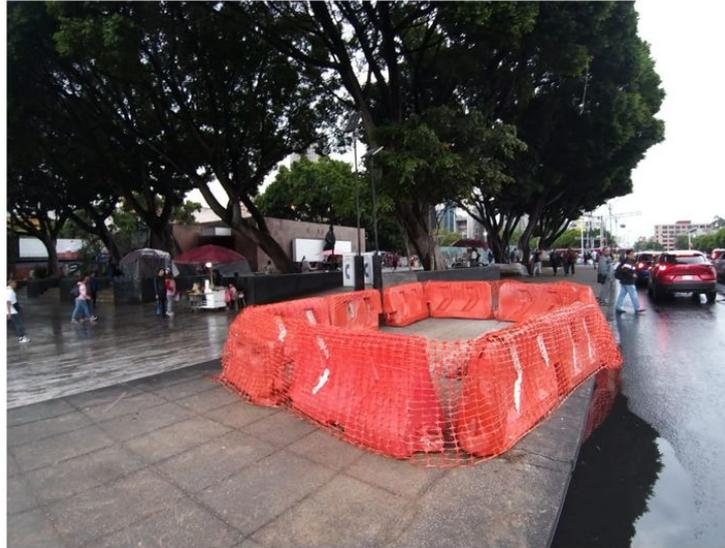
1. Se realiza el relleno y compactación del sondeo realizado derivado de que se encuentran traveses y muros pertenecientes a la infraestructura del Sistema de Transporte Colectivo Metro.
