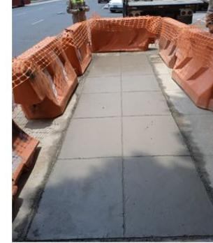
2. Relleno y compactación de sondeo con material producto de banco tepetate y colocación de firme de concreto simple de forma provisional para la definición del sitio de entrada.
