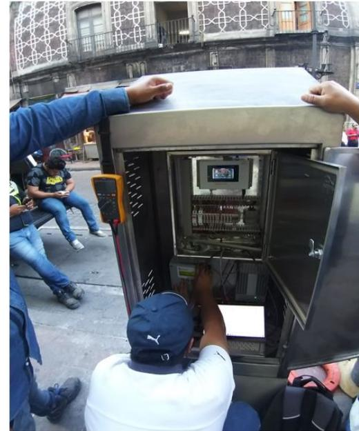
Actualmente está finalizada la obra civil perteneciente a la telemetría y se cuenta con el equipo de instrumentación instalado y programado, para la transmisión de datos, continuando pendiente su alimentación.
