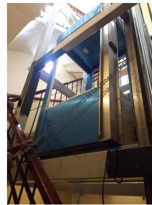
Armado de cabina del elevador
