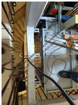
Armado de la cabina de elevador.
