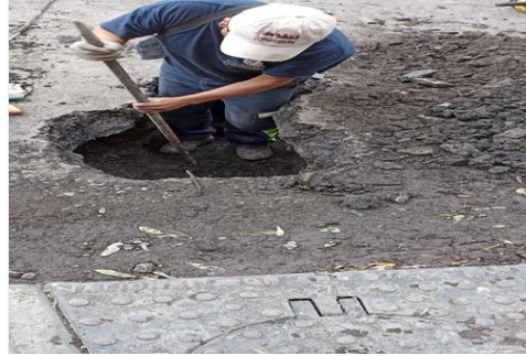
Reconstrucción de albañal pluvial en calle Lecumberri
