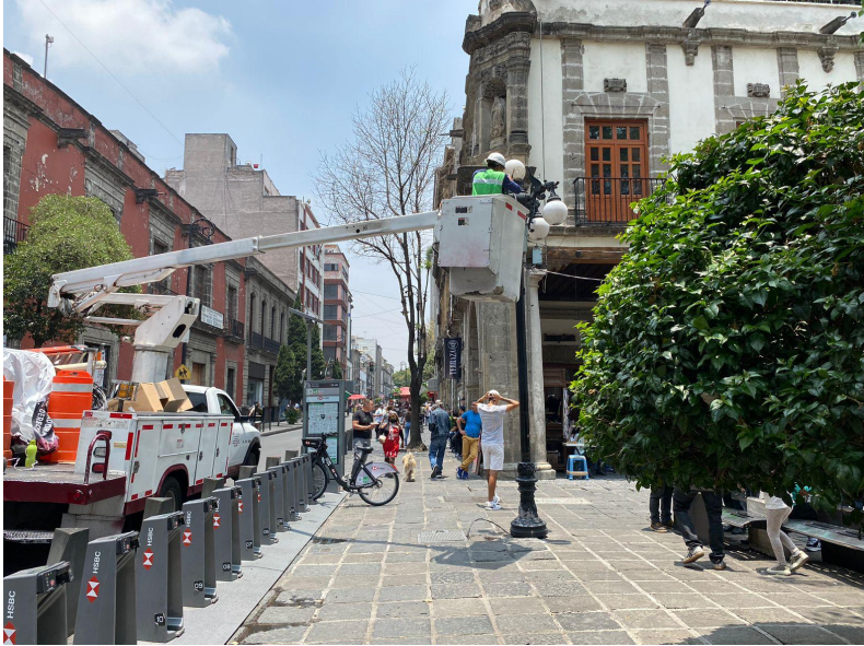
CAMBIO DE BALASTRO
