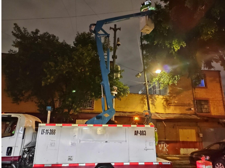
CAMBIO DE BALASTRO Y LÁMPARA
