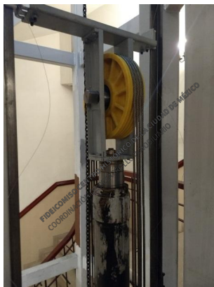
Pistón del sistema hidráulico de elevación del elevador
