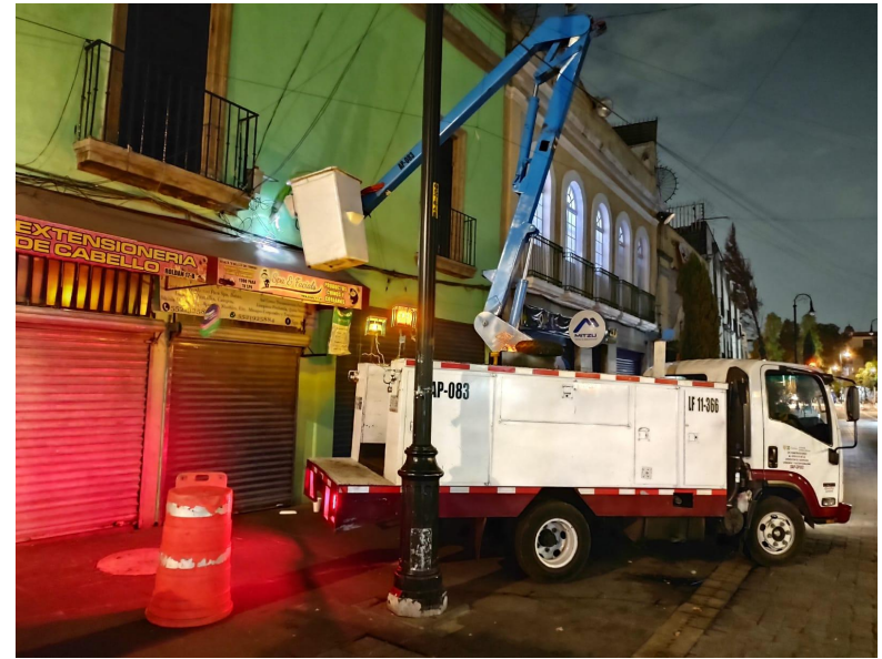
CAMBIO DE BALASTRO
