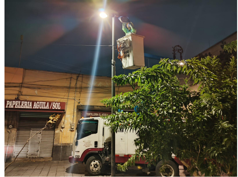
CAMBIO DE SOCKET, BALASTRO Y LÁMPARA
