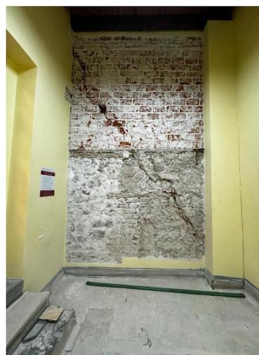
Consolidación estructural de muros de mampostería de tepetate, a base de colocación de hiladas de tabique rojo recocido
