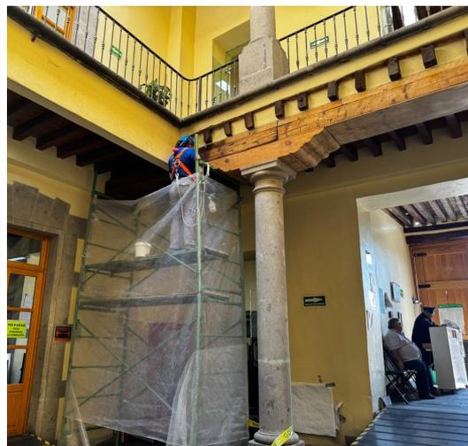
Integración de zapata de madera sobre columna de cantera.
