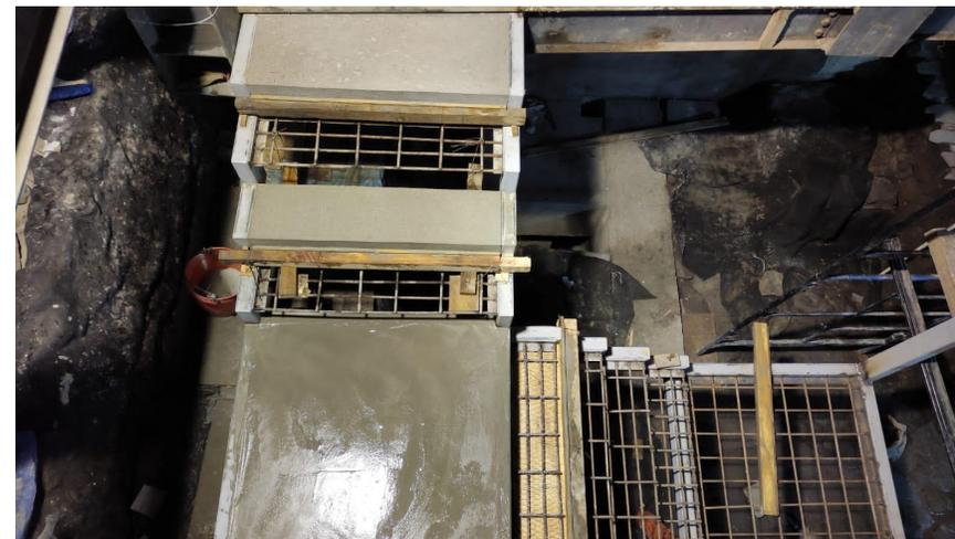
Habilitado de estructura metálica y colado de firme en huellas de escalones.
