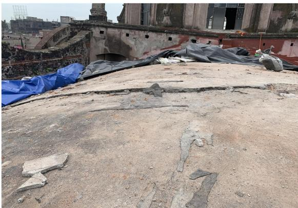
Liberación de enladrillado en extradós de bóveda en nave principal, autorización por parte de la CNMH- INAH y el FCH para comenzar consolidación de grietas.
