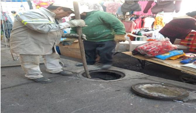
Se realizó desazolve en Manuel Doblado No. 145. Se limpian 4 coladeras y se sondean 14 metros lineales de drenaje.
