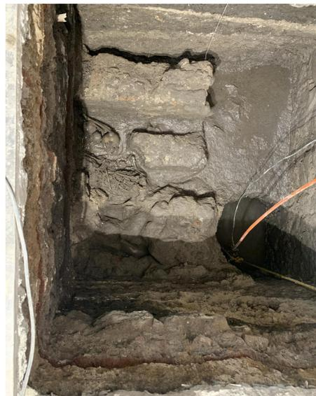
Excavación de cala arqueológica, hallazgo de cimentación original y las diferentes etapas constructivas del inmueble.
