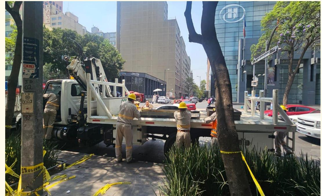
Se trabaja en coordinación con CFE apoyando con la ventilación del área, proporcionando disco de corte de metal y material (arena, grava y cemento) para emboquillar el marco con concreto de la boveda y la instalación de nuevas tapas
