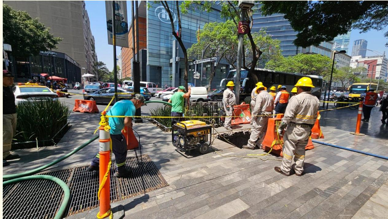
Por parte de la Autoridad del Centro Histórico en coordinación con compañeros de CFE se apoya con un generador eléctrico y una bomba sumergible para drenar la Boveda Eléctrica y recuperar la rejilla tipo Irving; se bombeo aproximadamente 8,000 Lts
