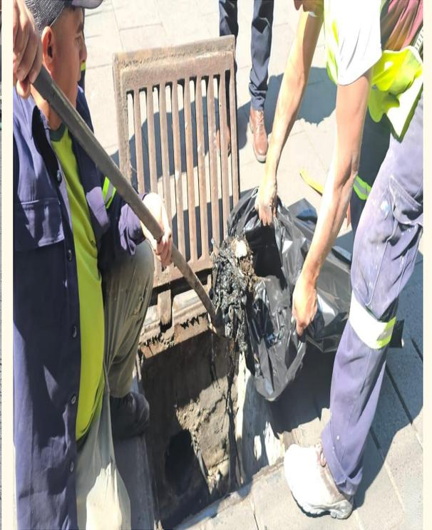
Se realiza trabajo de desazolve de drenaje pluvial de 35 metros lineales y limpieza de atarjea 20 metros lineales; limpieza de 1 rejilla pluvial retirando 1.25 m<sup>3</sup> de azolve
