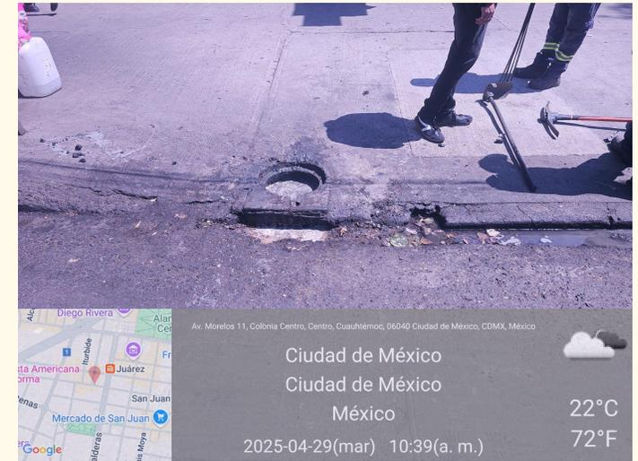
Se realizan trabajos de limpieza y desazolve en un accesorio pluvia, rejilla de piso retirando aproximadamente .10 m<sup>3</sup> de azolve y 2 metros lineales de atarjea; Se dejó limpio y operando al 100%
