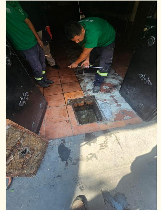
Se realizó retiro de azolve de 12 metros lineales de atarjea y un registro recolectando .20 m<sup>3</sup> de azolve dejándolo limpio; posteriormente se trabajó en predio #23 en atarjea de descarga hacia drenaje principal el cual se encuentra colapsado por lo cual no se logró destapar
