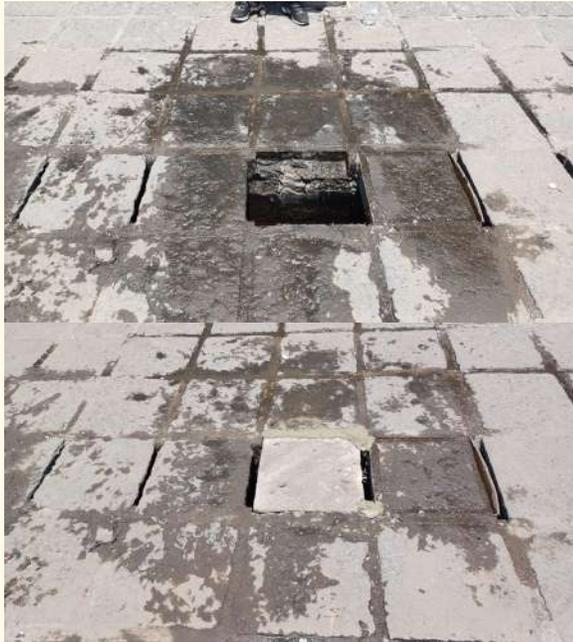
Mantenimiento de dren pluvial con colocación de loseta y retiro de residuos
