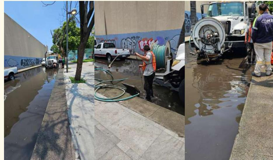
Limpieza y desazolve de tres rejillas y se sondeó 50 Metros Lineales de Atarjea
