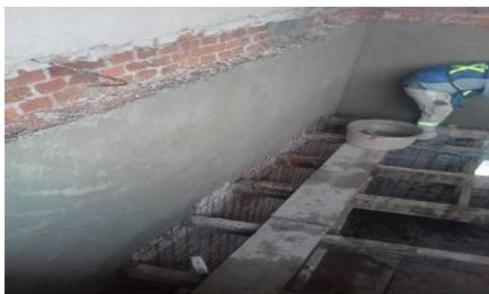
REINTEGRACIÓN DE APLANADOS EN MUROS REFORZADOA CON MALLA ELÉCTROSOLDADA
