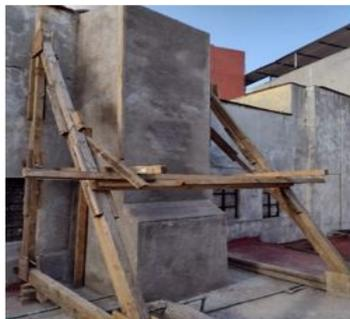
INTEGRACIÓN DE CONTRAFUERTE DE TABIQUE ROJO RECOCIDO ASENTADOS CON CEMENTO- CAL- ARENA
