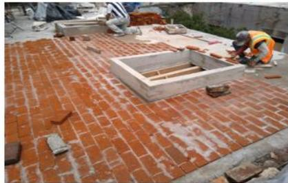
REINTEGRACIÓN DE ENLADRILLADO DE CUBIERTA
