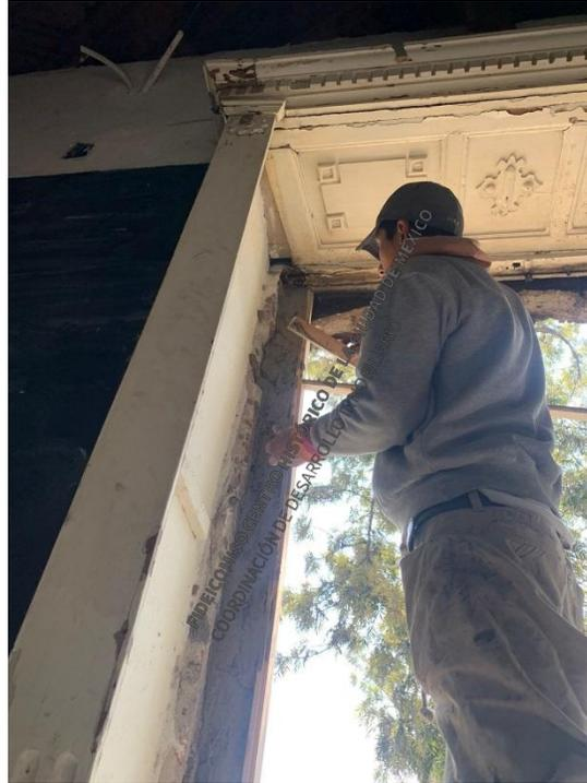
Bucareli No. 69: Integración de marcos de madera para la sustitución de carpinterías deterioradas.
