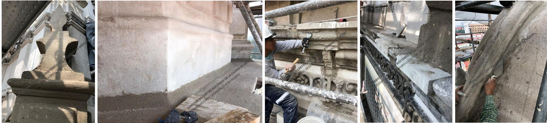
Remoldeo de elementos ornamentales a base de mampostería de tabique, integración de chaflanes y detallado de aplanados; e integración y moldeo in situ de elementos de cantera en cornisas.
