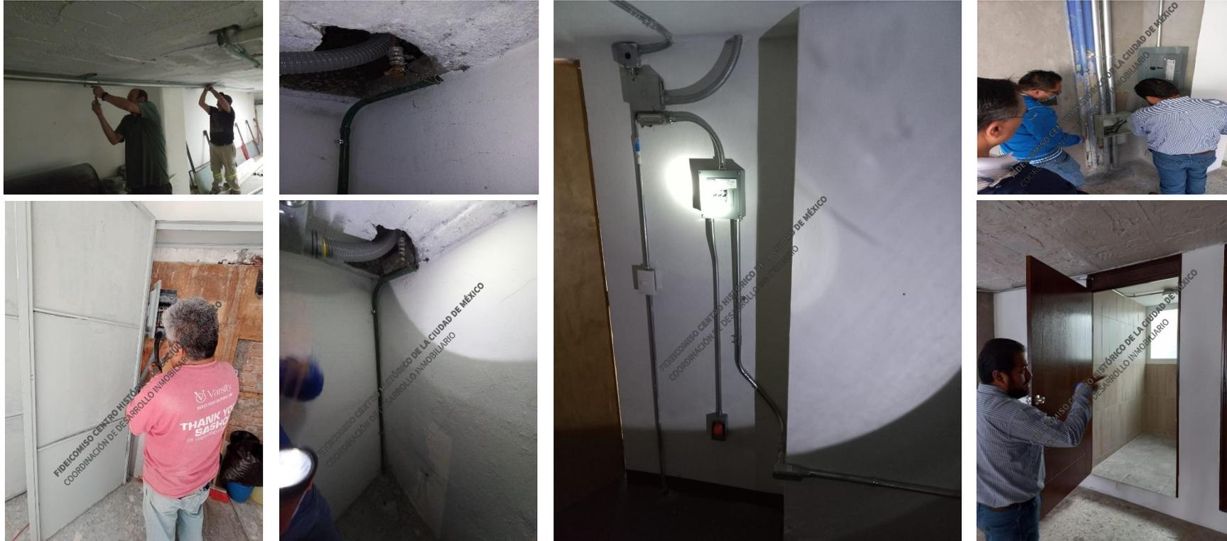
Continuación de trabajos de colocación de cableado para instalación de energía eléctrica regulada. Recorrido de verificación de instalaciones de corriente regulada y eléctricas complementarias en general.
