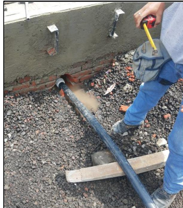
Colocación de manguera de 2" con su COUPLE adaptador en el crucero #15 .
