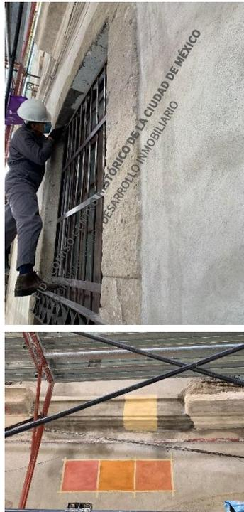
**Ecuador 103:** Tratamiento integral de herrerías y muestras de pintura a la cal para autorización de supervisión técnica del INAH.
