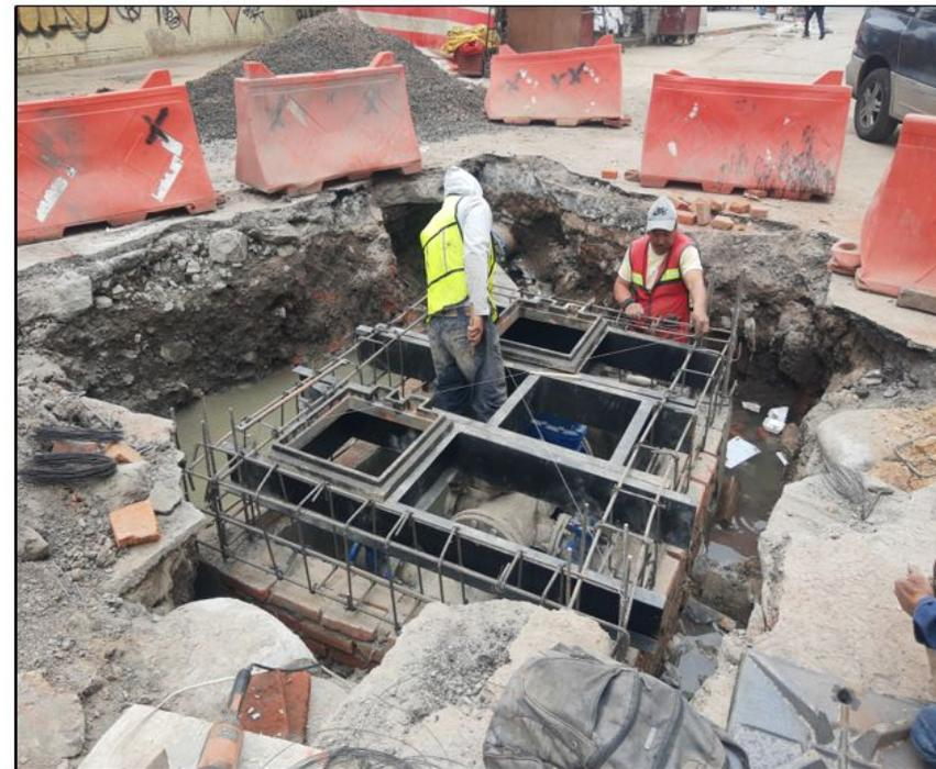
Trabajos de construcción de caja de válvulas sobre calle Comonfort entre las calles de Republica de Ecuador y Órgano.
