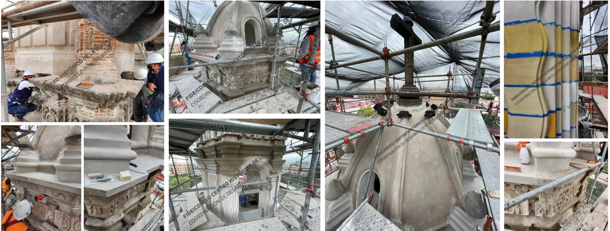
Trabajos de remoldeo en frisos de torre campanario y pruebas de pintura a la cal.
