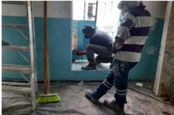
**Desmontaje de puertas de herrería para su rehabilitación, aulas planta alta.**
