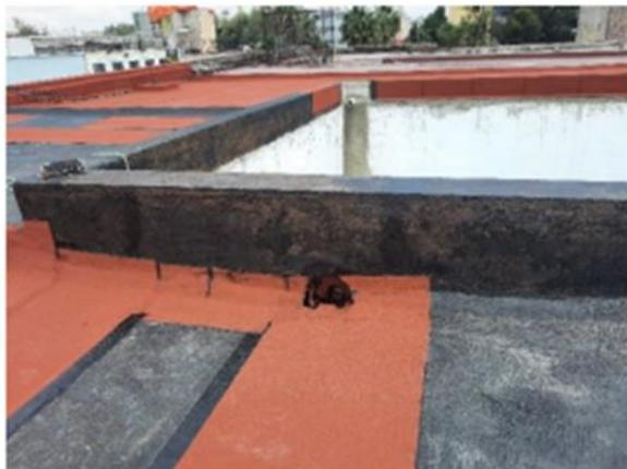
Se concluyeron los trabajos de impermeabilización coladeras de pretil para bajadas pluviales de azotea.
