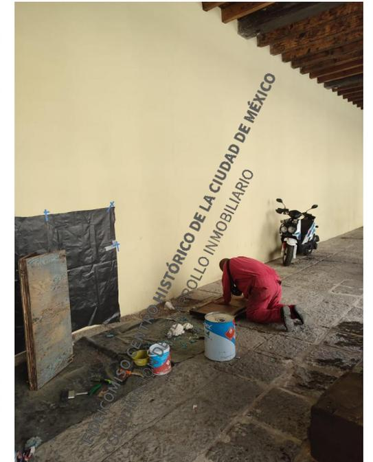
Mantenimiento a muebles del Portal: liberación de capas de pintura deteriorada, aplicación de tinta al alcohol, rehabilitación o cambio de bisagras y aplicación de barnizado final.
