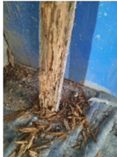
**Sustitución de vigas en mal estado en aulas planta alta.**
