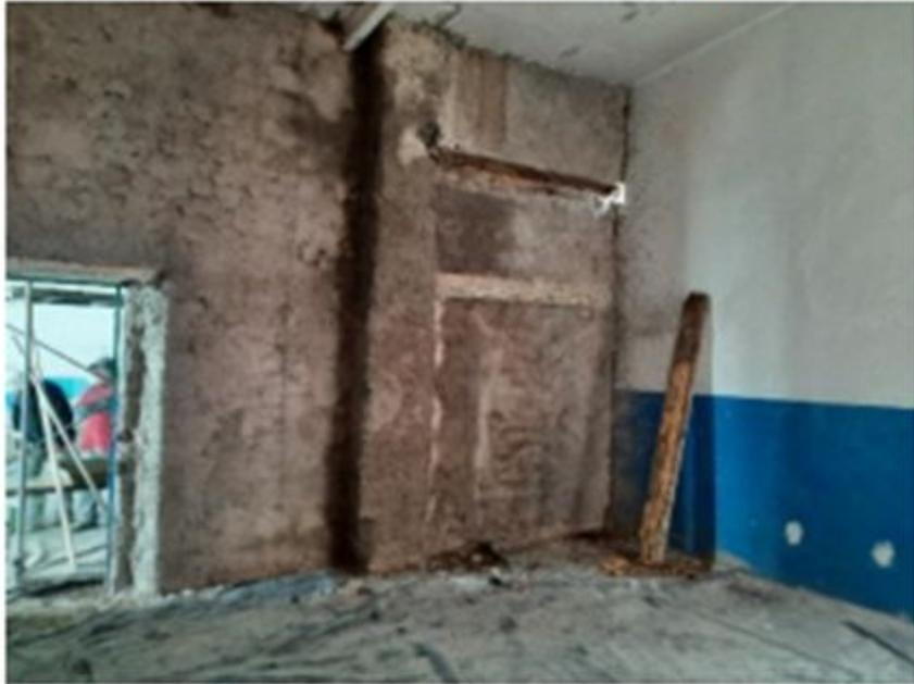
**Trabajos de aplanado en aulas planta alta con sustitución de vigas en mal estado.**
