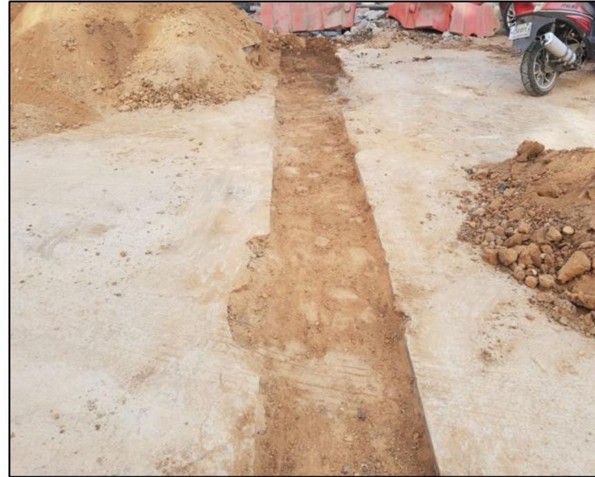
Cajeo para tendido de asfalto en la calle de Comonfort
