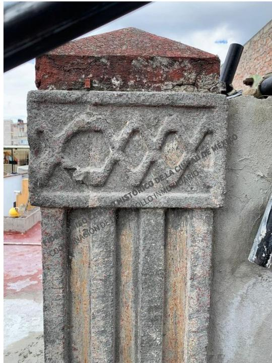
**Rep. de Chile 64:** Retiro de pintura en elementos prefabricados.
