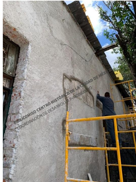
**Obraje 14:** Perfilado de marcos de cantera y emboquillado de vanos.
