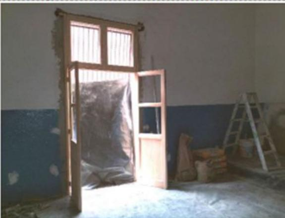
Se iniciaron trabajos de colocación de cancelería de madera en aulas planta alta.
