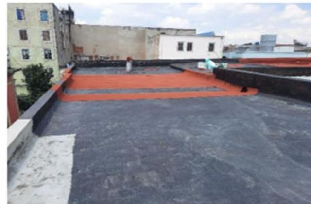
**Se concluyeron los trabajos de preparación de la superficie de azotea, para recibir impermeabilizante.**
