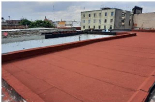
**Avance de trabajos de impermeabilizante en pretilos de azotea del patio principal.**
