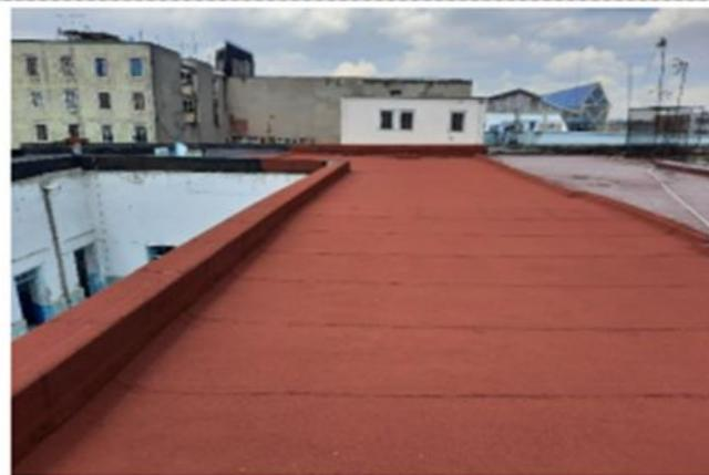
**Colocación de impermeabilizante en edificio de aulas.**
