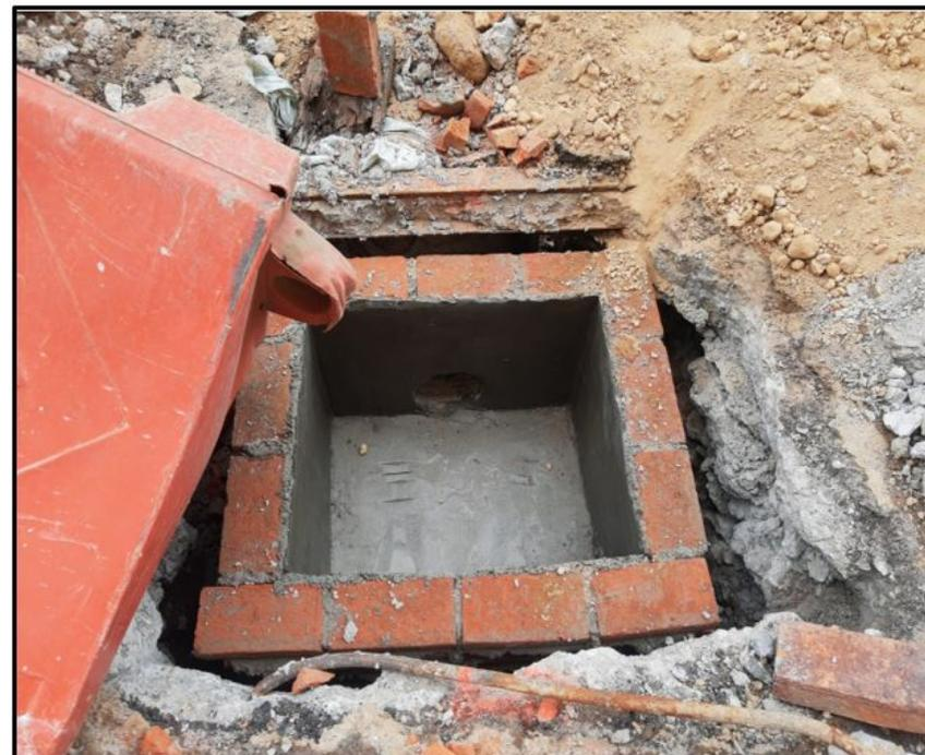
Construcción de registros de tabique rojo para aguas pluviales en la calle Comonfort.
