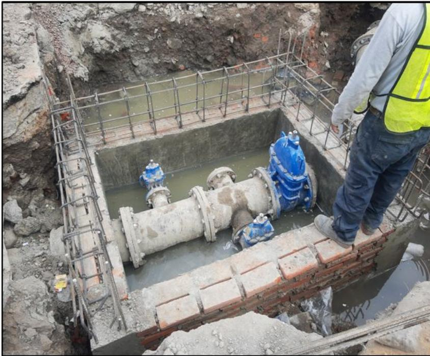
Trabajos de construcción de caja de válvulas en el crucero #15 sobre calle Comonfort entre las Calles de Republica de Ecuador y Órgano.
