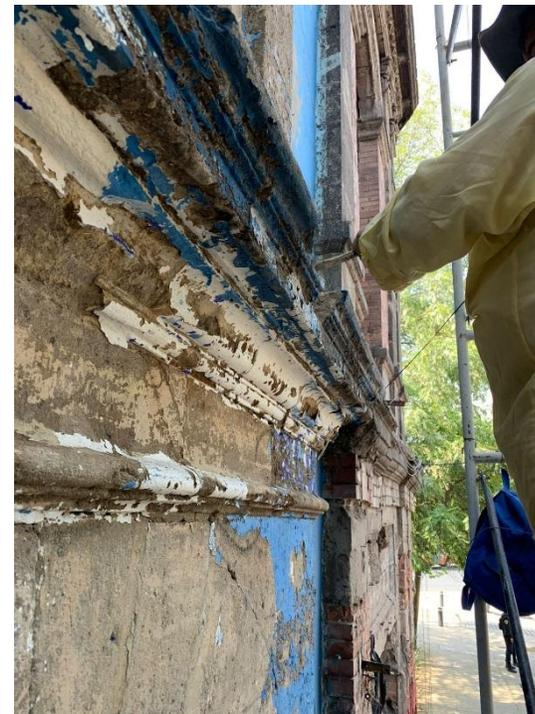
**Liberación de pintas vandálicas en ventanas de herrería y carpinterías. Retiro de sillares deteriorados y liberación de pintura en elementos de cantera.**
