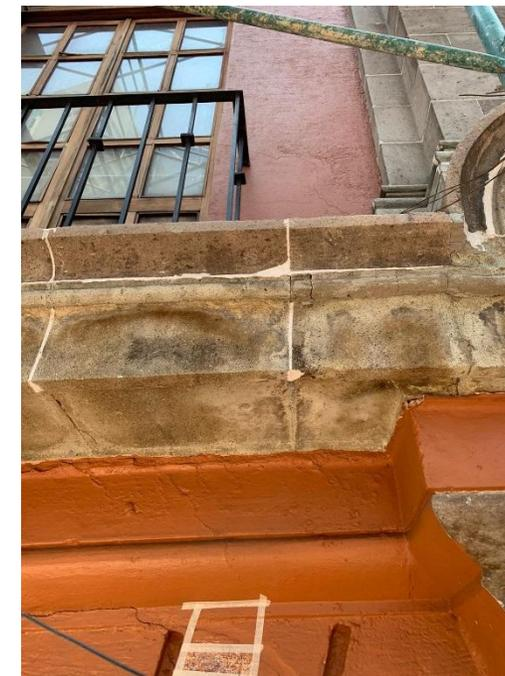
Reintegración de juntas y remoldeo de elementos de cantera. Liberación de pintas vandálicas.
