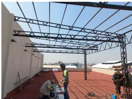
Habilitado y colocación de refuerzos y complementos en estructura de techumbre en azotea.
