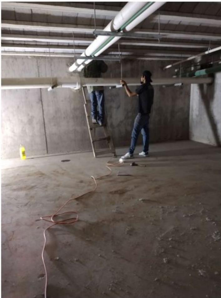
CONEXIÓN DE TUBERÍA SUBTERRANEA PARA EL LLENADO DE CISTERNA
