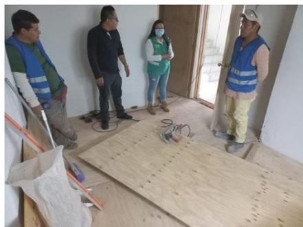
Habilitado y colocación de doble cama de triplay para piso de cabina de controles de audio y video en auditorio.
