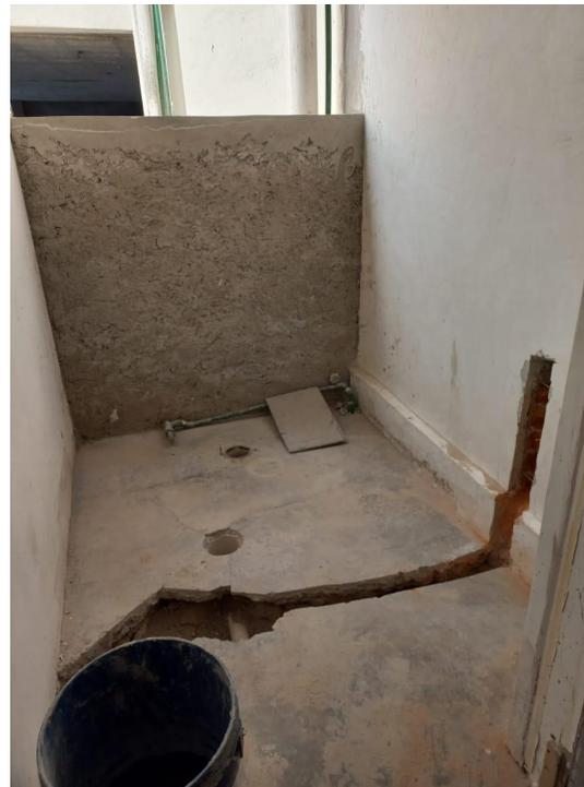
Ranurado para colocación de instalaciones hidrosanitarias y eléctricas en baños de azotea.
