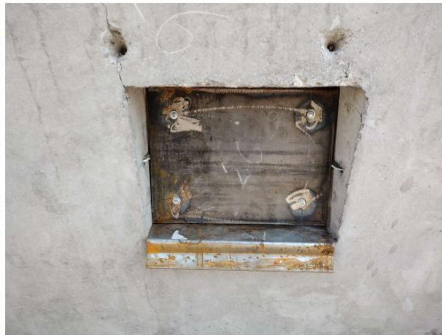
**COLOCACIÓN DE TAPA DE PLACA DE ¼" DE HERRERÍA PARA EL HUECO DE LUMINARIAS.**
