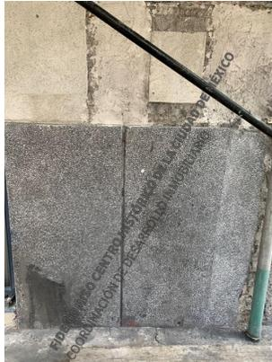
**Bucareli No. 152:** Colocación de muestras para recuperación de granito en planta baja.
