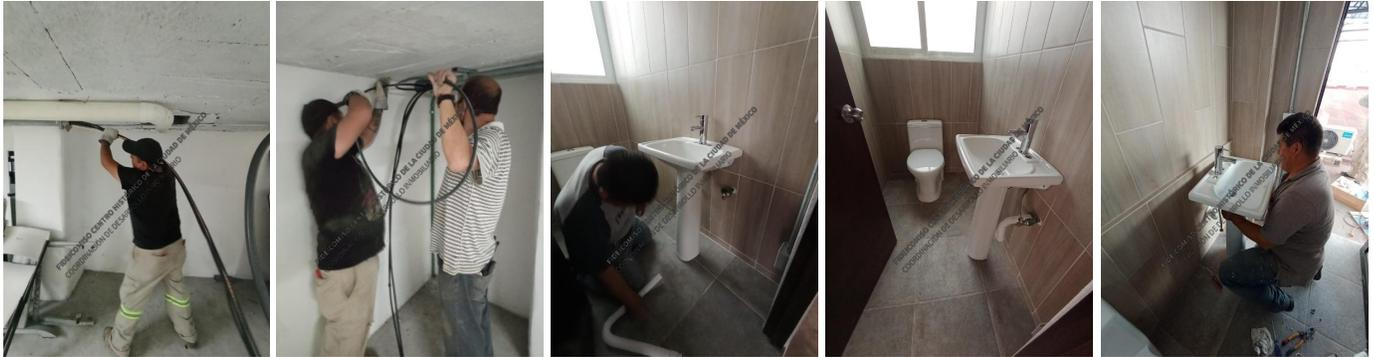
Trabajos de colocación de cableado para instalación de energía eléctrica regulada para el auditorio. Colocación de muebles sanitarios en núcleos de baños de nivel dos y en sección sur de azotea.
