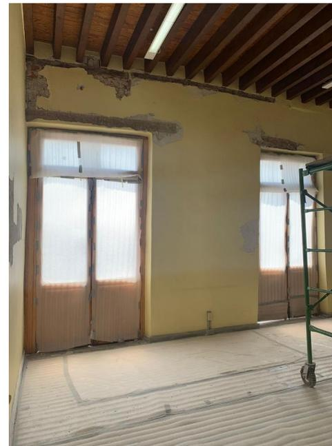
Retiro de aplanados en muros afectados por grietas en segundo nivel.
