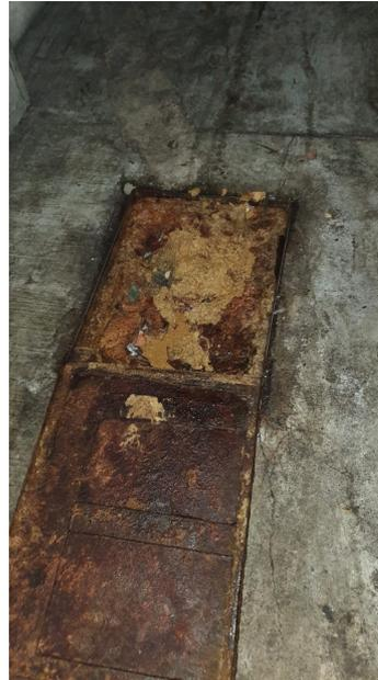
Se realizó desazolve en Roldán frente al No. 45, se limpió pero no se pudo retirar el tapón se requiere romper banquetta para buscar el tubo tapado o colapsado, 19 de abril de 2024
