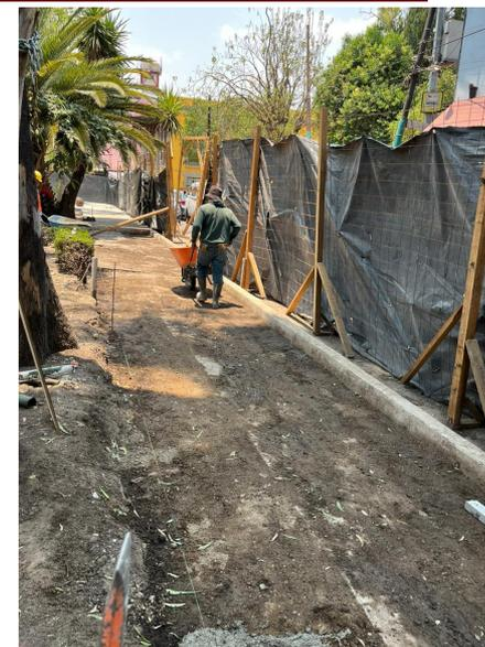
Demolición de piso de mosaico y firme de concreto, suministro y colocación de plantilla de concreto  $f'c= 150 \text{ kg/cm}^2$
