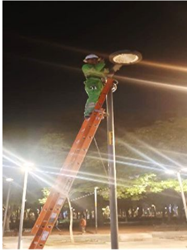
REEMPLAZO DE BALASTRO Y FOCO
