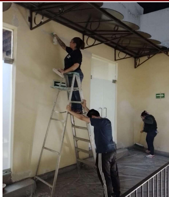
Explotación de gustas y grietas en corredor exterior. Oriente segundo nivel y cierre muros de esquina en interior de crujía oriente en primer nivel
