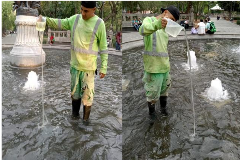
APLICACIÓN DE QUÍMICOS: ALGUICIDA, HIPOCLORITO Y CLARIFICADOR
