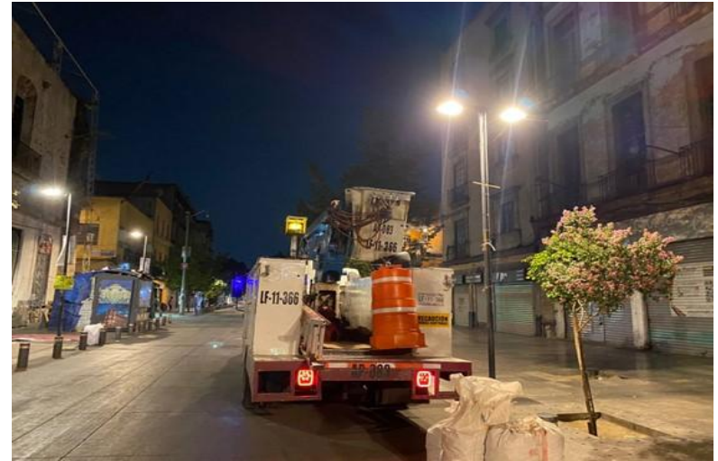
RECONEXIÓN DE LÍNEAS DE ALIMENTACIÓN
