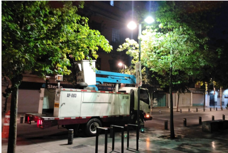
CAMBIO DE LÁMPARA Y BALASTRO
