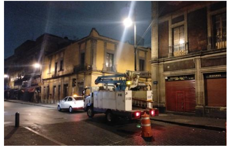
CAMBIO/INSTALACIÓN DE LÁMPARA
