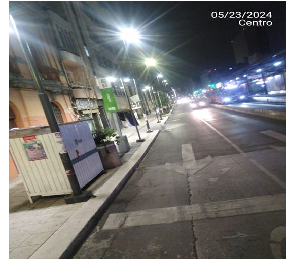
Reparación de circuito en Balderas entre Morelos y Ayuntamiento
