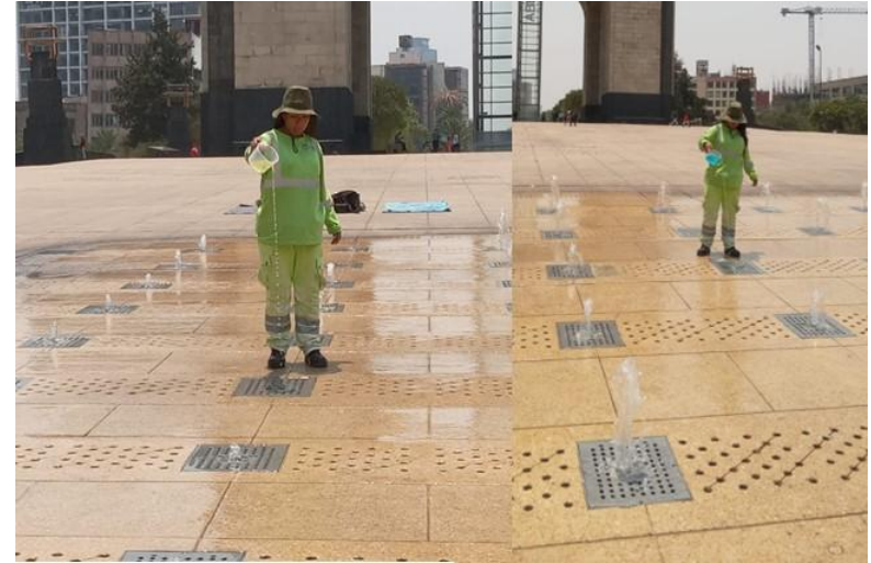
APLICACIÓN DE QUÍMICOS: ALGUCIDA, HIPOCLORITO Y CLARIFICADOR
