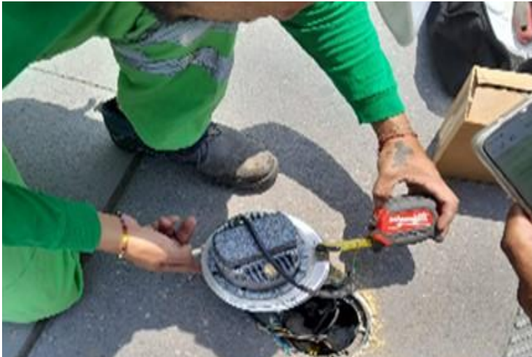
MEDICIÓN E INSTALACIÓN DE PROYECTORES
