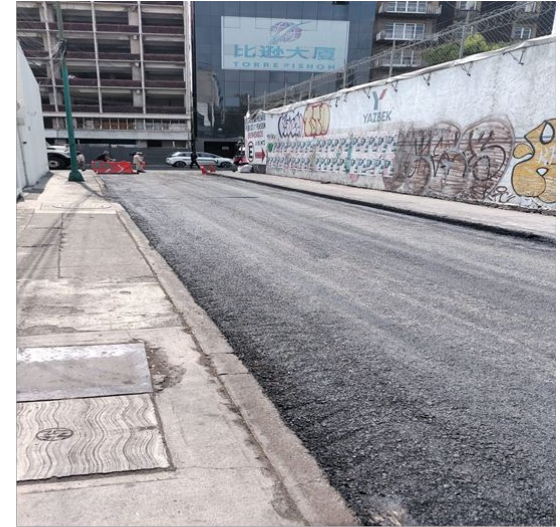
Repavimentación de la calle San Salvador el Verde
