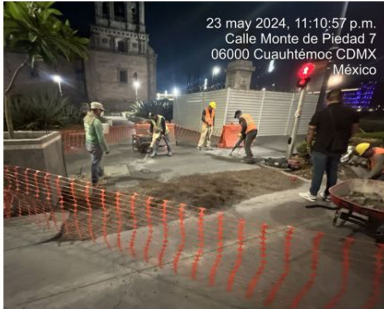
UBICACIÓN: FRENTE A CATEDRAL, ZÓCALO, CIUDAD DE MÉXICO. (INICIA DEMOLICIÓN PARA RENIVELACION DE RAMPA PEATONAL EN EMPEDRADILLO)
