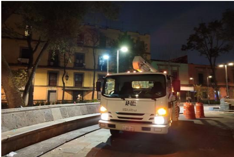
CAMBIO DE LUMINARIA
