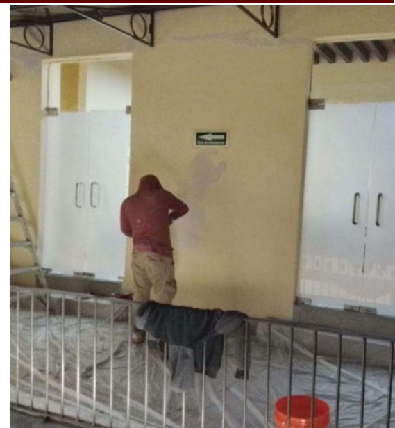
Aplicación de pintura en muros
