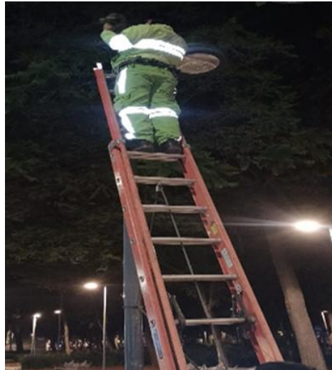
REEMPLAZO DE BALASTRO
