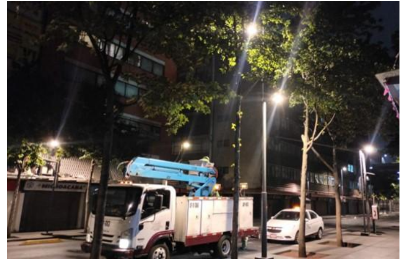
CAMBIO/INSTALACIÓN DE LÁMPARA
