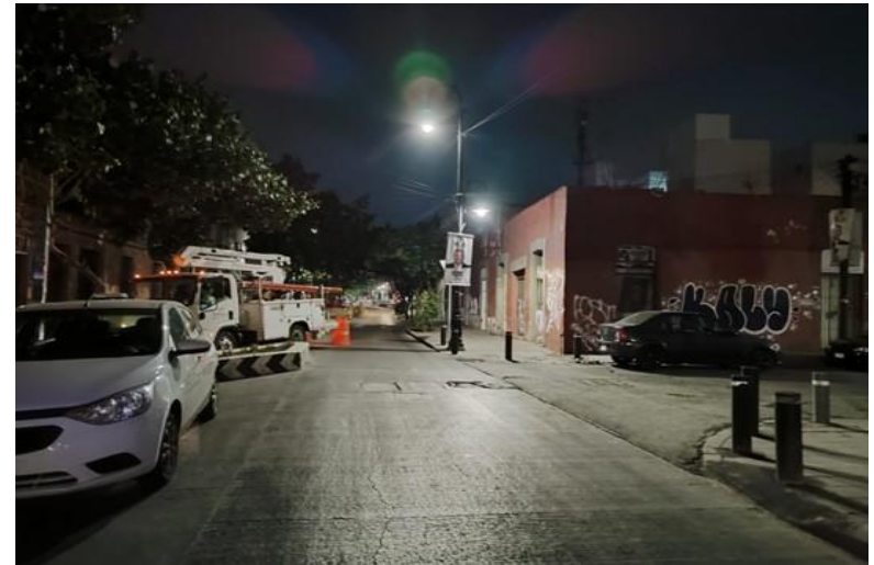
RECONEXIÓN DE LÍNEAS DE ALIMENTACIÓN
