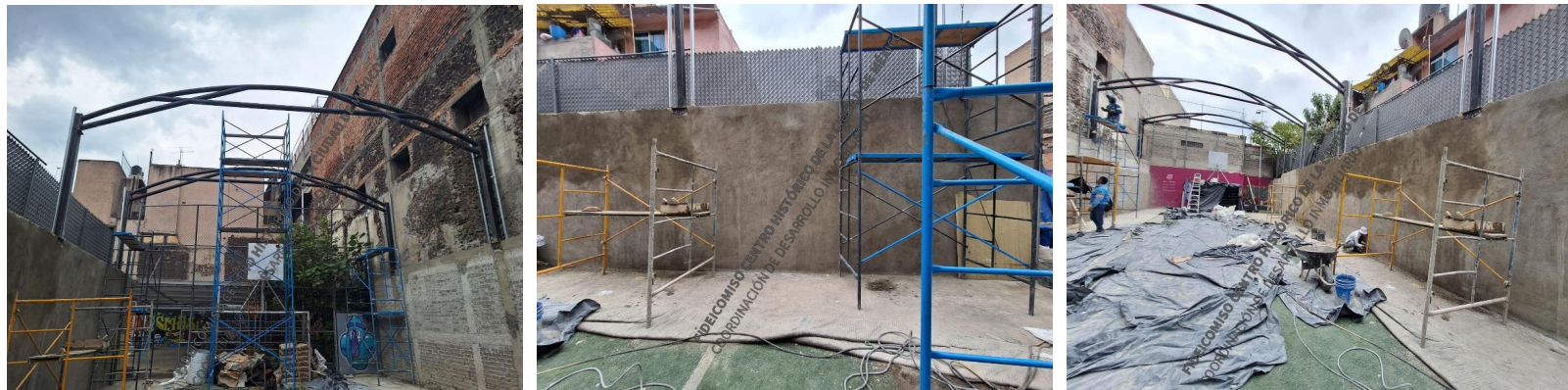
Instalación de estructura metálica de cubierta y aplicación de aplanados en muros.
