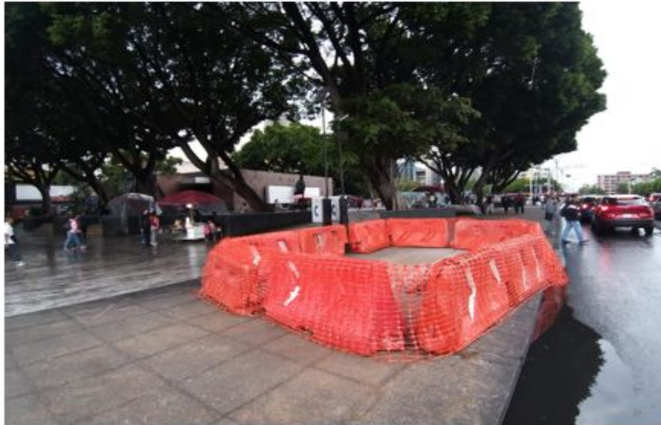
1. Se continúa con los trabajos de excavación por medios manuales, para ubicar el eje de la red primaria y la red secundaria.
