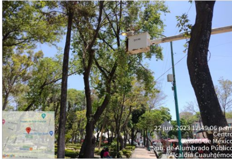
Reconexión de circuito y cambio de luminario en la Ciudadela
