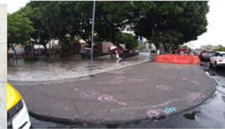
3. Marcado preliminar de interferencias
