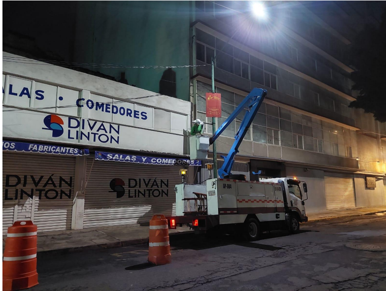
COLOCACIÓN DE COMPONENTES
