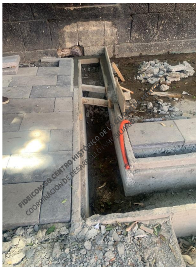
Elaboración de canal de captación de agua pluvial, descimbrado.
