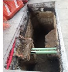
2. Sondeo actual de 3.0m * 1.0m * 1.70m de profundidad
