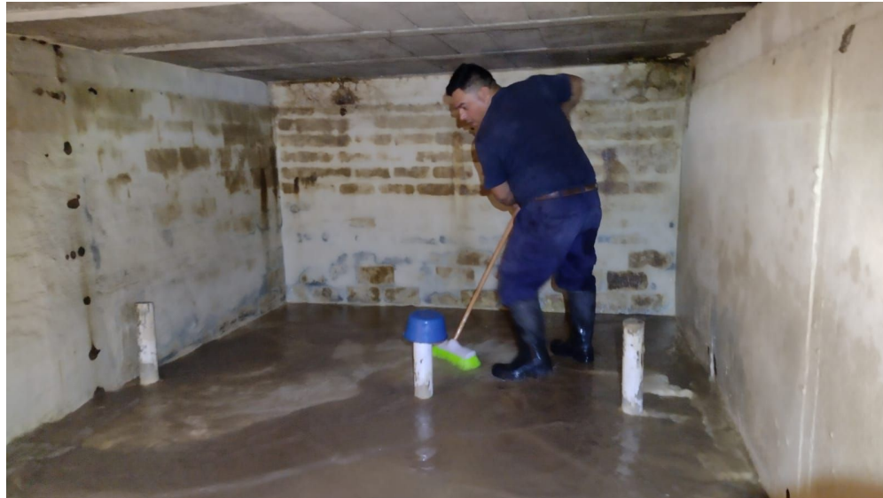
Se realizó lavado de 1 cisterna de 31,000 litros, en Lerdo No. 13, Col. Guerrero, 23 de junio de 2023.
