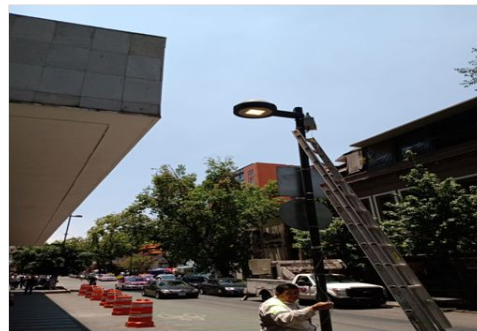
Reparación de luminaria sobre calle Independencia
