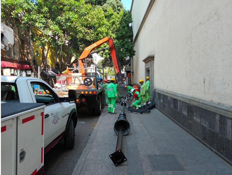
INSTALACIÓN DE COMPONENTES Y RECONEXIÓN DE LÍNEAS DE ALIMENTACIÓN
