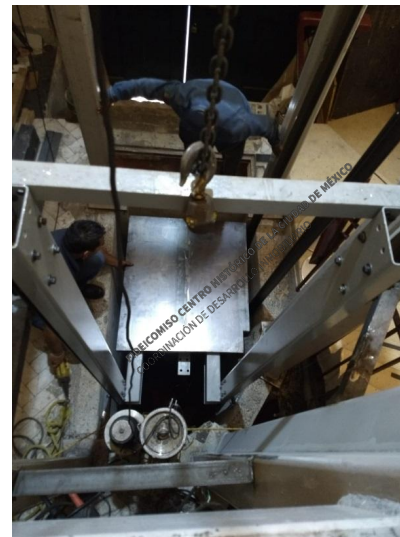
Colocación de plataforma ascendente para la colocación de traves de anclaje y guías.
