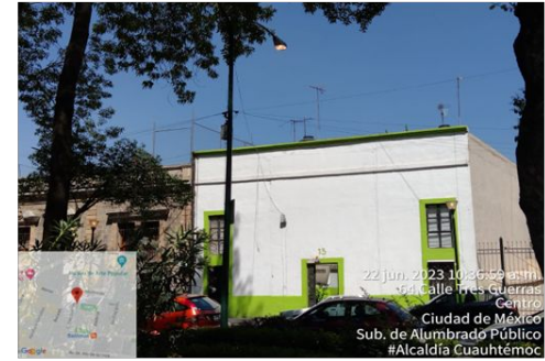
Cambio de luminario en calle Tres Guerras
