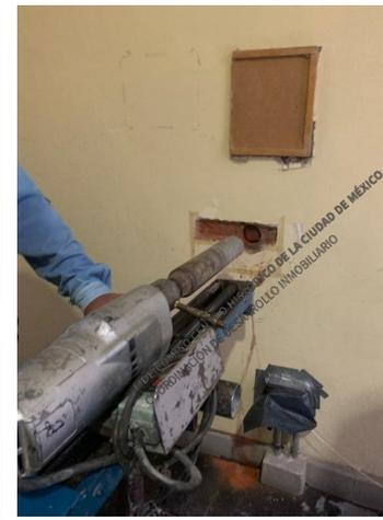
Extracción de corazones de muros y calas en piso y cubiertas.
