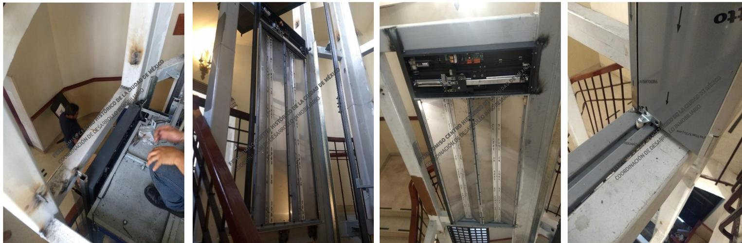
Colocación de puertas de apertura en cada nivel, inicio de instalación de cabina, preparación de estructura para la colocación de herraje de cristal templado.
