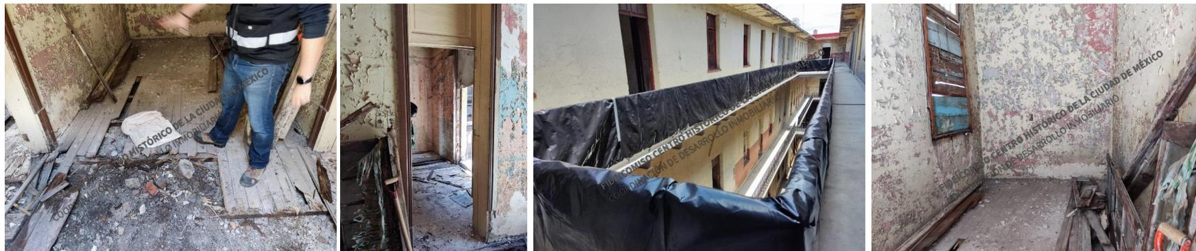
Trabajos preliminares, protección de barandales y se empieza con el desmantelamiento de entrespiso.
