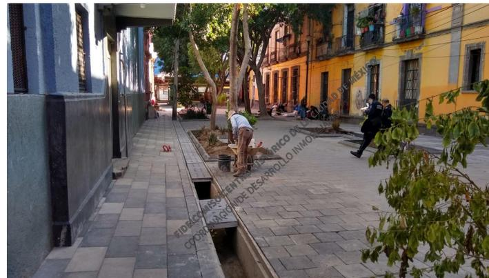
Colocación de adocreto en banqueta, colocación de adocreto multiporoso en dren de desagüe pluvial, colocación de adocreto en rampa de acceso al Callejón.
