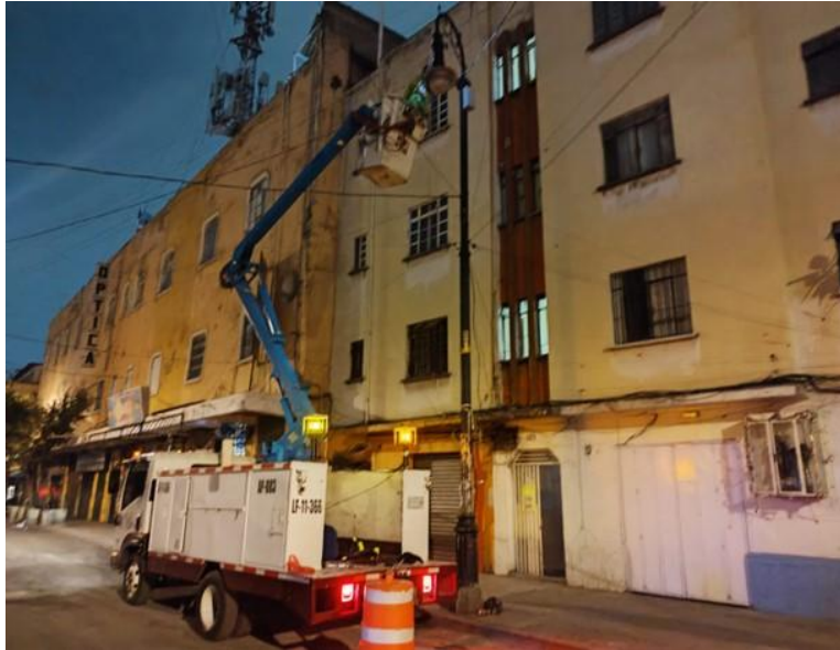
CAMBIO DE BALASTRO, SOCKET Y LUMINARIA
