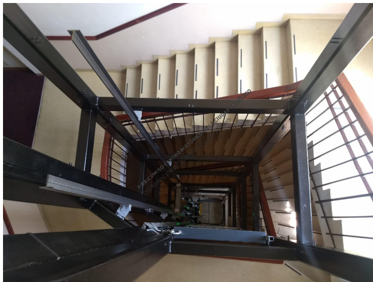
Soldadura de soportes de elevador con estructura, pruebas y puesta en marcha del elevador.
