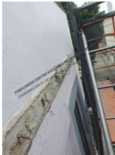
Liberación de EMPASTES DE CEMENTO DETERIORADOS EN CORNISAS Y BALCONES
