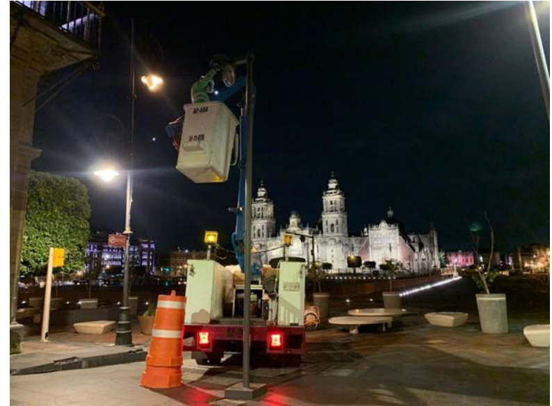
CAMBIO DE BALASTRO, SOCKET Y LUMINARIA
