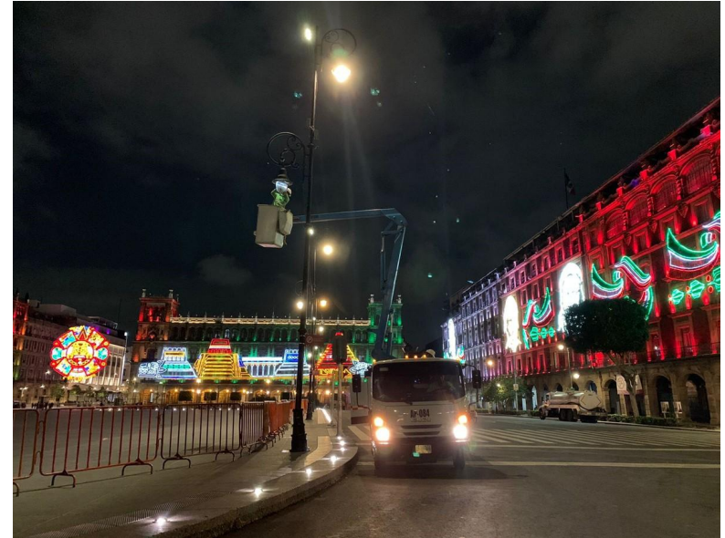
CAMBIO DE LUMINARIO
