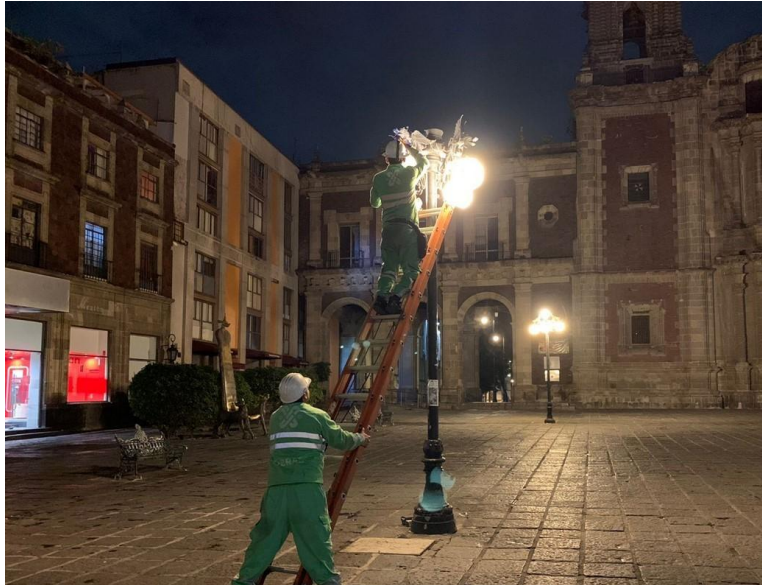
CAMBIO DE BALASTRO
