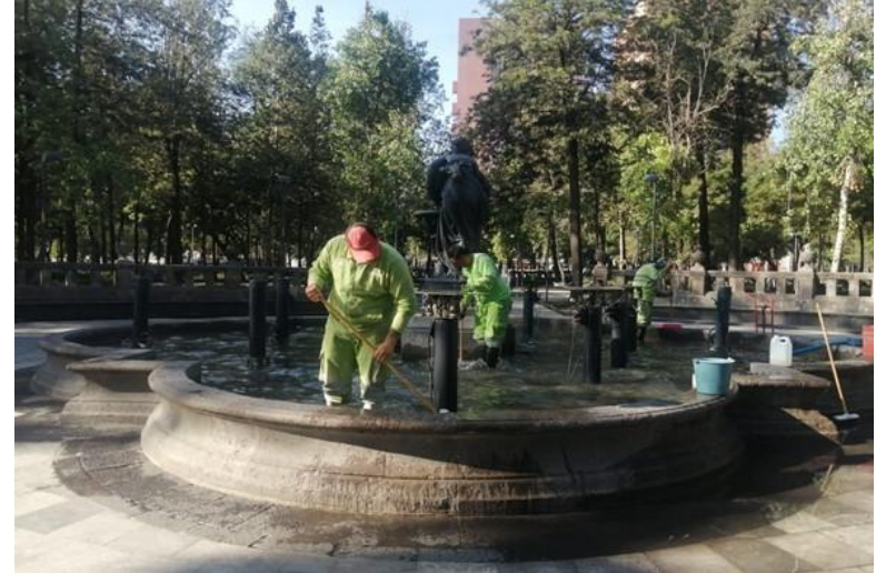
VACIADO, LAVADO PROFUNDO Y POSTERIOR LLENADO DE LA FUENTE
