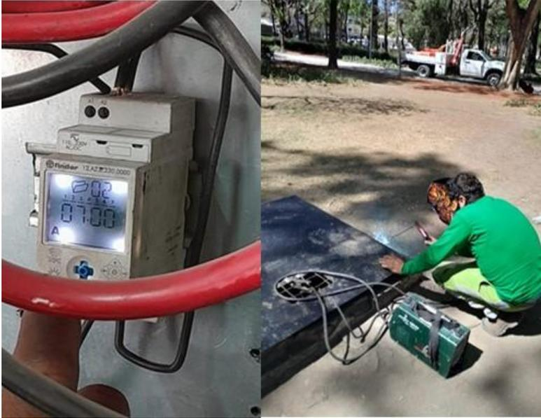
SE ABRE BOVEDA HIDALGO Y JUAREZ, SE PROGRAMA RELOJ DE ENCENDIDO A LAS 7:00 Y APAGADO A LAS 18.20 PM
