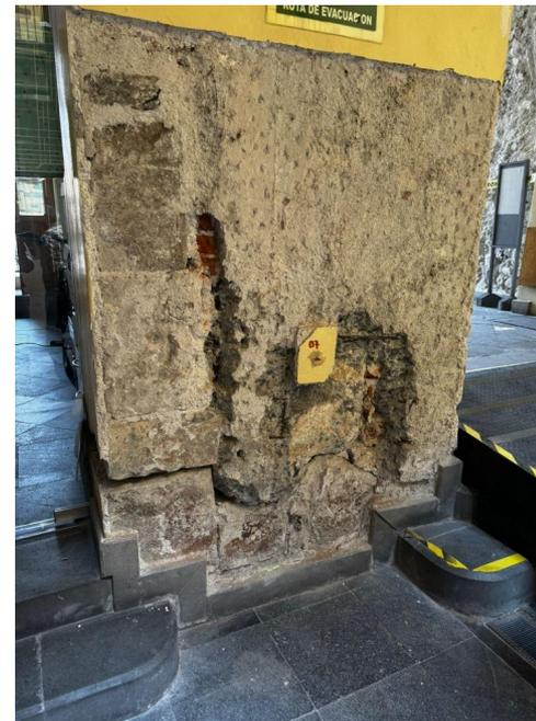
Liberación de aplanados en muros para determinar afectaciones en fábricas
