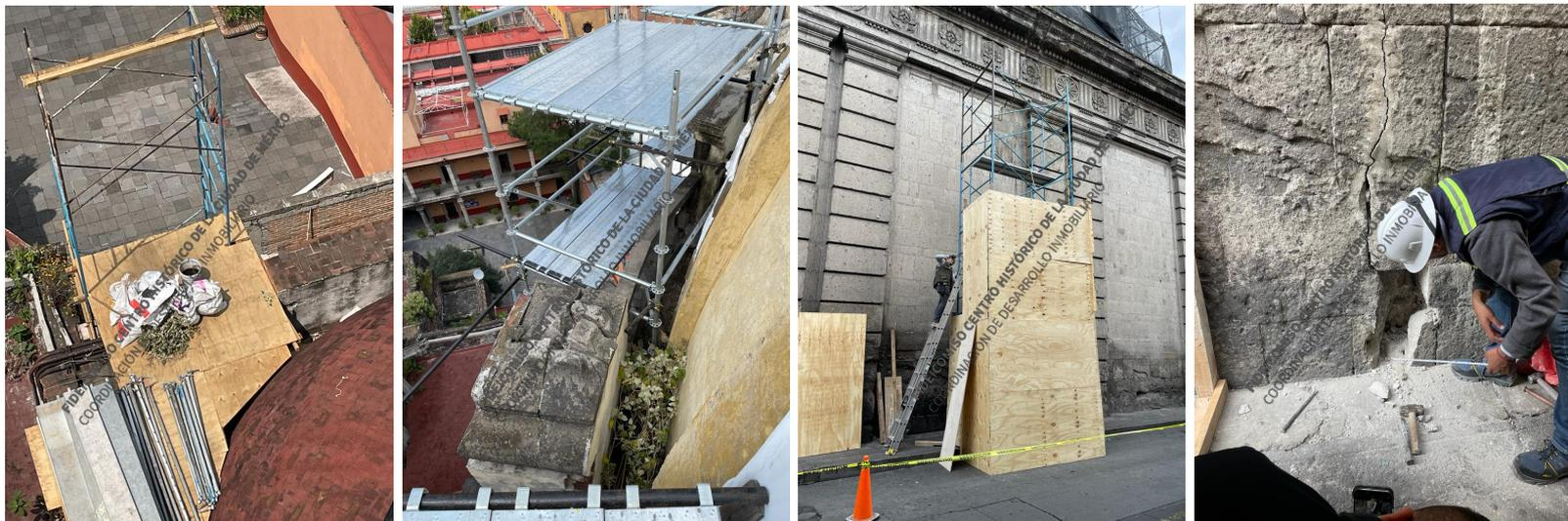
Retiro de escombros en cúpula y liberación de material dañado en grieta exterior.
