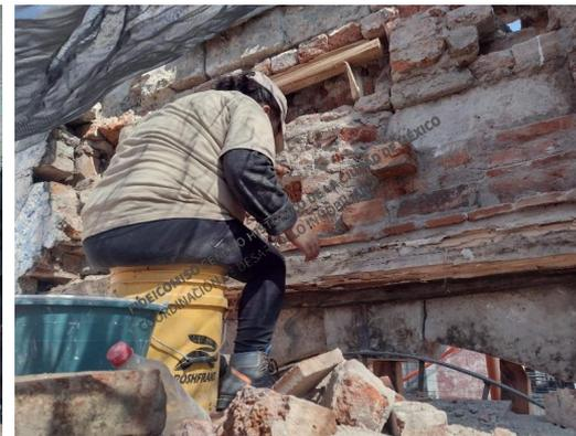
Liberación de aplanados deteriorados, tratamiento integral de herrería, consolidación de arco de acceso y muro interior.
