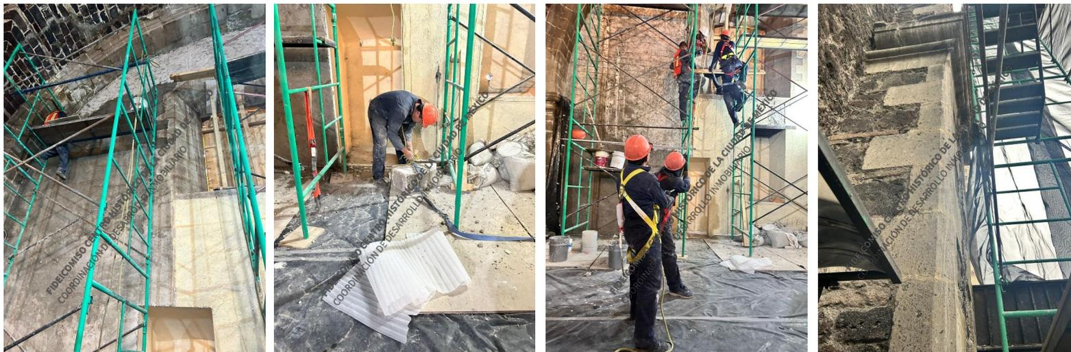
Trabajos de reintegración de aplanados en muro sur del coro, retiro de dovelas de cantera desfasadas en marco de ventana, para su posterior reintegración, avance en trabajos de bajantes pluviales de fachada sur, con reintegración de tezontle para cierre de caja, Revisión con restauradores de CENCROPAM, de los trabajos a realizar en mural a alto relieve "La mano de Dios" de Matias Goeritz.
