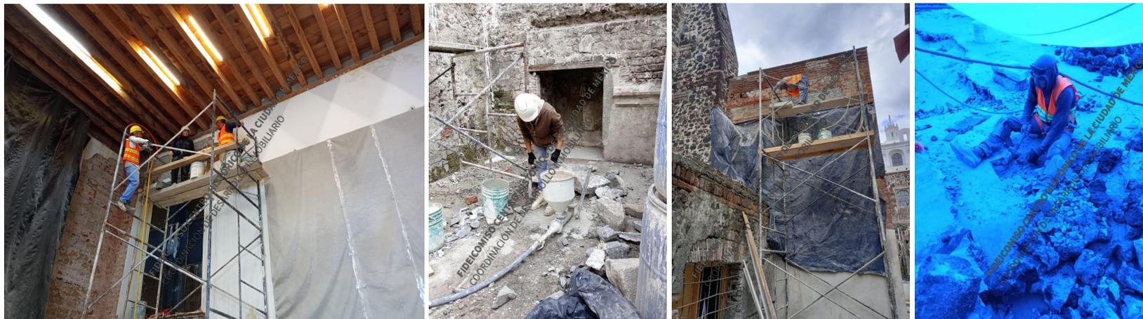
Trabajos de consolidación de muros mediante el cocido con materiales similares a la fabrica, interiores y exteriores, inyección de mortero fluido, de capillas. En capilla del Sagrado Corazón se continua la consolidación de bóveda extradós, mediante cocido de grietas.
