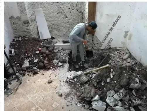
Trabajos de aplanado en muros consolidados, excavación de pozos a cielo abierto para exploración de cimentación en habitaciones y patio central, siendo el de mayor profundidad de 4 metros de profundidad.
