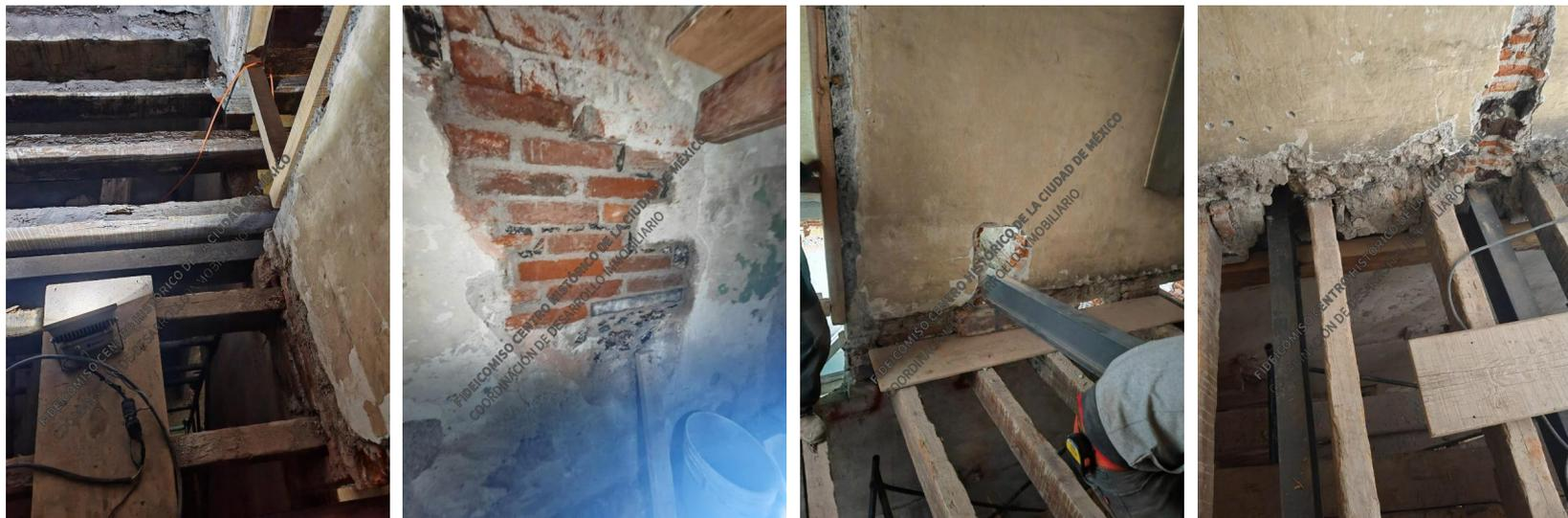
Trabajos de consolidación de coronas de muros para recibir vigas de acero, colocación de vigas de acero y consolidación de mechinales.
