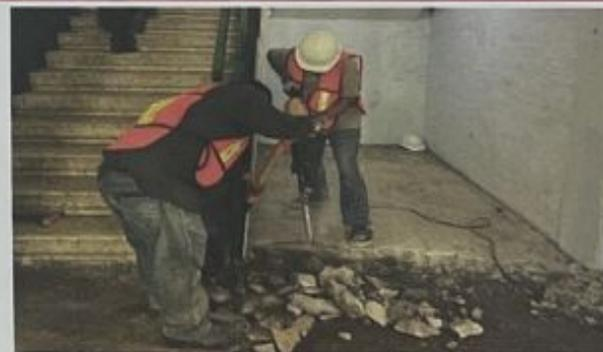
SE CONTINUA DESENCOFRADO DE COLUMNAS EN EDIFICIO 6 PARA REFORZAMIENTO .
