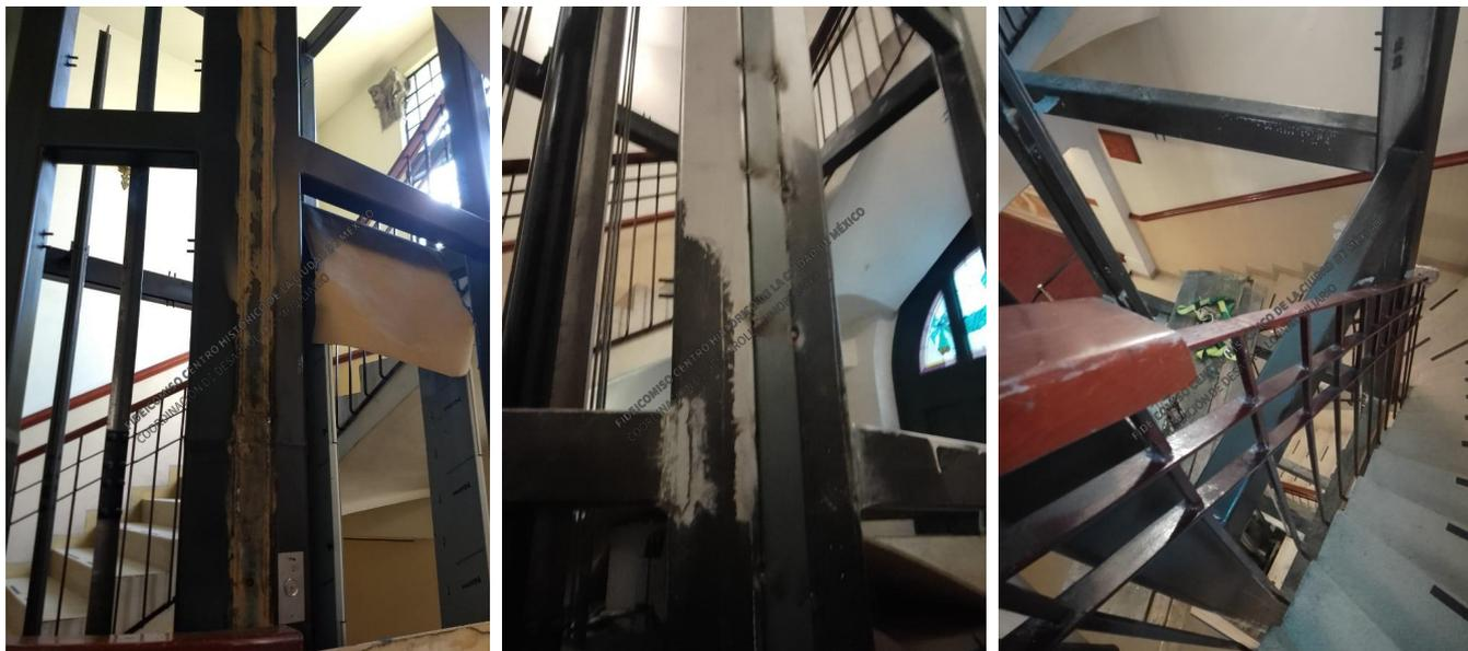
Aplicación de pintura en estructura metálica y colocación de cristales sobre perfiles.
