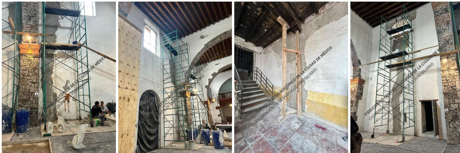
Trabajos de reintegración de aplanado grueso en muros para posterior colocación de aplanado fino y pintura, inicio de trabajos de reforzamiento estructural en muro colindante con claustro.
