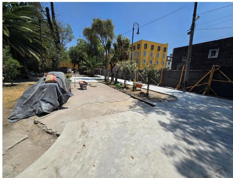
Colado de concreto para pavimento y realización de acabado buzardeado.
