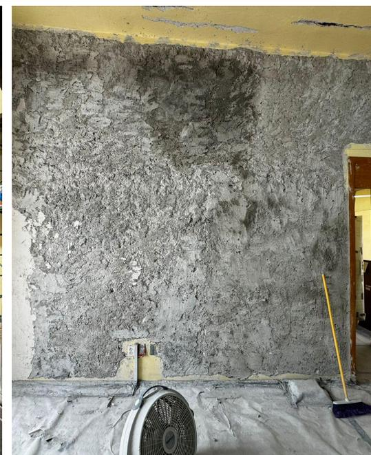
Se continúan trabajos de consolidación de grietas en muros de crujía oriente de inmueble de Argentina 8
