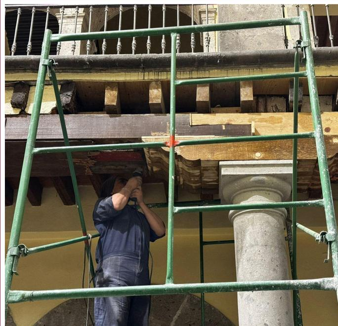
Se concluyen trabajos de colocación de zapata de Madera y tratamiento de conservación de madera de toda la vigería de planta baja en patio
