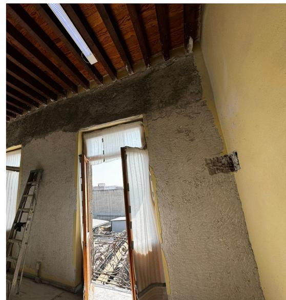
Continúa el retiro de aplanados en muros afectados por grietas en segundo nivel, así como la aplicación de aplanado en áreas atendidas.
