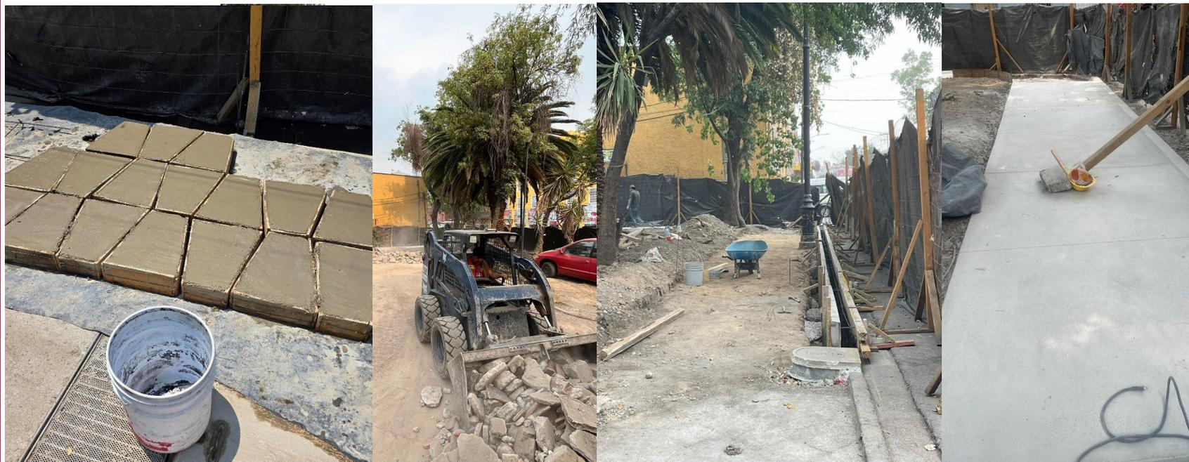
Elaboración de tabiques trapezoidales para construcción de pozos de absorción, continua demolición de pavimentos, intentando recuperar plantilla para reutilizar como base y colado de concreto.
