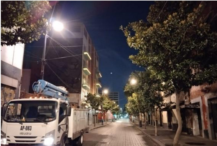
RECONEXIÓN DE LÍNEAS DE ALIMENTACIÓN
