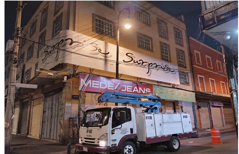
CAMBIO/INSTALACIÓN DE BALASTRO
