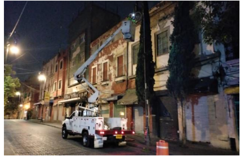
SUSTITUCIÓN DE BALASTRO
