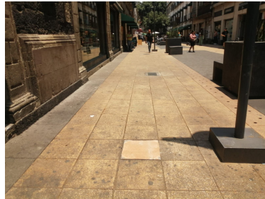
Reposición de tapa de registro en Motolinía
