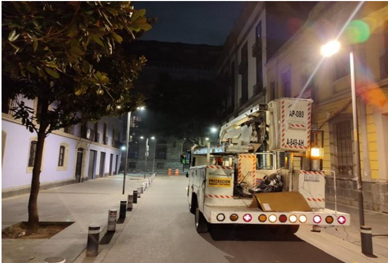
RECONEXIÓN DE LÍNEAS DE ALIMENTACIÓN
