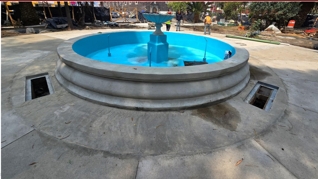
Rehabilitación de Fuente y colado de pavimento (ANTES Y DESPUÉS)
