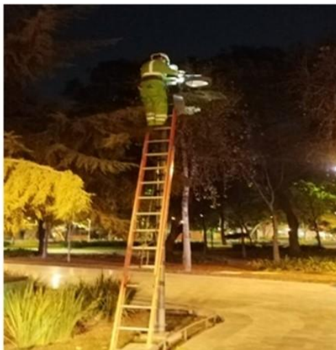
CAMBIO DE LAMPARA Y BALASTRO
