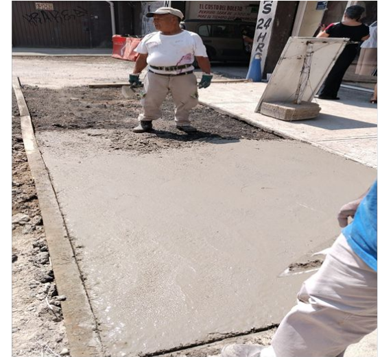
Construcción de banqueta en calle San Salvador el Verde
