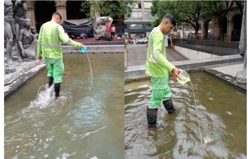
APLICACIÓN DE QUÍMICOS: ALGICIDA, HIPOCLORITO Y CLARIFICADOR
