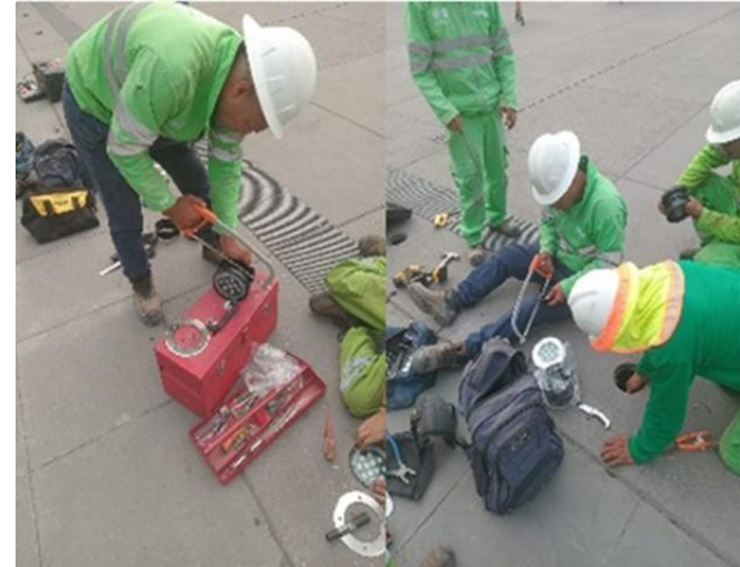
INSTALACIÓN DE PROYECTORES DE PISO
