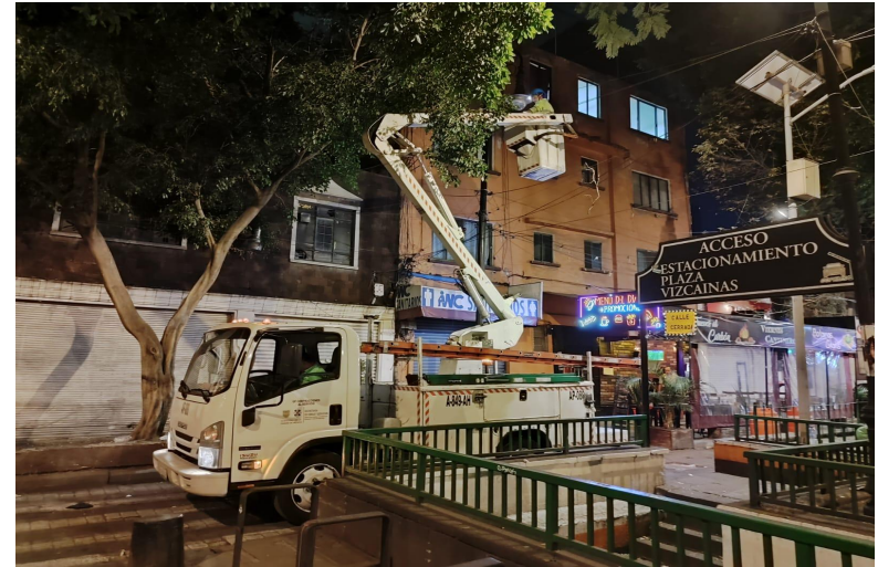
RECONEXIÓN DE LÍNEAS DE ALIMENTACIÓN
