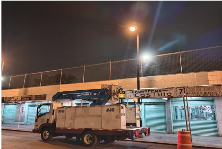
CAMBIO/INSTALACIÓN DE BALASTRO
