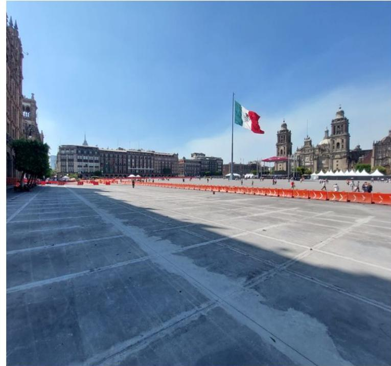
Fresado (224 m<sup>3</sup>) y renivelación mediante asfalto (273.34 m<sup>3</sup>) al 22 de Marzo de 2024.
