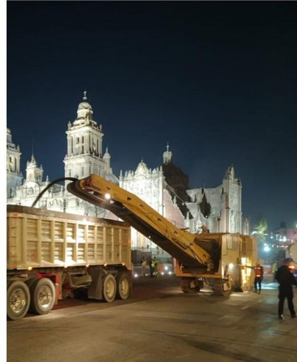
Cimbra, colado, lavado y de concreto hidráulico White Topping en el tramo sur.
