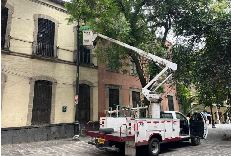
CAMBIO / INSTALACIÓN DE BALASTRO Y LUMINARIA
