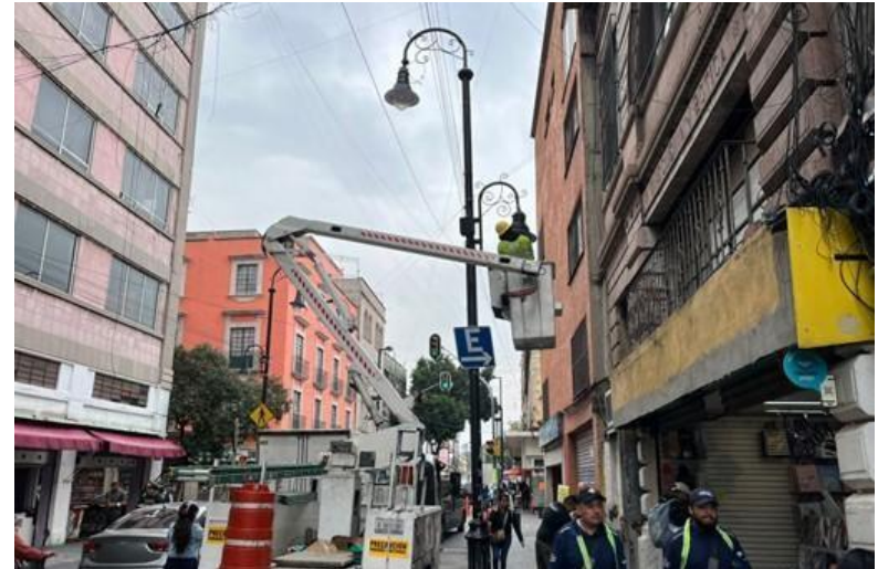
SUSTITUCIÓN DE FOTOCELDA
