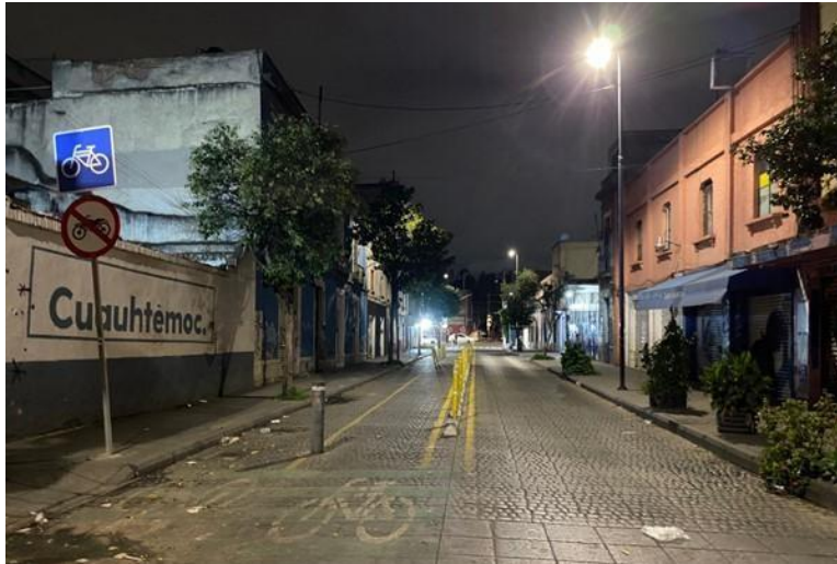
RECONEXIÓN DE LÍNEAS DE ALIMENTACIÓN
