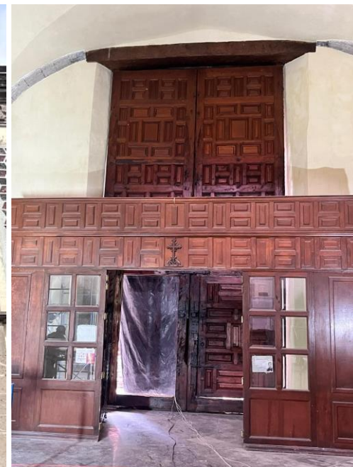
Mantenimiento y conservación de puerta monumental y cancelería de madera.
