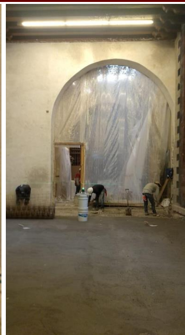
Construcción de bastidor de madera y colado de piso de concreto.
