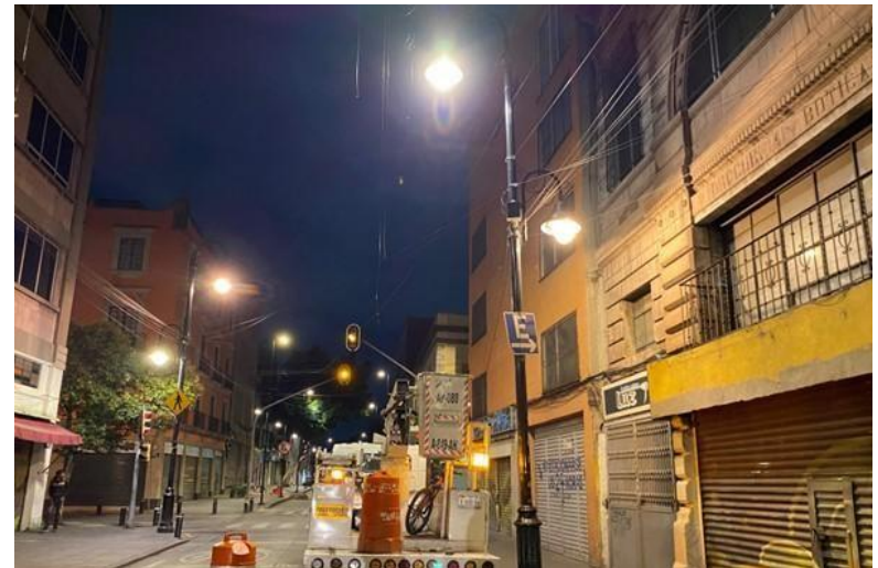
CAMBIO / INSTALACIÓN DE LÁMPARA
