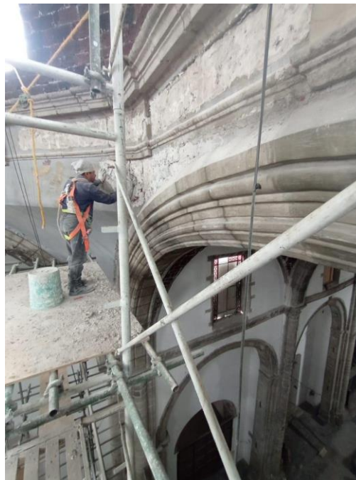
Integración de aplanado grueso en pechinas de cúpula principal
