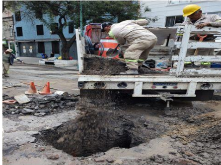
Reparación de fuga de agua en Morelos 30
