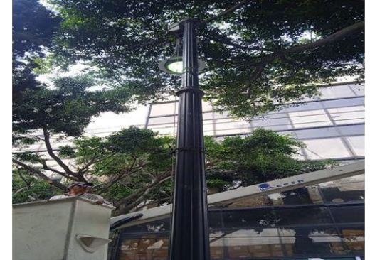
Reparación de alumbrado en Ecuador de Brasil a Comonfort
