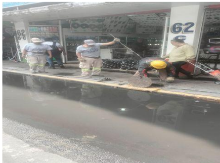
Desazolve de coladera en Artículo 123 N°62
