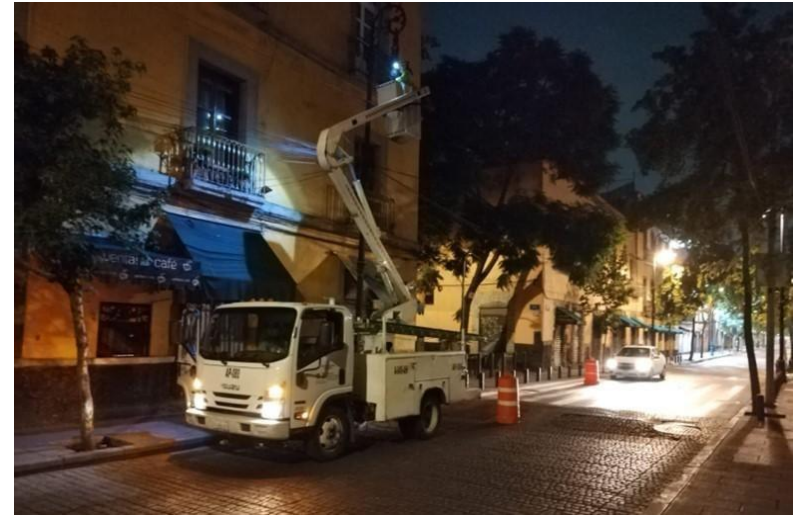
CAMBIO / INSTALACIÓN DE BALASTRO Y LUMINARIA
