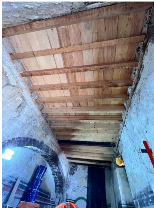
Integración de vigería de madera y entablado de espadaña
