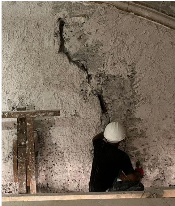
Exploración, inyección y colocación de grapas en grietas del presbiterio
