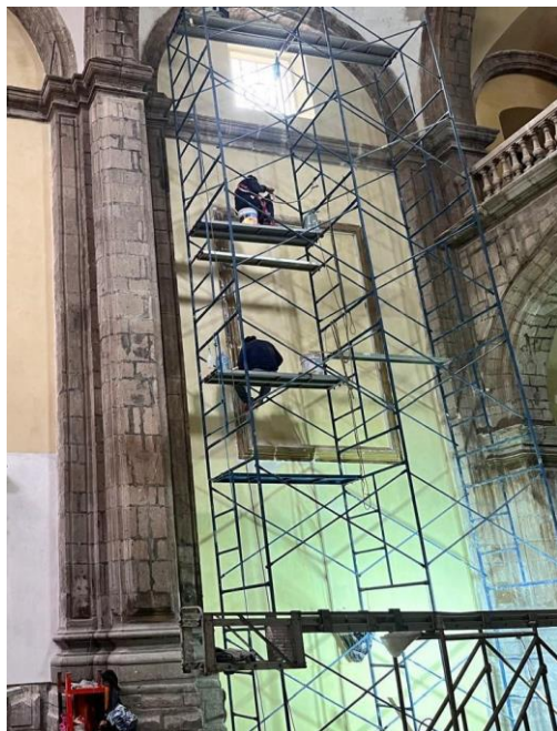
Aplicación de aplanado fino y pintura a la cal.
