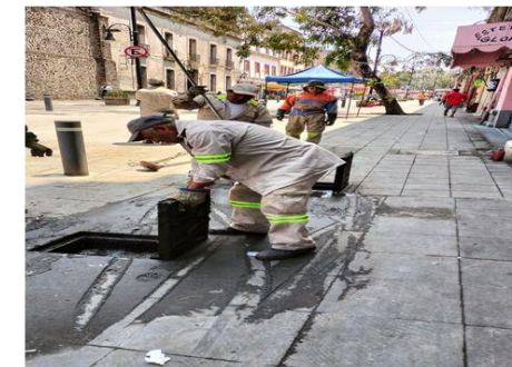
Desazolve en Nicaragua N°1
