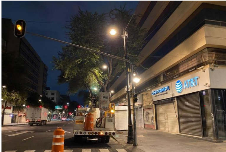
CAMBIO / INSTALACIÓN DE LÁMPARA
