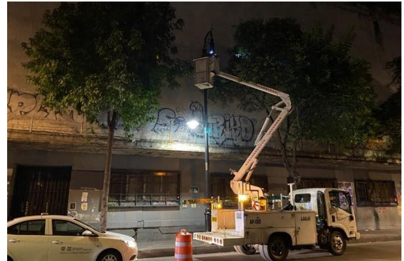
CAMBIO / INSTALACIÓN DE SOCKET PGZ
