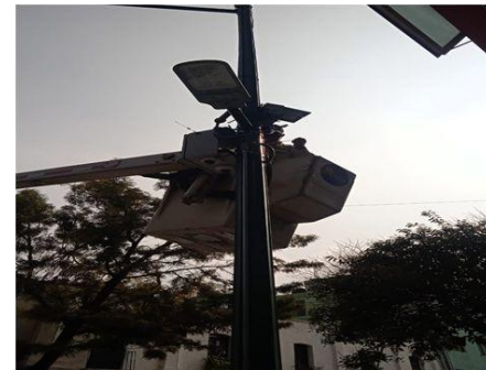
Reparación de alumbrado en Ernesto Pugibet de Luis Moya a Revillagigedo
