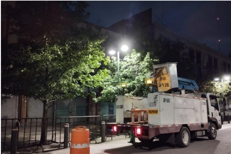
CAMBIO / INSTALACIÓN DE LÁMPARA
