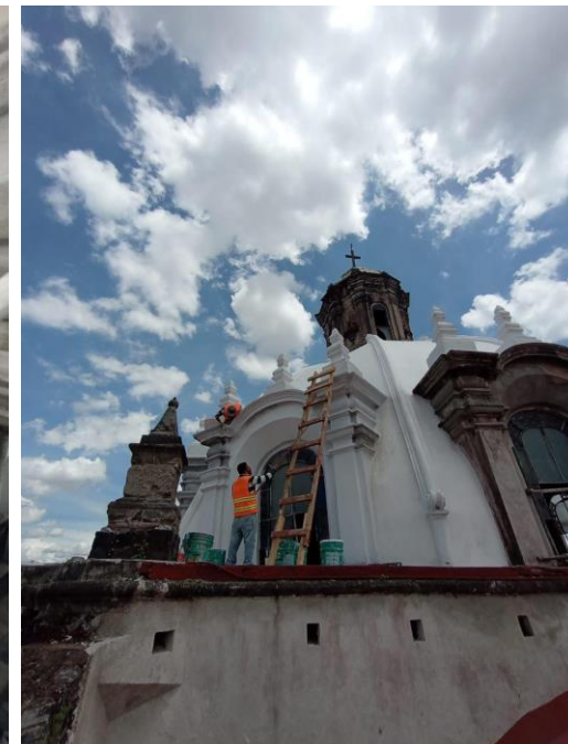
Aplicación de impermeabilizante blanco en extradós de cúpula
