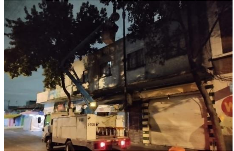
SUSTITUCIÓN DE FOTOCELDA
