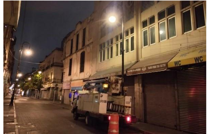
CAMBIO / INSTALACIÓN DE LÁMPARA Y BALASTRO
