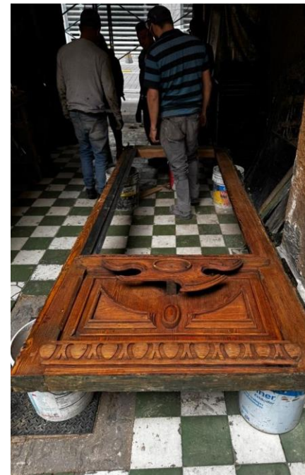
Tratamiento de conservación de elementos de madera en puertas y ventanas así como portón de acceso
