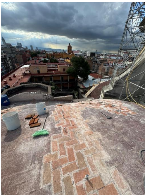
Inyección de grietas en extradós de bóvedas de nave principal, así como integración de enladrillado.
