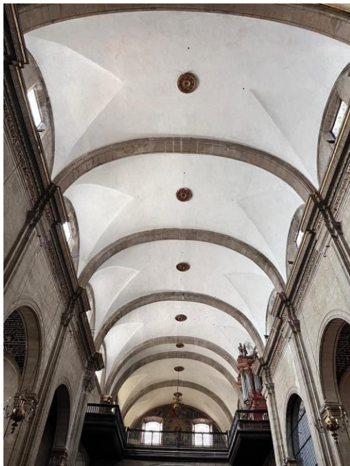
Consolidación de bóvedas de nave principal
