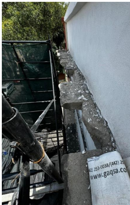
Cambio de piezas de cantera en cornisas, afinado de superficies de muros y limpieza de herrerías
