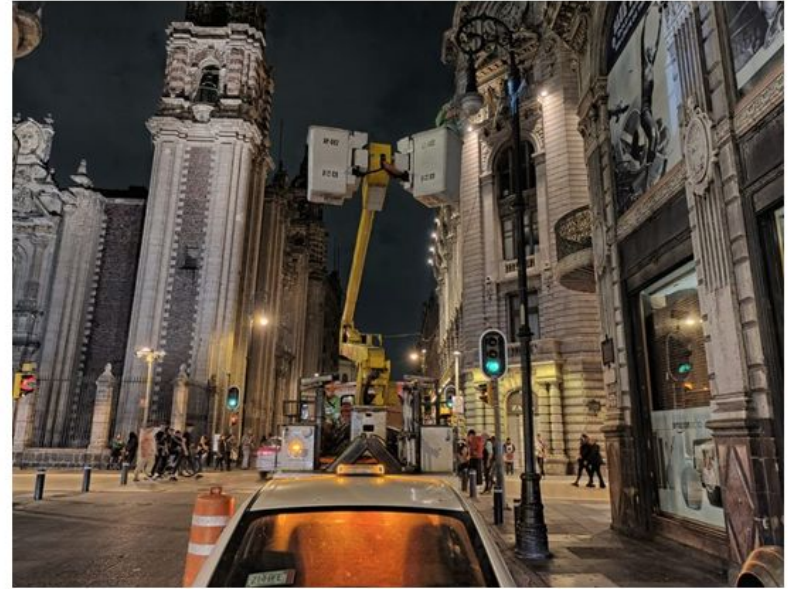
CAMBIO DE BALASTRO
