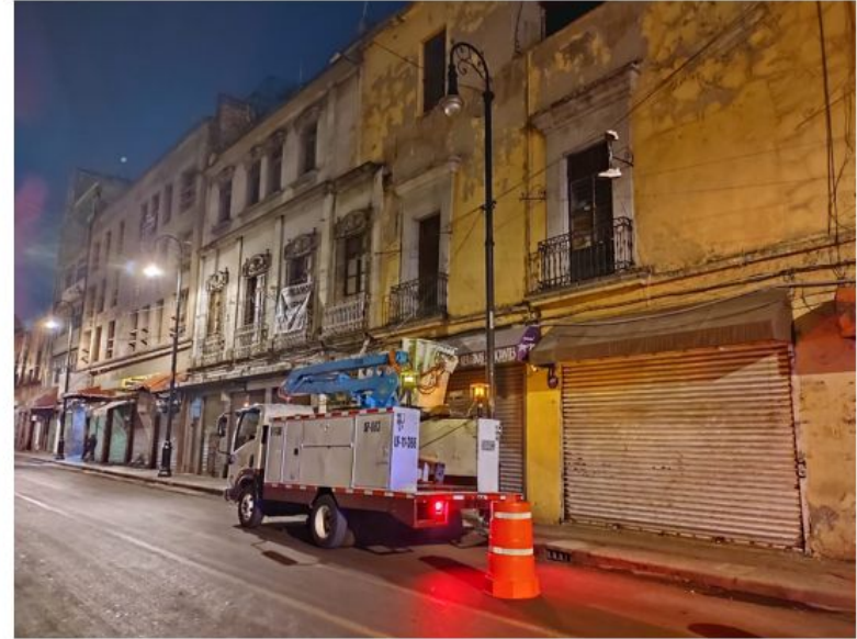
RECONEXIÓN DE LÍNEAS
