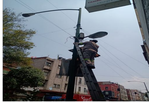
Reparación de luminarios en calle Vizcaínas
