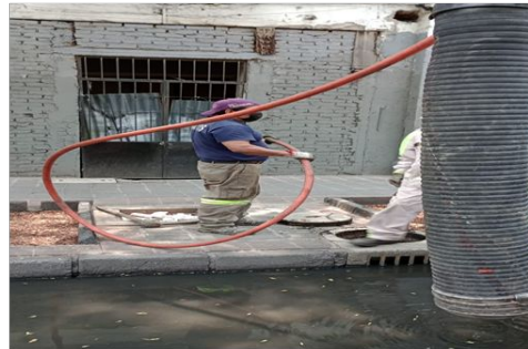
Desazolve de coladeras en Bucareli y Atenas
