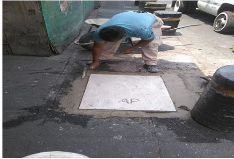
Colocación de tapa de registro sobre calle Jesús María
