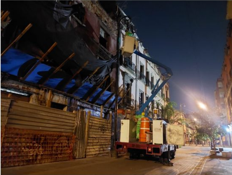
CAMBIO DE BALASTRO
