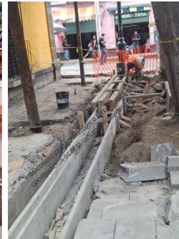
Colado de canal de captación de agua pluvial.
