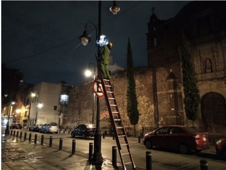
CAMBIO DE BALASTRO
