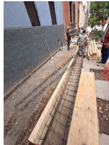
Colocación de cimbra para canal de captación de agua pluvial.
