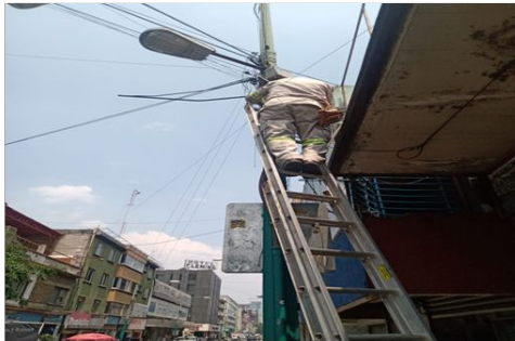
Reparación de luminarios en Ayuntamiento
