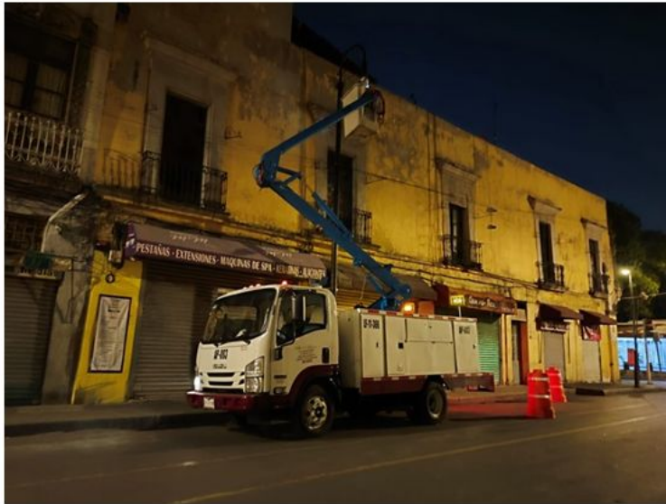
CAMBIO DE BALASTRO
