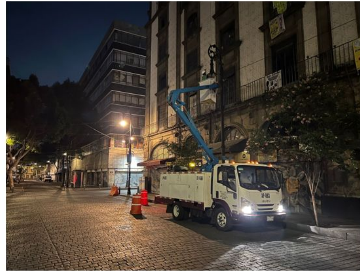
RECONEXIÓN DE LINEAS DE ALIMENTACIÓN
