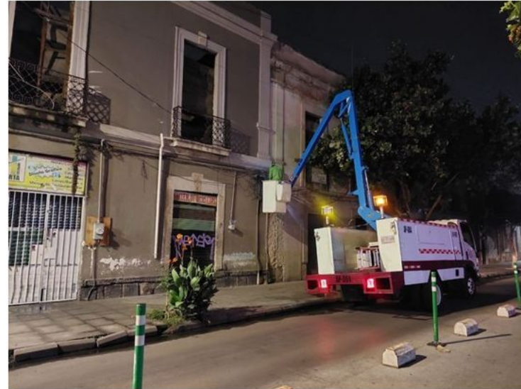
INSTALACIÓN DE COMPONENTES FALTANTES
