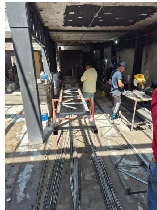
Armado y colocación de reforzamiento de estructura existente.
