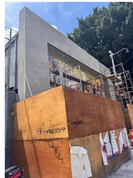
Trabajos de instalación de locales comerciales, cancelarías en fachada y cortinas metálicas, así como colocación de acabado en fachada a base de cantera laminada e instalación de luminarias
