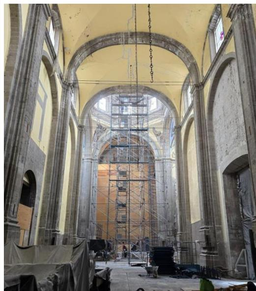
Colocación de andamios para construcción de reclusa de bóveda de cúpula y retiro de aplanados en muros de la nave principal.
