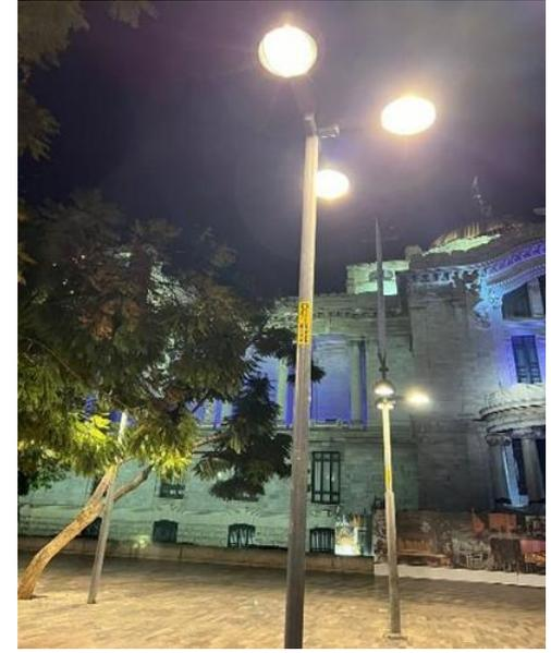
**CAMBIO DE LAMPARA Y BALASTRO , QUEDA FUNCIONANDO CORRECTAMENTE**
