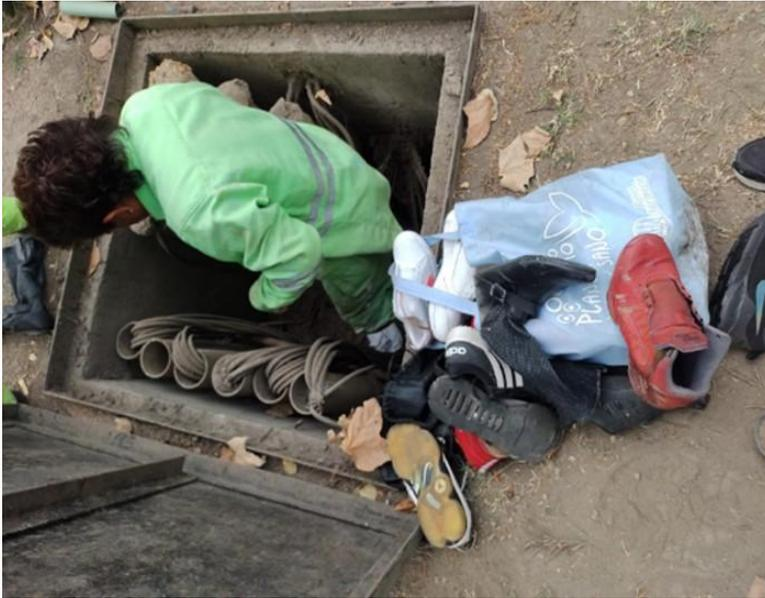
SE DESOLTA TAPA DE BOVEDA, SE RECONECTAN LOS CABLES
