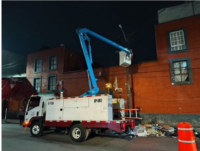
RECONEXIÓN DE LÍNEAS DE ALIMENTACIÓN
