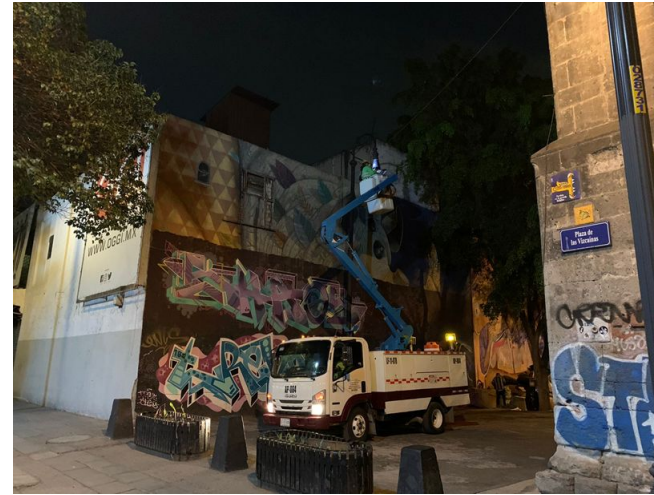
RECONEXIÓN DE LÍNEAS DE ALIMENTACIÓN
