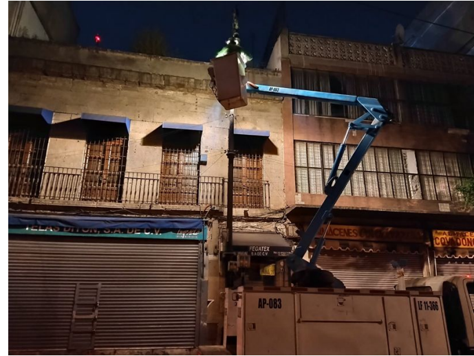
CAMBIO DE BALASTRO ELECTRÓNICO
