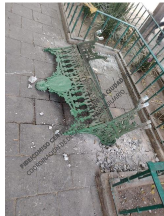
Demolición de guarnición y banqueta, remoción de herrerías y mobiliario urbano.
