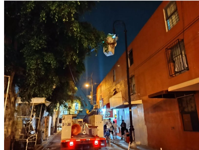
CAMBIO DE LÁMPARA Y BALASTRO
