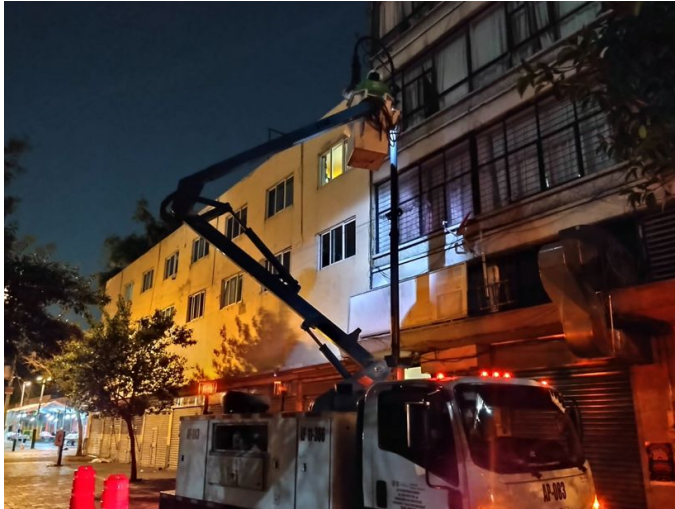
RECONEXIÓN DE LÍNEAS DE ALIMENTACIÓN
