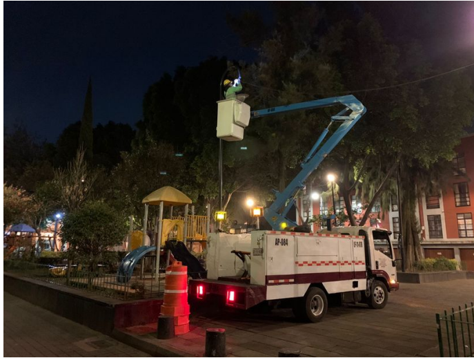
CAMBIO DE LÁMPARA Y BALASTRO
