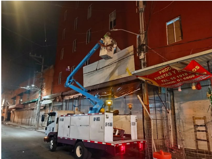
CAMBIO DE BALASTRO Y LÁMPARA
