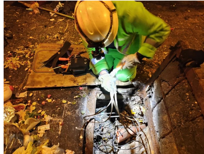
RECONEXIÓN DE LÍNEAS DE ALIMENTACIÓN
