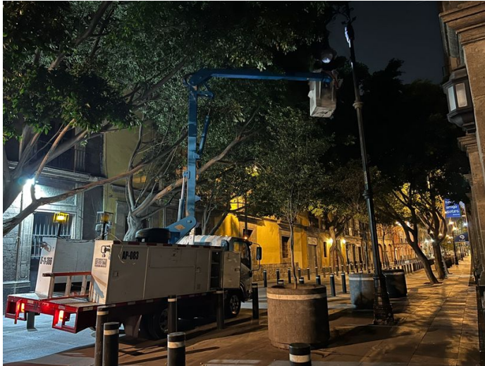
CAMBIO DE LÁMPARAS Y BALASTRO
