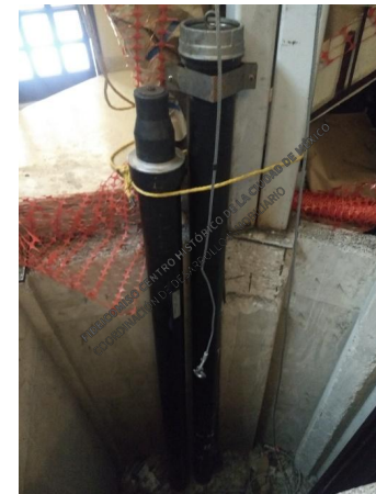
Suministro y colocación de pistón del elevador
