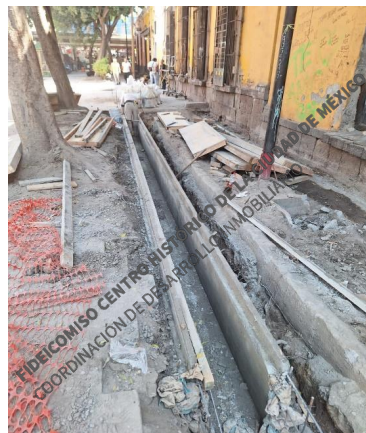
Elaboración de canal de captación
