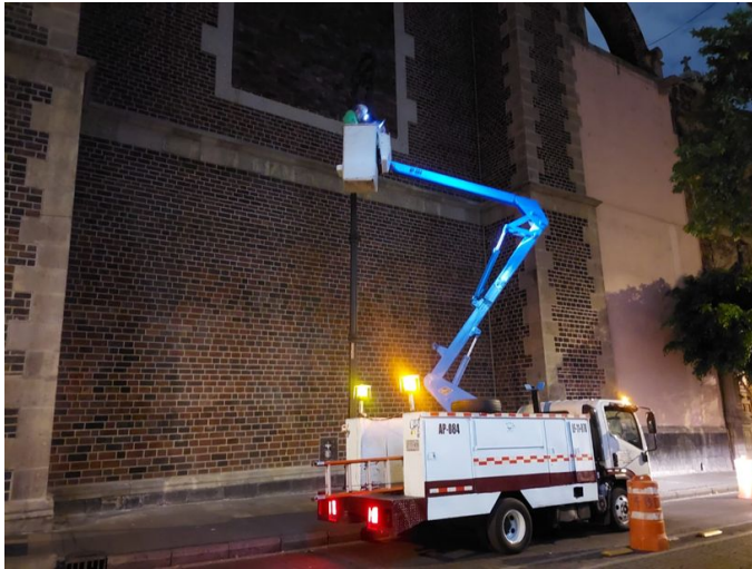
CAMBIO DE BALASTRO
