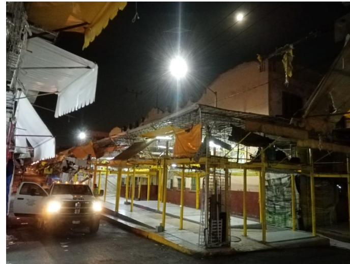
RECONEXIÓN DE LÍNEAS DE ALIMENTACIÓN
