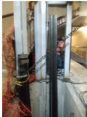
Suministro y colocación de pistón del elevador
