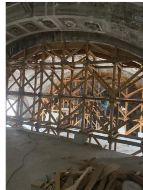
Liberación de andamiaje en arco interior.
