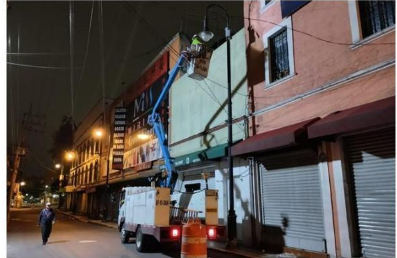
CAMBIO DE LÁMPARA Y BALASTRO
