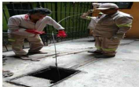
Desazolve interior en Callejón Hormiguero 16
