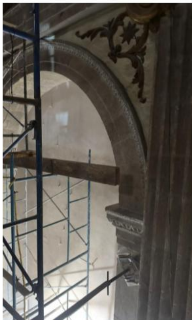
Liberación de andamiaje en arco interior.
