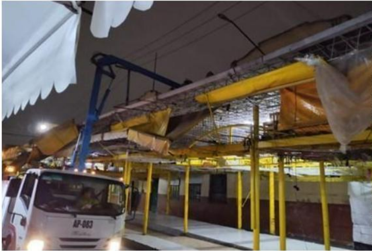
RECONEXIÓN DE LÍNEAS DE ALIMENTACIÓN
