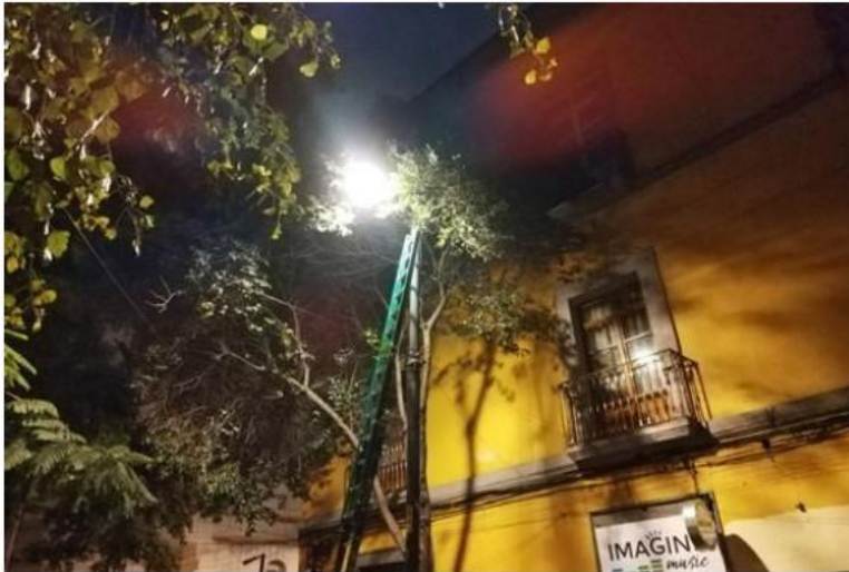
SUSTITUCIÓN DE SOCKET Y LÁMPARA PGZ Y BALASTRO ELECTRÓNICO
