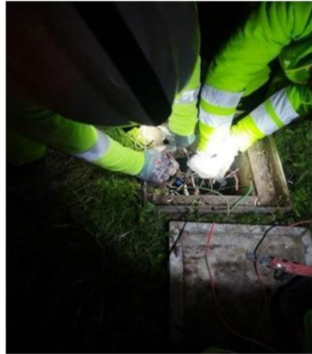
RECONEXIÓN DE REGISTRO, BALASTRO, FOCO, SOCKET
