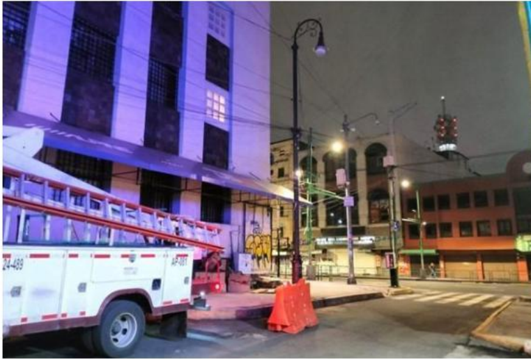
RECONEXIÓN DE LÍNEAS DE ALIMENTACIÓN
