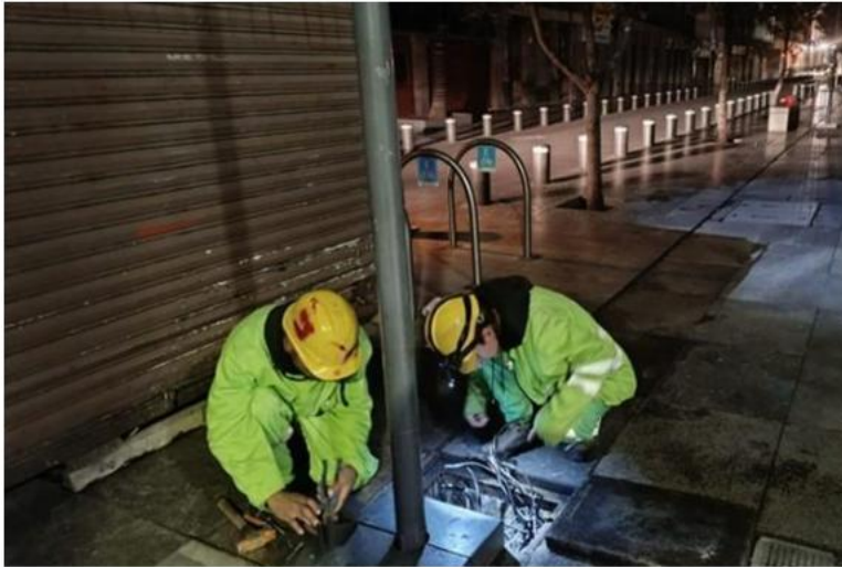
RECONEXIÓN DE LÍNEAS DE ALIMENTACIÓN
