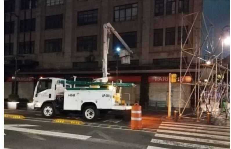
CAMBIO DE CONTACTOR
