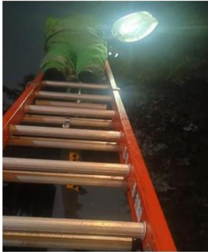
CAMBIO DE LÁMPARA Y BALASTRO
