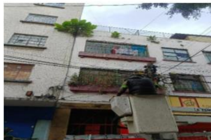
Retiro de maleza en fachada Paraguay 74
