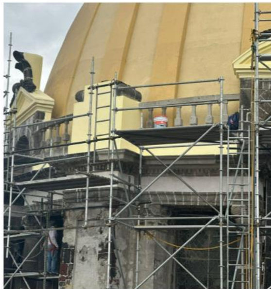
Liberación de andamiaje en bóveda principal.
