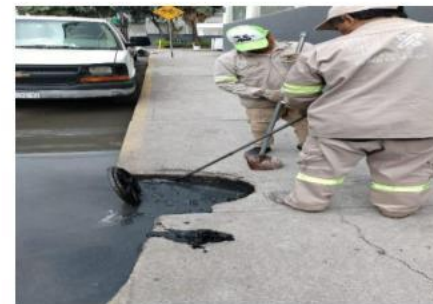
Desazolve en coladera de banqueta, Iturbide 39
