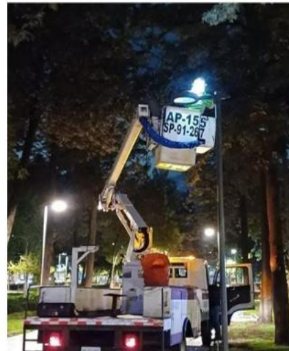
CAMBIO DE LÁMPARA Y BALASTRO
