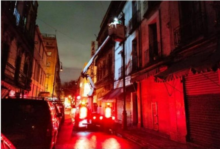
SUSTITUCIÓN DE FOTOCELDA
