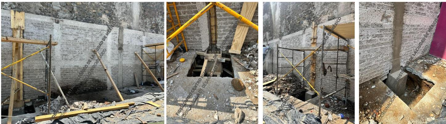
Construcción de zapatas de cimentación, dados y castillos de concreto armado en muro norte de la cancha de usos múltiples, para la colocación de la Estructura Metálica
