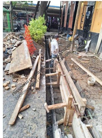
Elaboración de canal de captación de agua pluvial, cimbrado.
