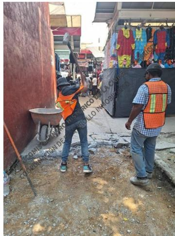
Demolición de banqueta deteriorada existente.
