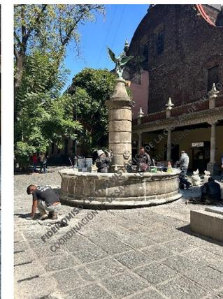
Trabajos de rehabilitación de firmes y pisos. Se ha realizado la sustitución de piezas de piso de cantera acabado punzonado dañadas, el desazolve del dren de desagüe pluvial y el mantenimiento a la fuente realizando remodelos de cantera y limpieza de piezas de talavera existentes en su interior.
