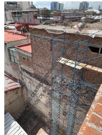
Trabajos de consolidación de muros en tercer nivel y trabajos de reintegración de entresijos.
