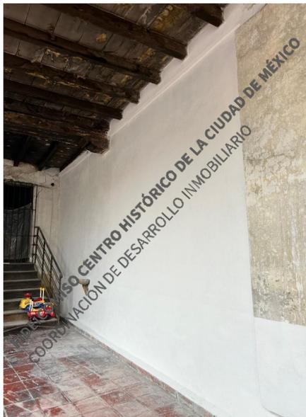
Consolidaciones en muro oriente del templo, mediante la reintegración de piezas de tezontle, junteo e inyección de muros con de mezcla de cal de alta pureza.
