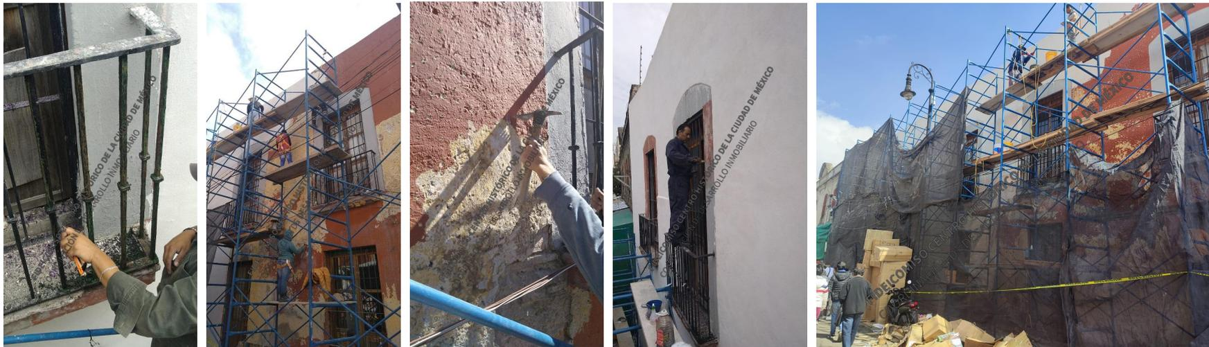
Trabajos de mantenimiento integral de herrerías históricas, liberación de pintura y aplanados deteriorados y remoldeos en marcos de ventanas.
