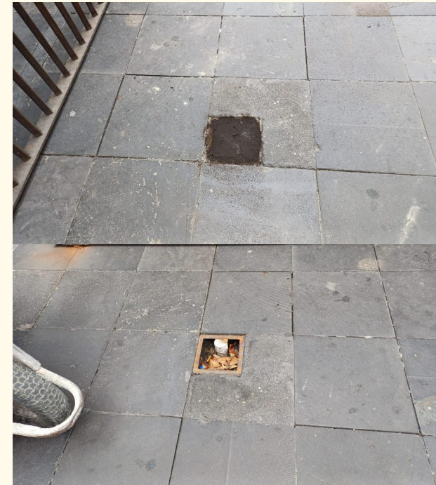
Rehabilitación de infraestructura peatonal y mobiliario urbano Plaza Juárez
