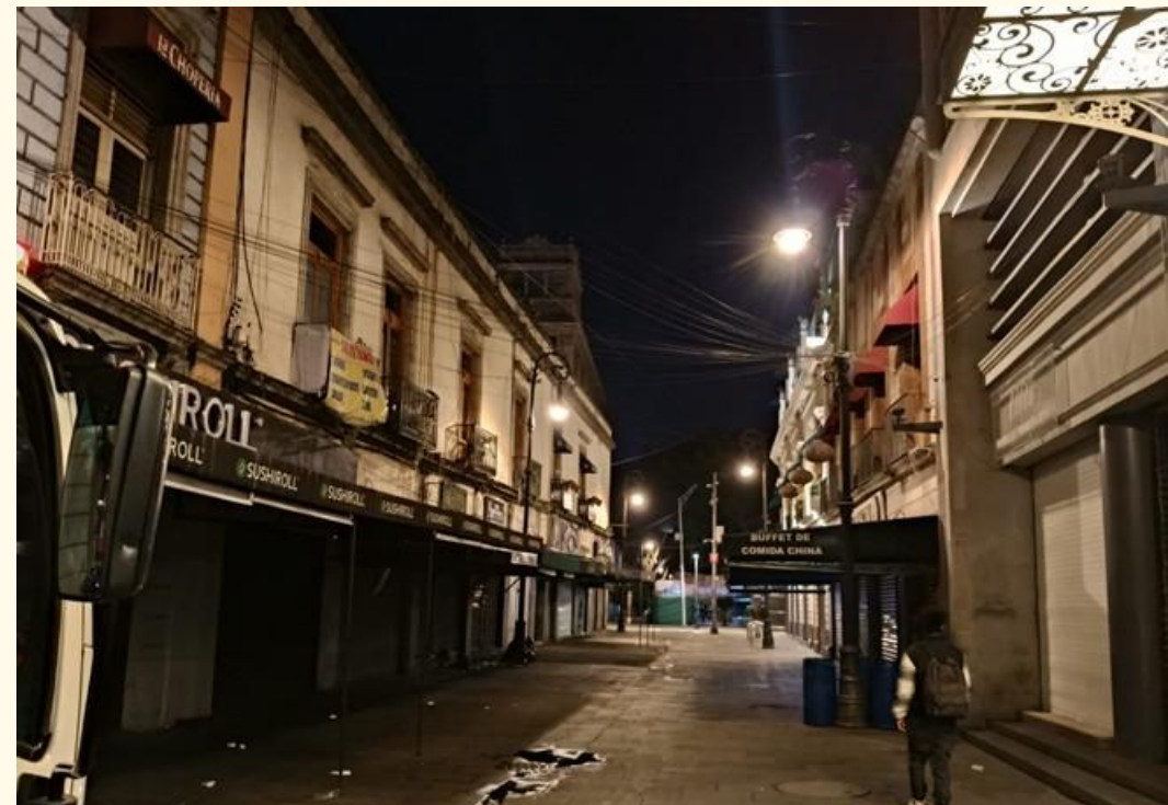
CABLEADO Y RECONEXIÓN DE LÍNEAS DE ALIMENTACIÓN
