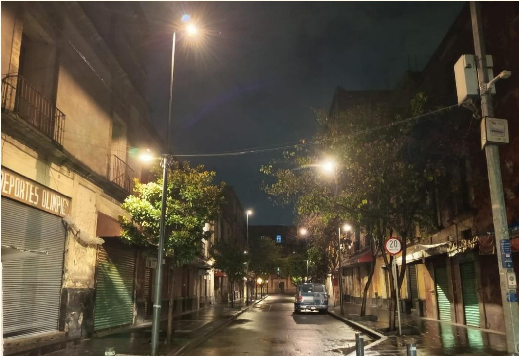
RECONEXIÓN DE LÍNEAS DE ALIMENTACIÓN
