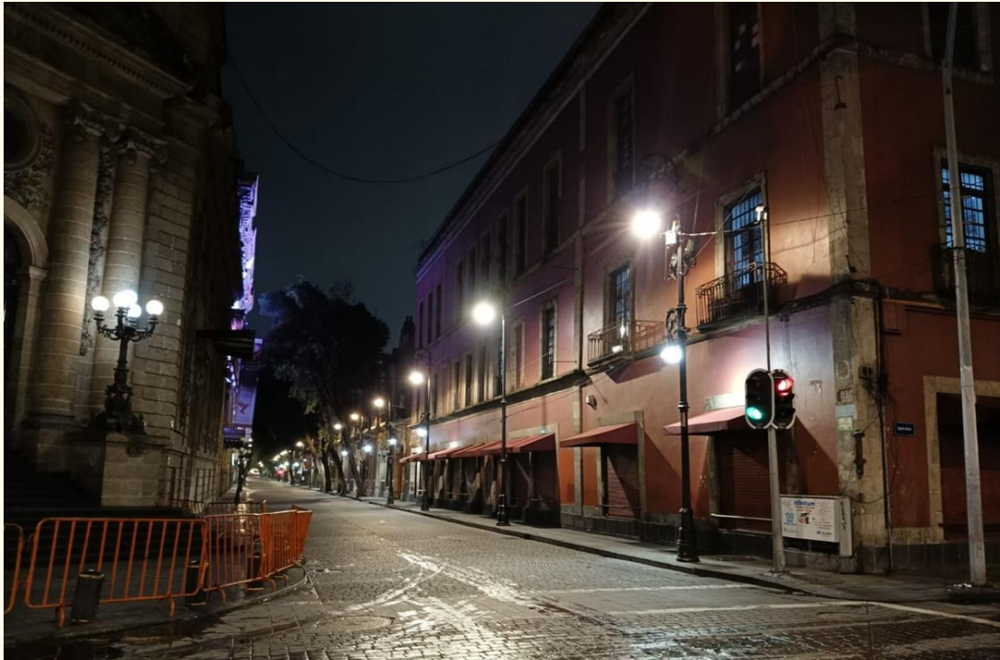
REHABILITACIÓN DE CABLE Y RECONEXIÓN DE MUFA
