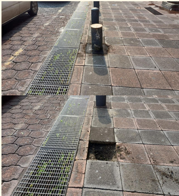
Colocación de bolardo en vía pública Calle Tacuba, entre Filomeno Mata y Condesa
