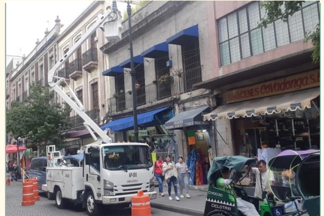
INSTALACIÓN DE LUMINARIA
