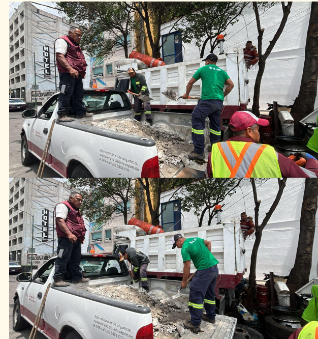
Traslado de residuos de construcción para su descarga San Antonio Abad #65 a Escuela Médico Militar
