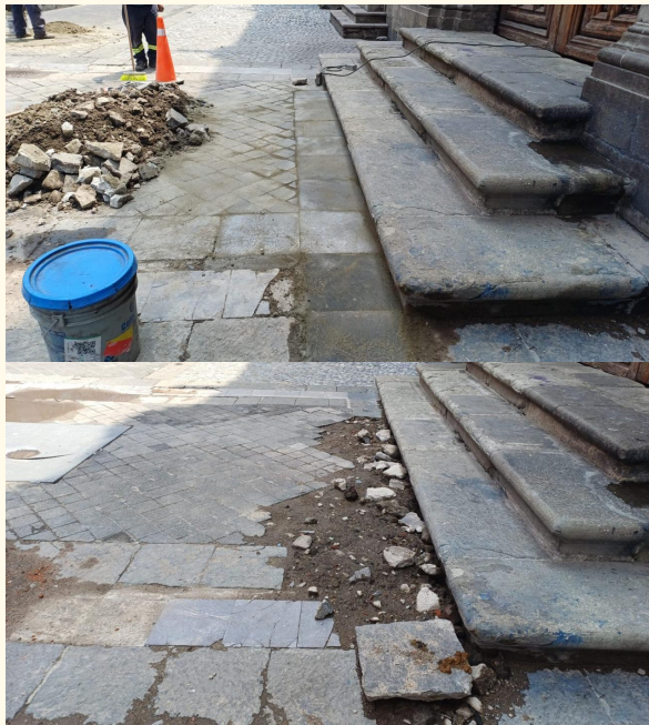
Rehabilitación de superficie peatonal Calle San Ildefonso #43, entre Argentina y El Carmen
