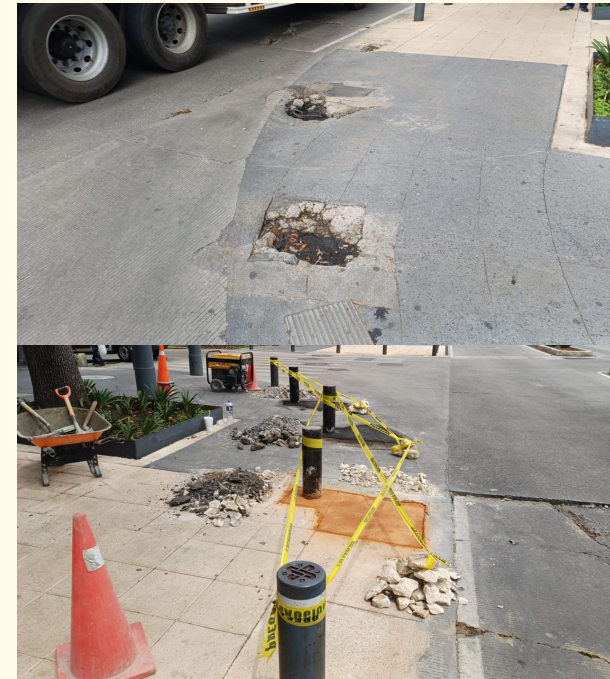
Reconfiguración de banqueta y colocación de bolardos Valerio Trujano esquina Hidalgo, lado poniente junto al SAT
