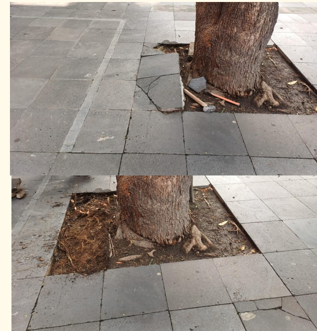
Retiro de loseta en área de cajete Plaza Juárez
