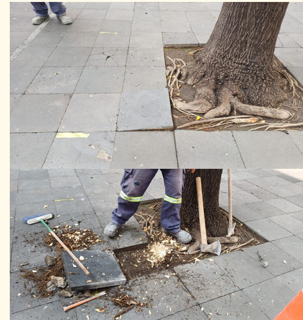
Rehabilitación de superficie en cajete Plaza Juárez
