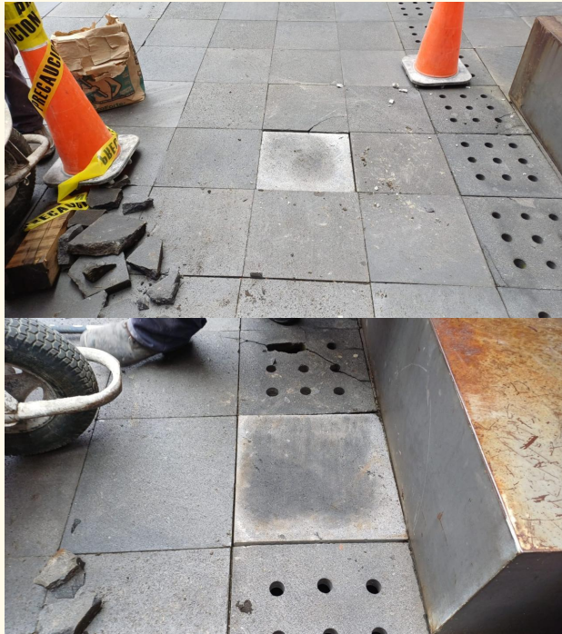
Reposición de loseta en acceso peatonal Acceso principal a edificio de Relaciones Exteriores
