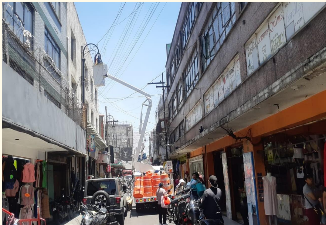
CAMBIO DE LUMINARIA
