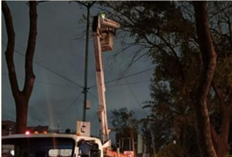
CAMBIO/INSTALACIÓN DE BALASTRO Y LÁMPARA E-39
