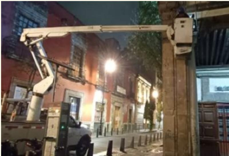
CAMBIO/INSTALACIÓN DE BALASTRO Y LÁMPARA PGZ
