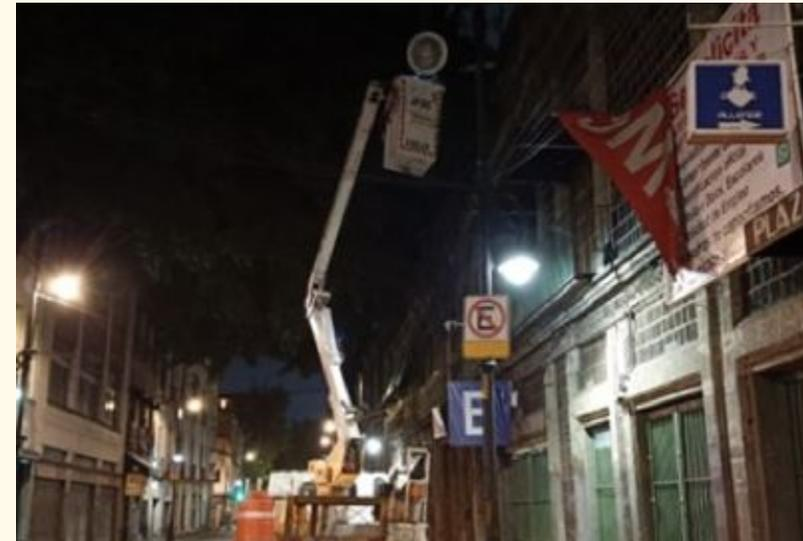
CAMBIO/INSTALACIÓN DE BALASTRO Y LÁMPARA PGZ
