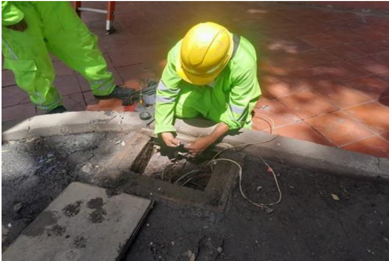
CAMBIO DE LÁMPARA, BALASTRO Y SOCKET
