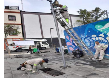
Reparación de alumbrado público en plaza Zarco
