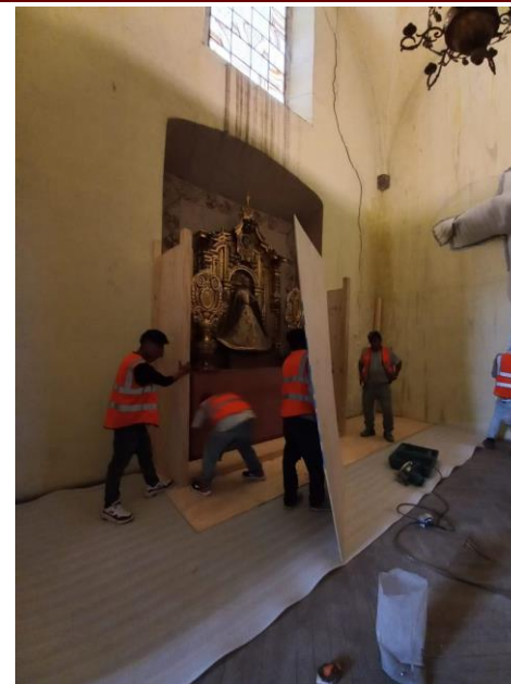
Protección de bienes muebles para atención a grietas en muros.
