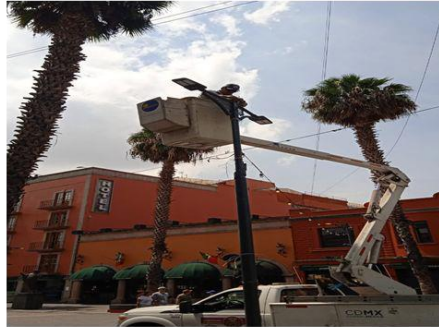
Reparación de alumbrado público en Garibaldi
