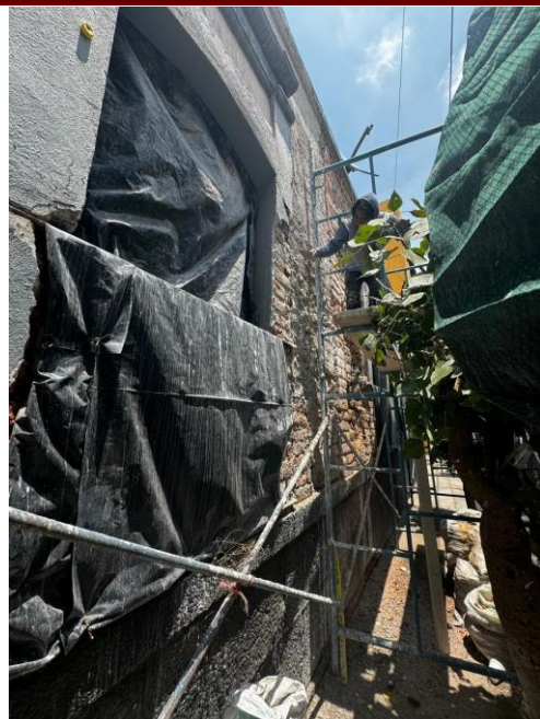
Se continúa el proceso de liberación y reintegración de aplanados en paramentos de fachadas Leona Vicario 68
