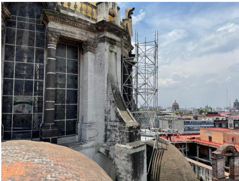
Colocación de andamios para atención a tambor de cúpula.
