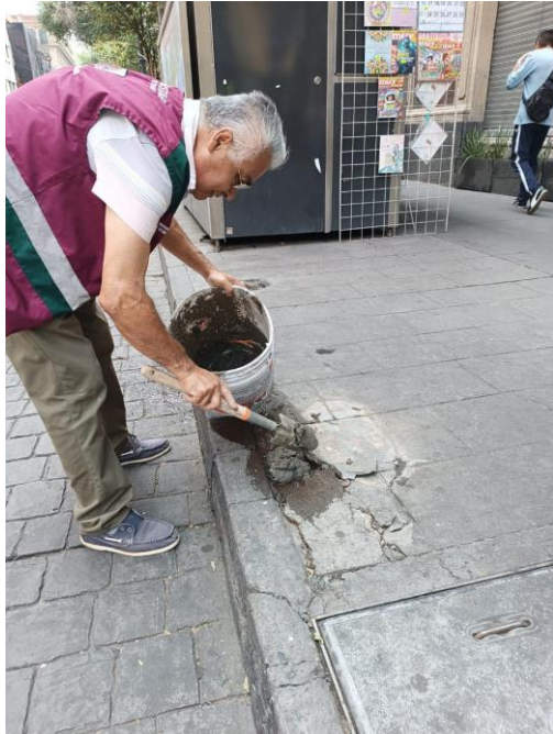
Reparación de incidencias en banquetas
