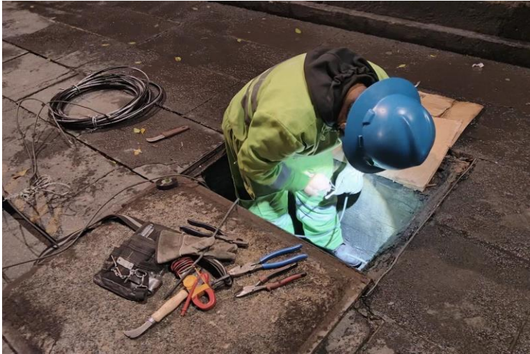
RECONEXIÓN DE LÍNEAS DE ALIMENTACIÓN
