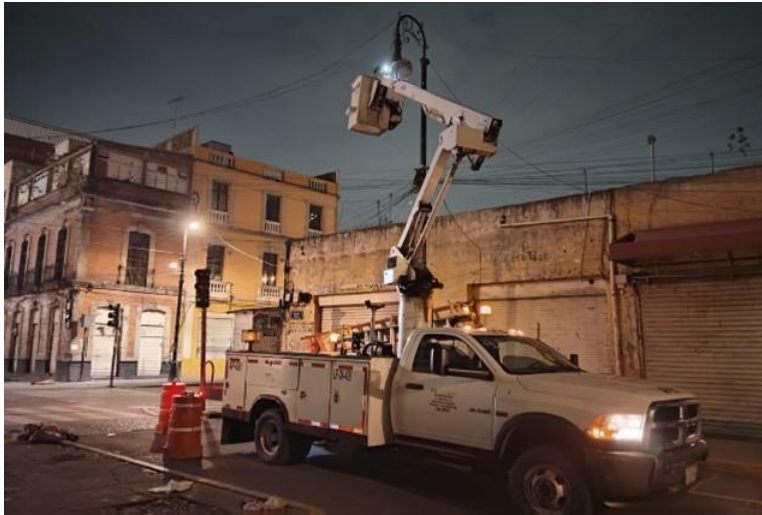
CAMBIO DE BALASTRO
