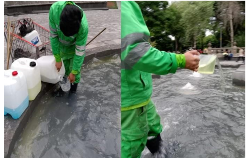
APLICACIÓN DE QUÍMICOS: ALGUCIDA, HIPOCLORITO Y CLARIFICADOR
