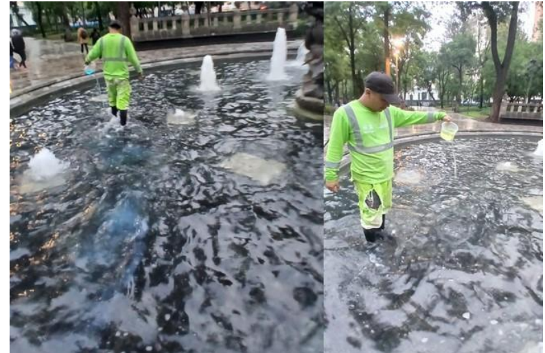
APLICACIÓN DE QUÍMICOS: ALGUCIDA, HIPOCLORITO Y CLARIFICADOR
