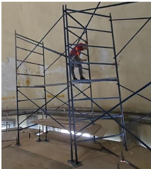
Liberación de pintura vinílica en intradós de cúpula.
