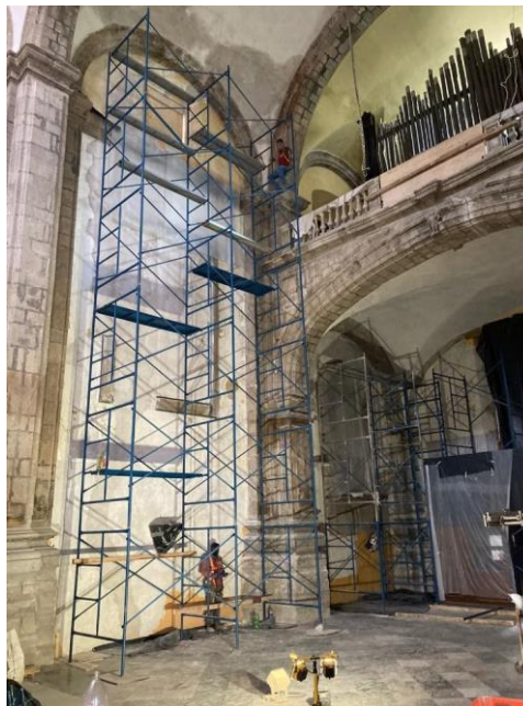
Armado de andamios al interior del templo para atención a grietas.
