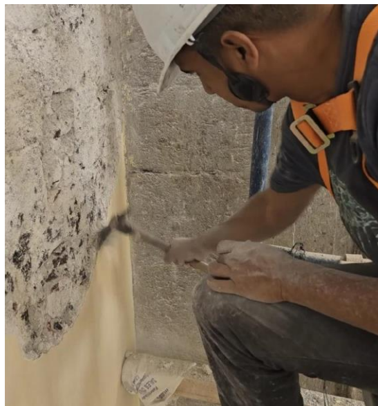
Liberación de aplanados afectados por los sismos.
