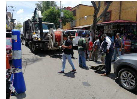
Desazolve sobre calle Lecumberri
