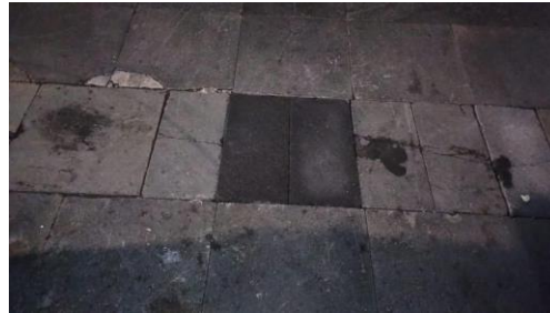
Reposición de tapas de dren en Plaza del Empedrado
