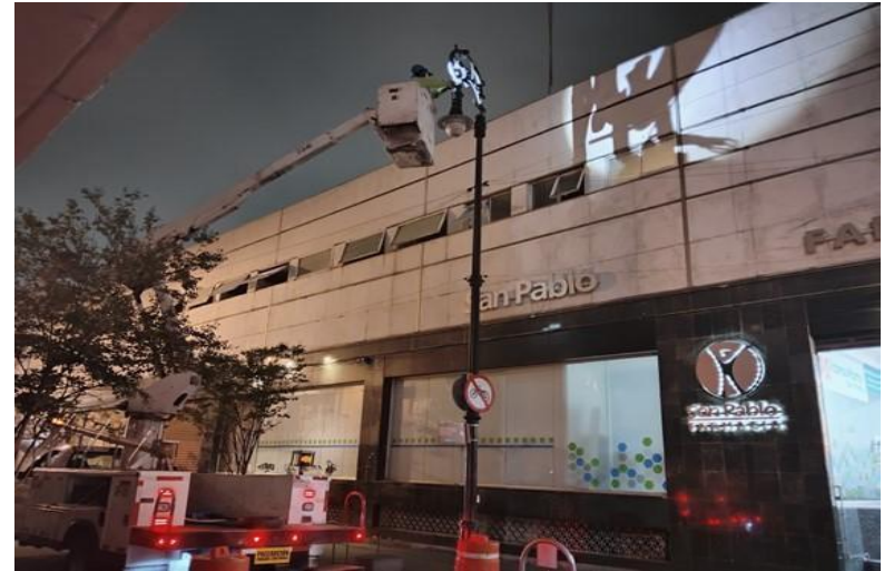
CAMBIO DE LÁMPARA, BALASTRO ELECTRÓNICO, SOCKET
