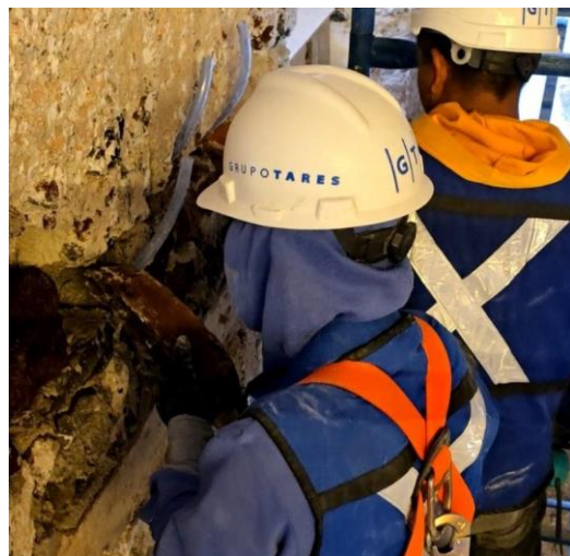
Consolidación de muros y colocación de puertos de inyección
