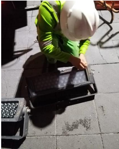
CAMBIO DE PROYECTORES COLOR REACH Y COLOR BLAST
