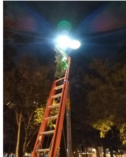
CAMBIO DE FOCO Y BALASTRO
