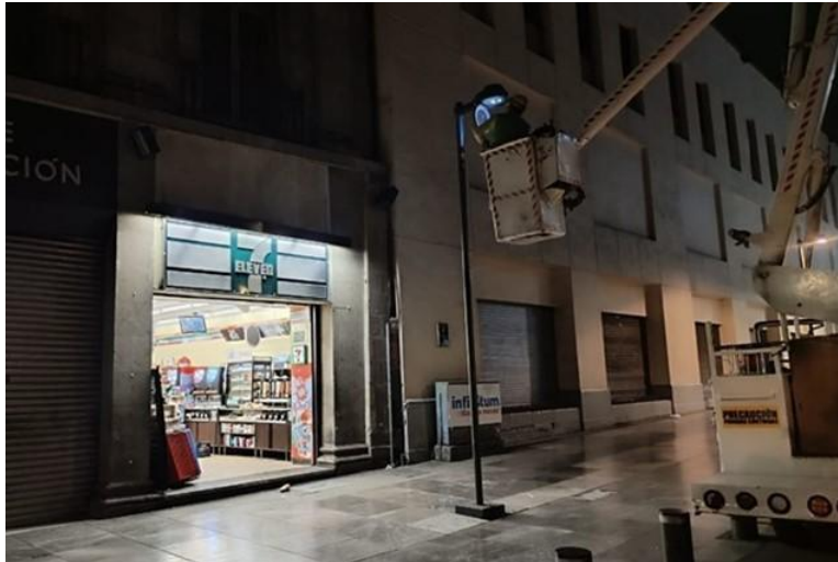
CAMBIO DE BALASTRO Y LUMINARIA
