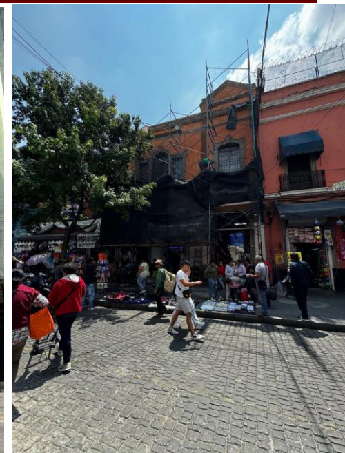
Aplicación de pintura a la cal y rejunte de elementos pétreos
