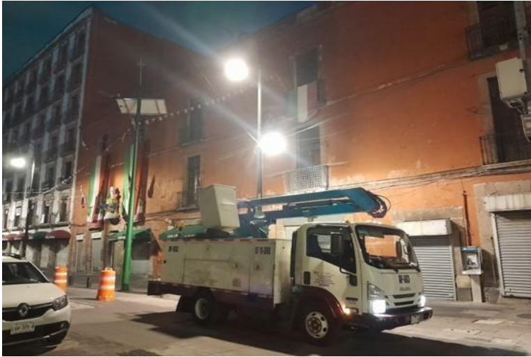
CAMBIO DE LUMINARIA
