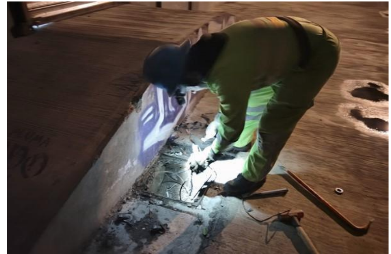
RECONEXIÓN DE LÍNEAS DE ALIMENTACIÓN
