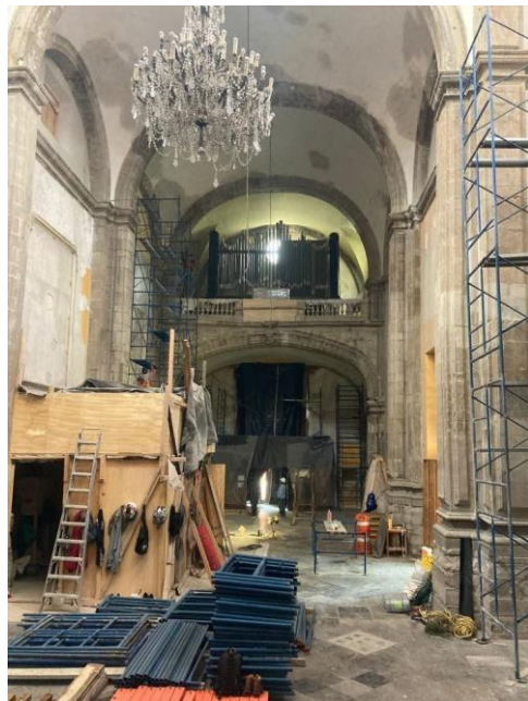
Armado de andamios al interior del templo para atención a grietas.
