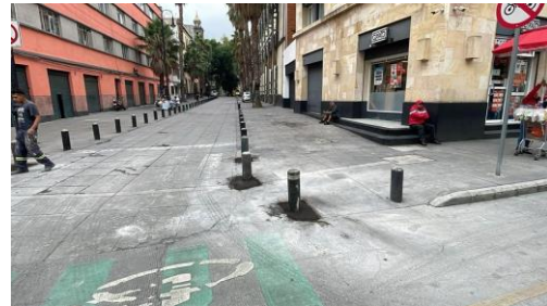
Reposición de bolardos en Leandro Valle y República de Perú
