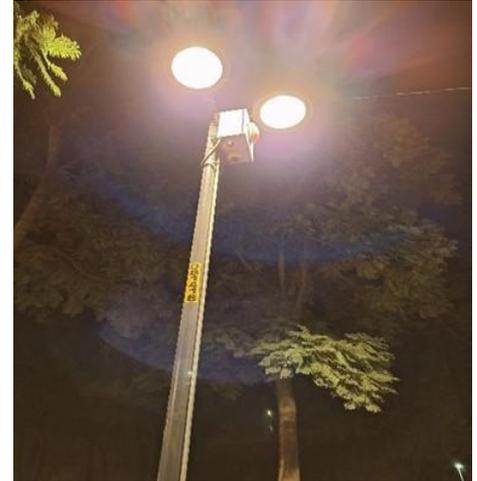
**SE ATIENDE EN PDL 081418, EN CUAL NO RECIBIA LOS 220 VOLTIOS, SE ENCUENTRAN CABLES EXPUESTOS DE TUBERIA DESCUBIERNOS Y CORTADOS, SE VUELVEN A CONECTAR, SE ENTIERRAN Y QUEDA ENCENDIDA CORRECTAMENTE**
