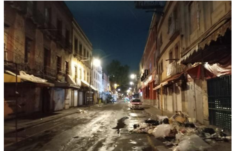
CAMBIO / INSTALACIÓN DE BALASTRO
