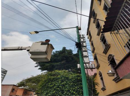
Reparación de alumbrado público en calle Nezahualcóyotl
