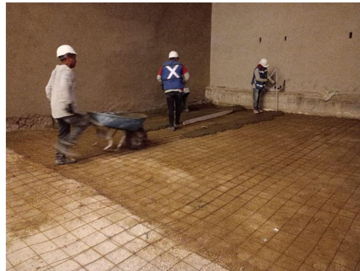
Nivelación de entrepiso e integración de firme de concreto armado
