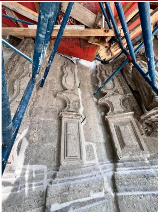
Rejunteo de cantera de la fachada principal
