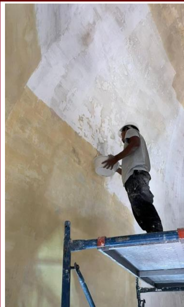
Aplicación de pintura a la cal, con color autorizado por el INAH
