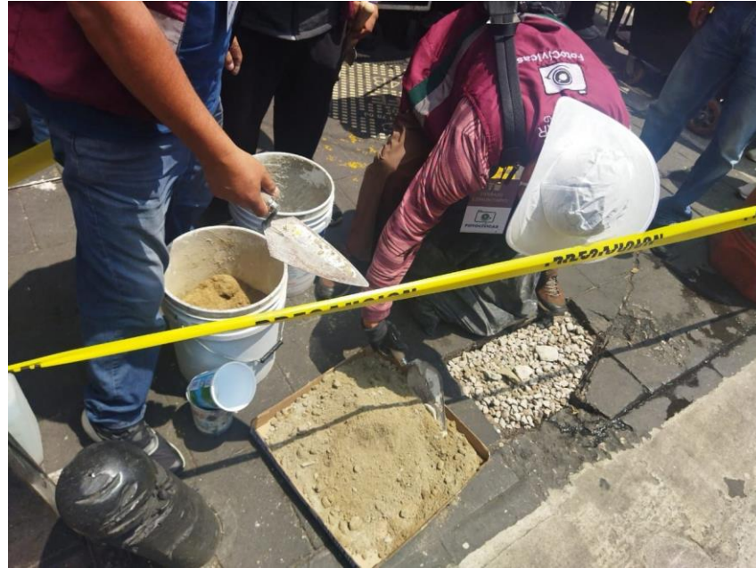
Reparación de incidencias República de Argentina
