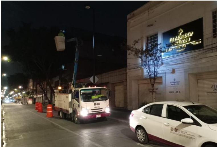
CAMBIO / INSTALACIÓN DE LÁMPARA
