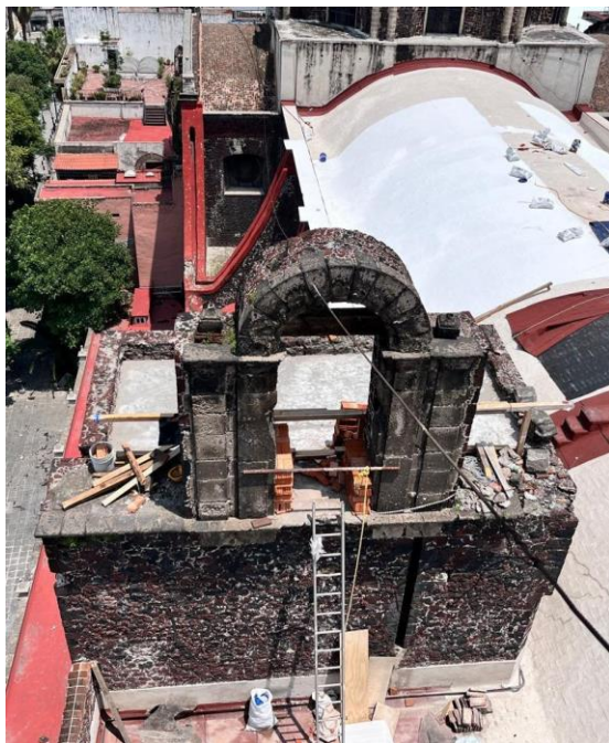
Sustitución de vigas de madera deterioradas y colado de losa firme en espadaña.
