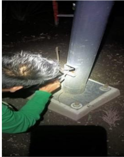
RECONEXIÓN DE LÍNEAS
