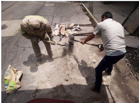
Reparación de banqueta en calle Revillagigedo
