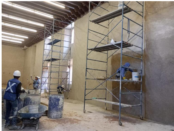
Aplicación de aplanado fino en muros
