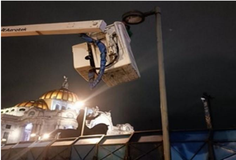
LIMPIEZA DE CONEXIONES SULFATADAS
