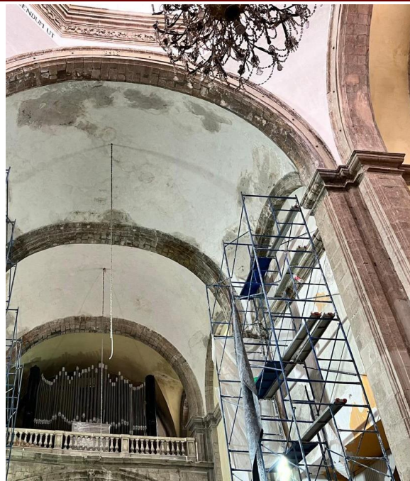
Aplicación de aplastado fino al interior de muros de la nave principal
