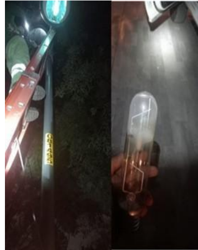
CAMBIO DE FOCO Y BALASTRO
