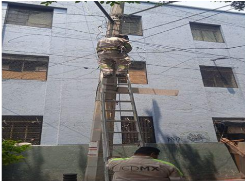
Reparación de alumbrado en el callejón de Ecuador
