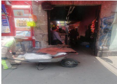
Retiro de escombros en Izazaga N°62
