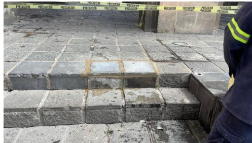
Reparación de escalones en Plaza 23 de Mayo
