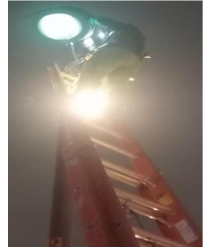
CAMBIO DE BALASTRO Y LÁMPARA TIPO MOGUL
