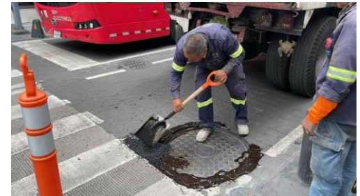
Reparación de bache en Belisario Domínguez
