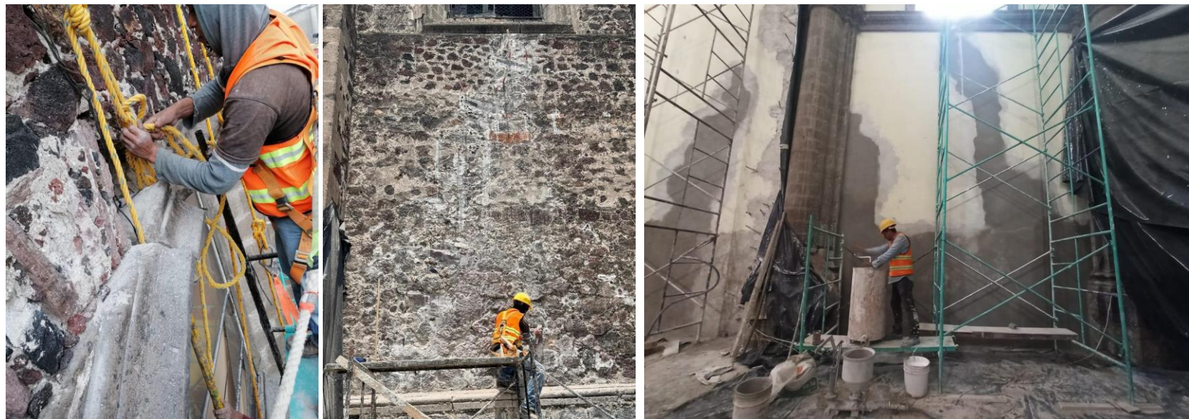
Remamposteado de grietas y aplicación de aplanado grueso.
