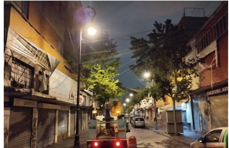
RESTABLECIMIENTO DE TERMOMAGNÉTICO
