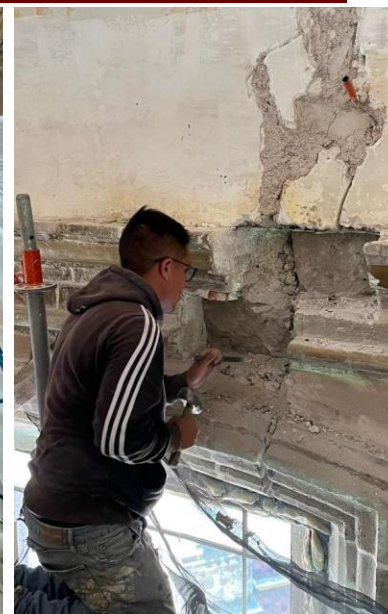
Liberación de piezas de cantera deterioradas en pechinas.
