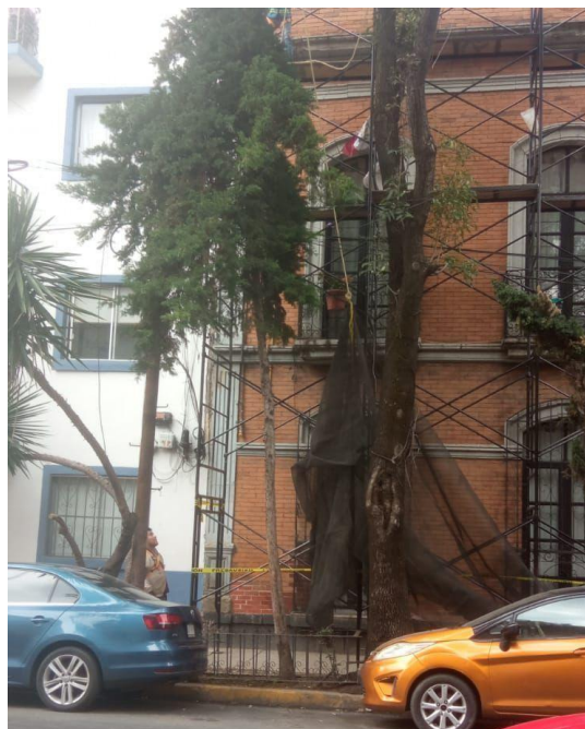
Armado de andamios y liberación de suciedad en paramentos de muros Pedro Moreno 117
