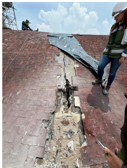
Liberación de enladrillado en extradós de bóvedas de la nave principal para exploración de grietas.
