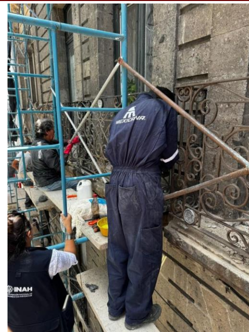
Limpieza de herrería histórica, trabajos en cantera e integración de piezas de cantera en ares faltantes Venezuela 35
