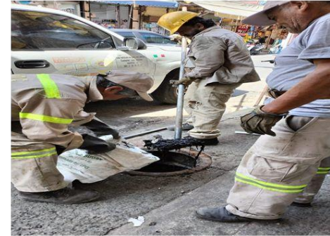
Desazolve en calle Bolivia N°82
