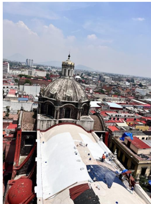
Aplicación de impermeabilizante en secciones faltantes de la nave principal
