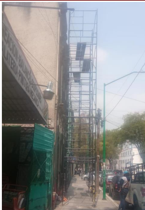
Armado de andamios y tapiales de protección peatonal Magnolia 88
