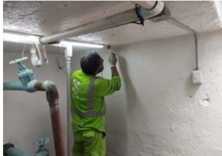
APLICACIÓN DE PINTURA EN PAREDES Y PUERTA DE BÓVEDA DE FUENTE
