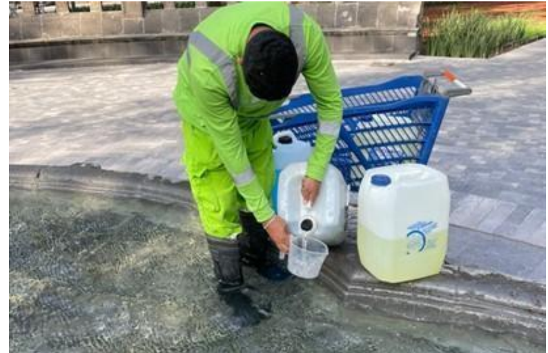
APLICACIÓN DE QUÍMICOS: ALGUICIDA, HIPOCLORITO Y CLARIFICADOR
