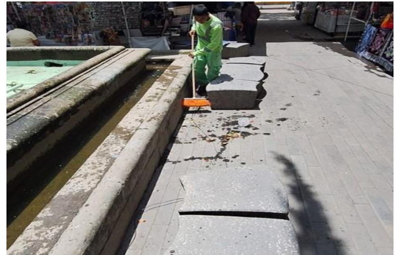
LIMPIEZA GENERAL DE FUENTE, ESPEJO DE AGUA Y ZONAS ALEDAÑAS
