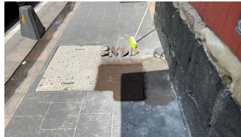
Reparación de piso en Belisario Domínguez
