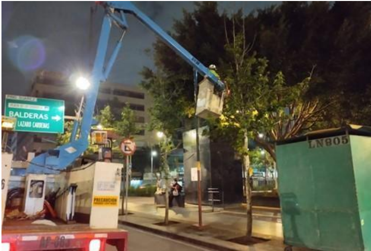
CAMBIO / INSTALACIÓN DE LÁMPARA, BALASTRO Y SOCKET
