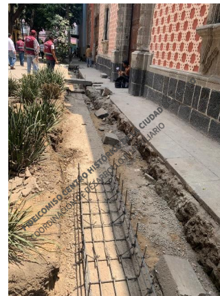
Armado para canal de captación de agua pluvial
