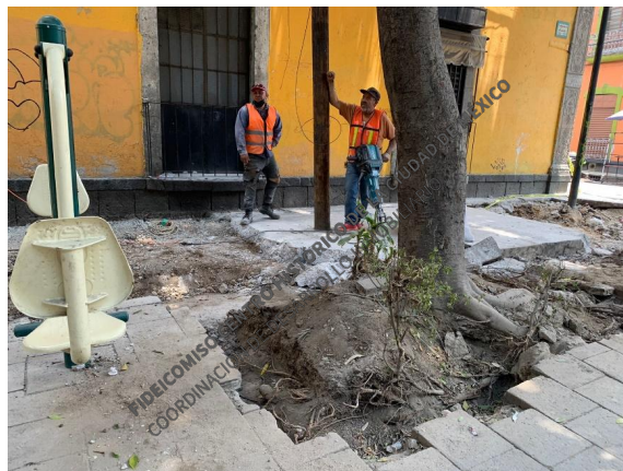
Demolición de banquetas
