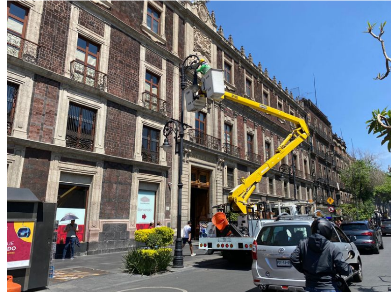
REACOMODO Y CAMBIO DE CABLEADO
