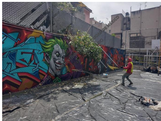
Retiro de malla ciclónica perimetral
