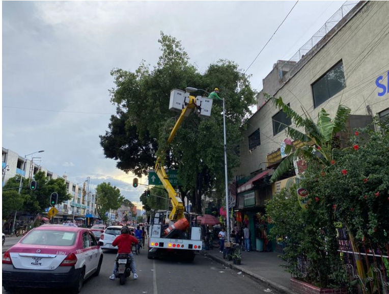
CAMBIO DE FOTOCELDA
