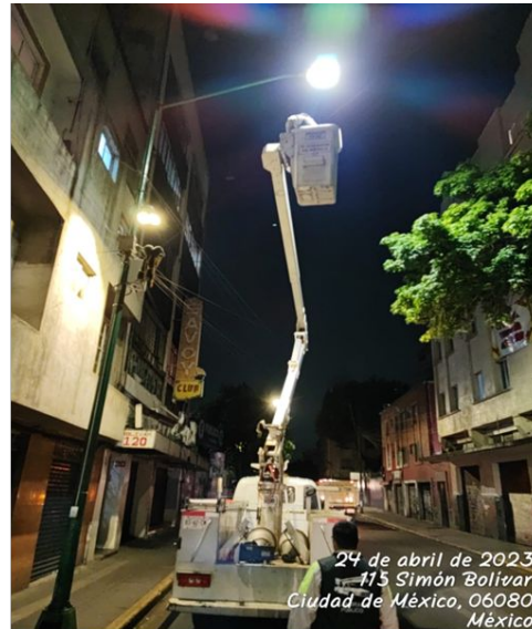
Reparación de luminarios en calle Simón Bolívar
