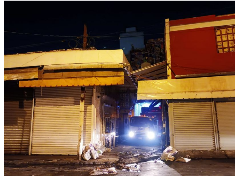
CAMBIO DE LUMINARIAS Y RECONEXIÓN DE LÍNEAS DE ALIMENTACIÓN
