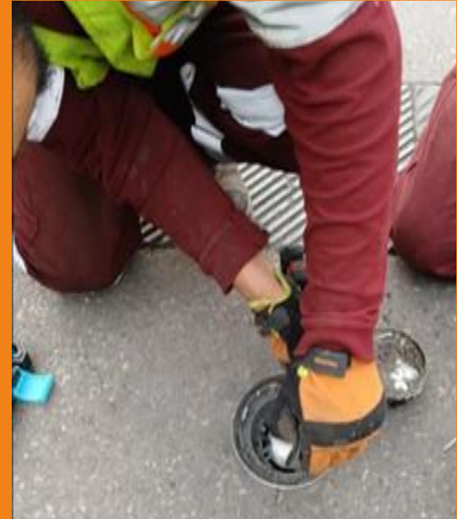
PERIMETRAL DE LA PLAZA DE LA CONSTITUCIÓN
