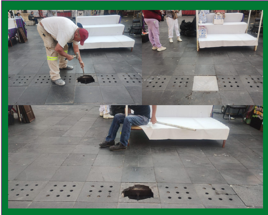
Sustitución de una loseta. Plaza Empedradillo.
