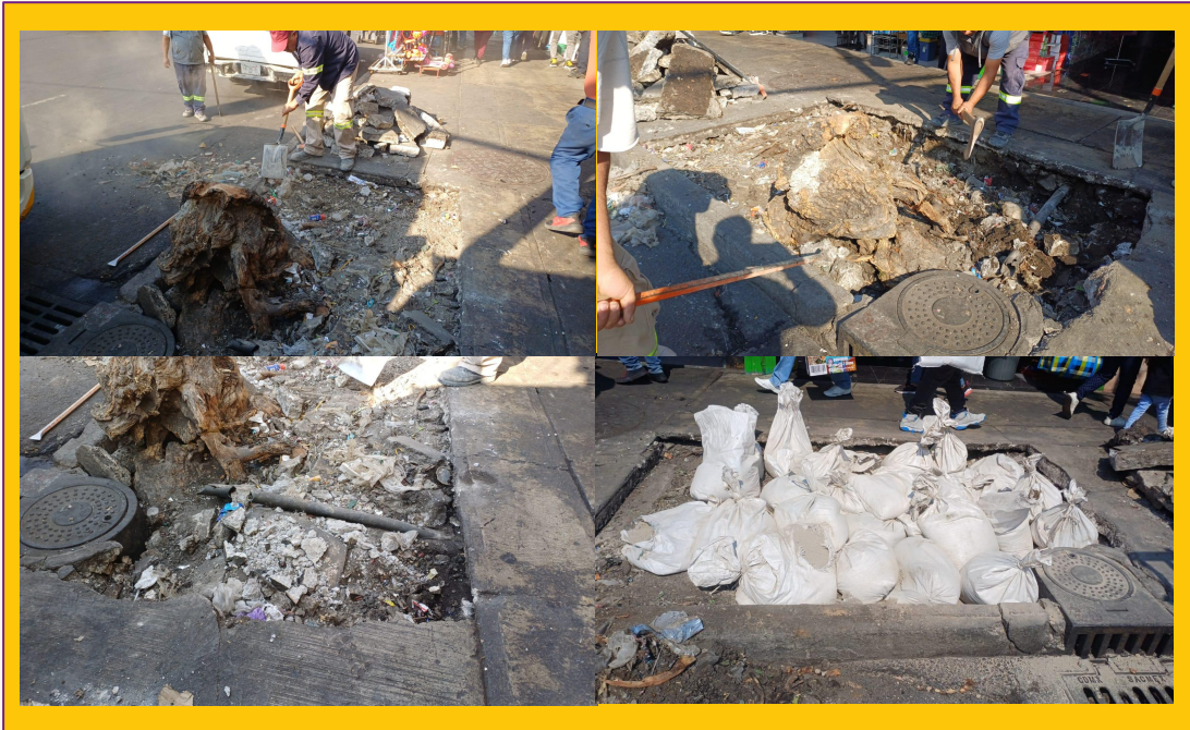
Retiro de tocón y demolición de banqueta Calle Jesus Maria esquina con Av. San Pablo
