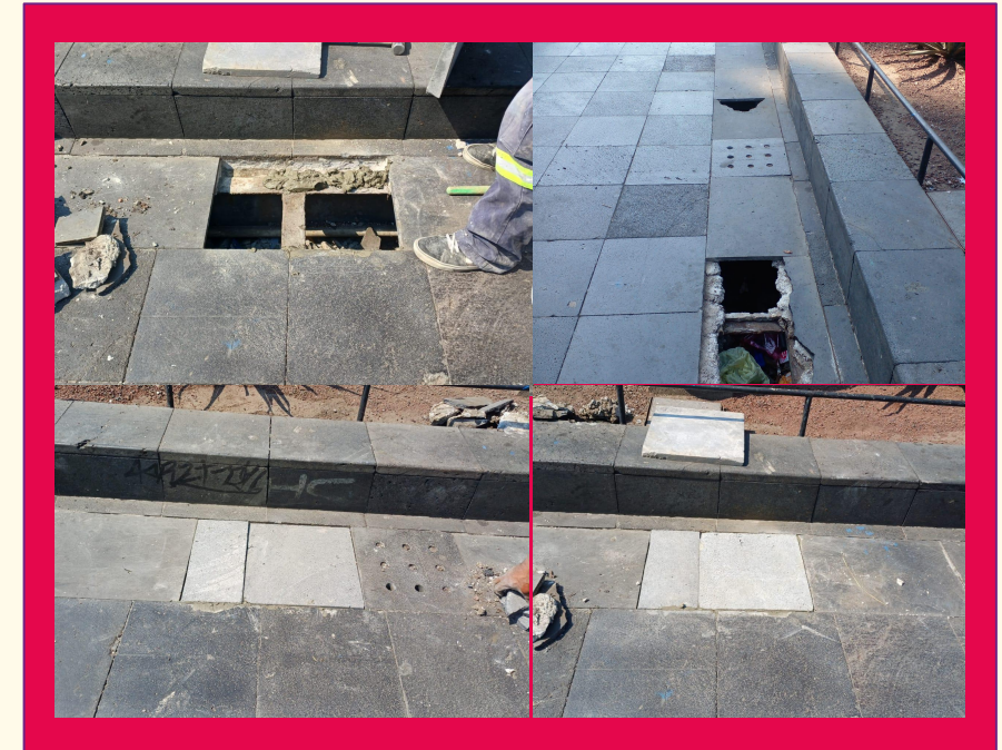
Sustitución de losetas Plaza Empedradillo.
