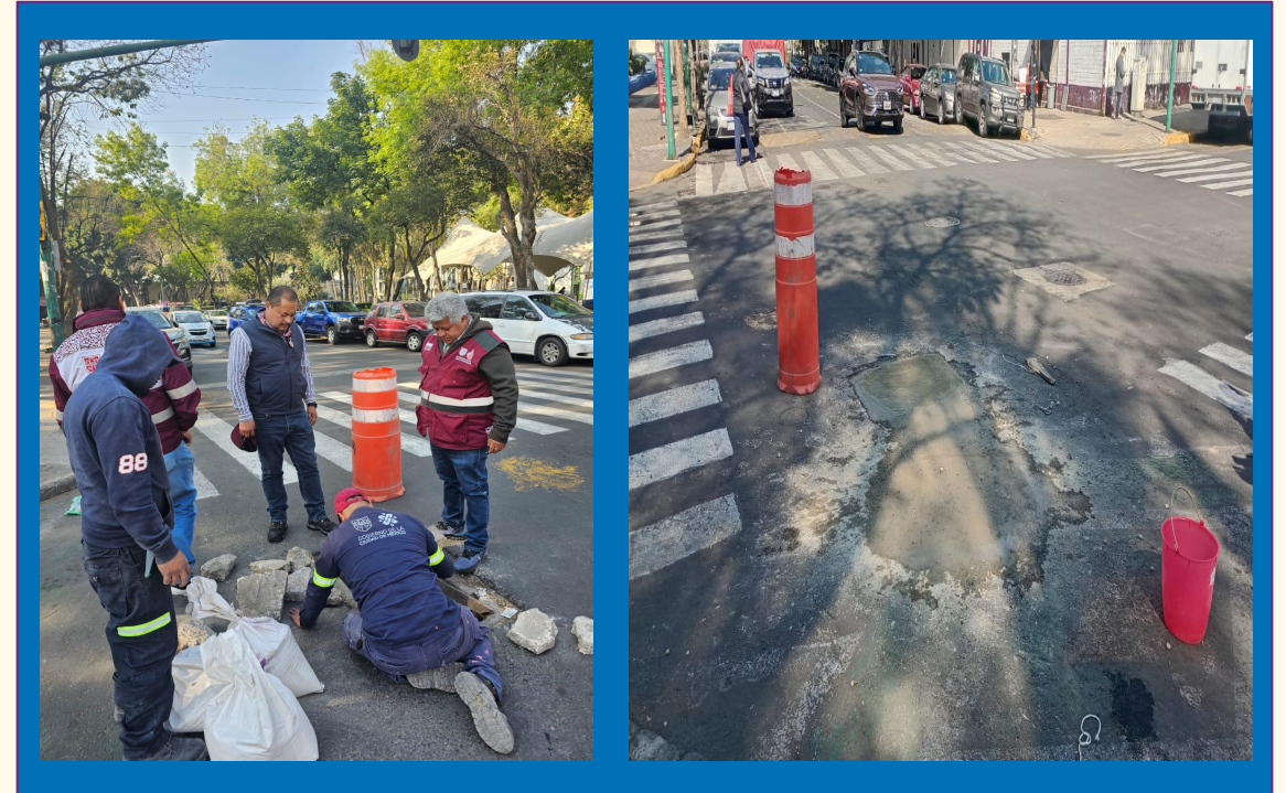
Reparación de registro. Plaza de la Ciudadela Calle Enrico Martínez esquina calle Emilio Dondé
