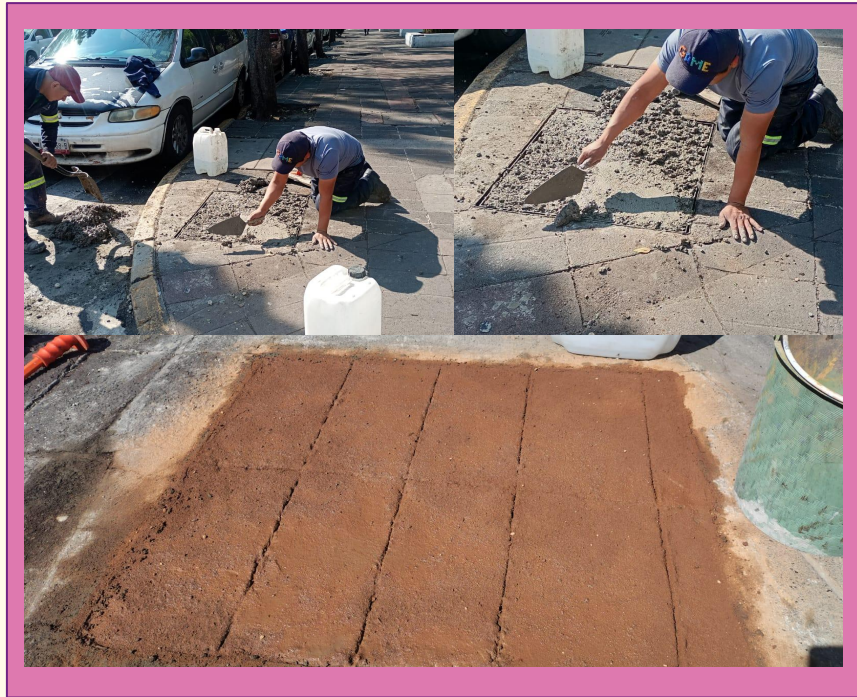
Reparación de registro. Plaza de la Ciudadela Calle Enrico Martínez esquina calle Emilio Dondé
