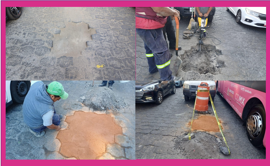
Reparación de bache Calle Tacuba entre calle Marconi y Eje Central Lazaro Cardenas
