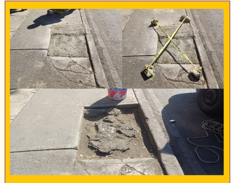
Colado de cajete en desuso Calle Jesus Maria esquina con Av. San Pablo
