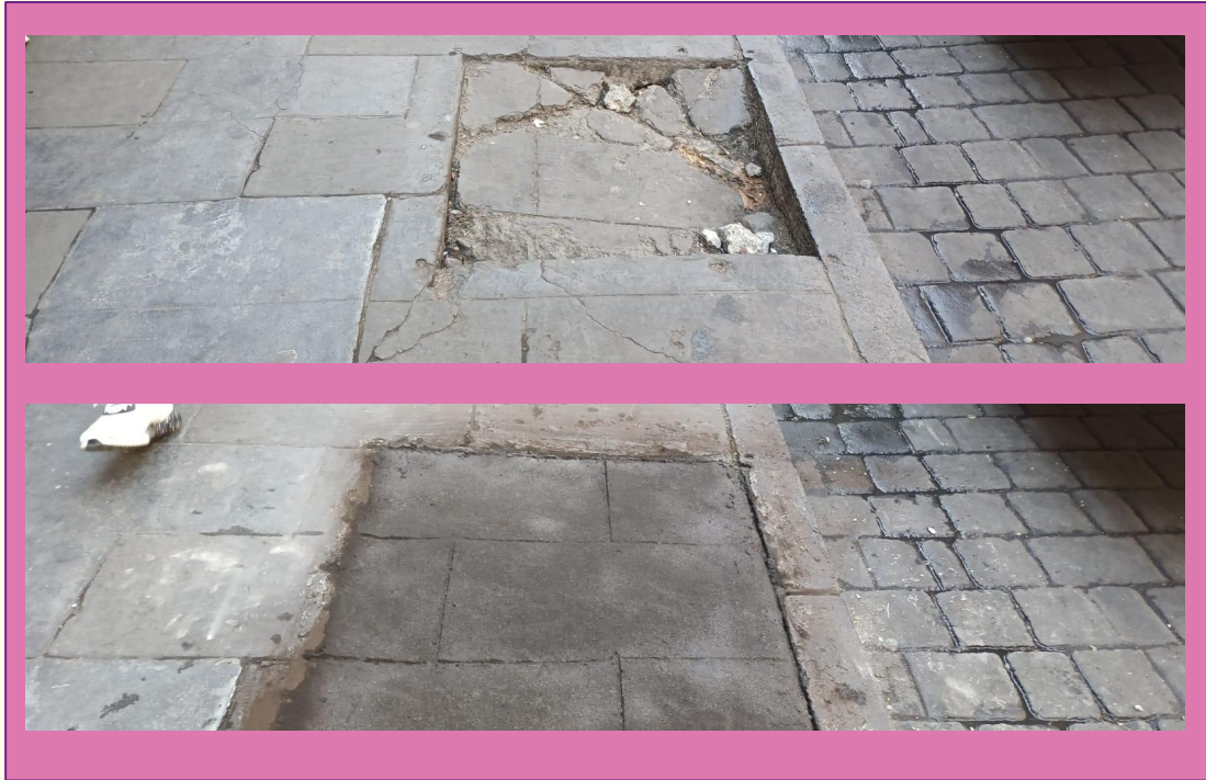
Colado en banqueta Calle Tacuba entre calle Monte de Piedad y calle Palma
