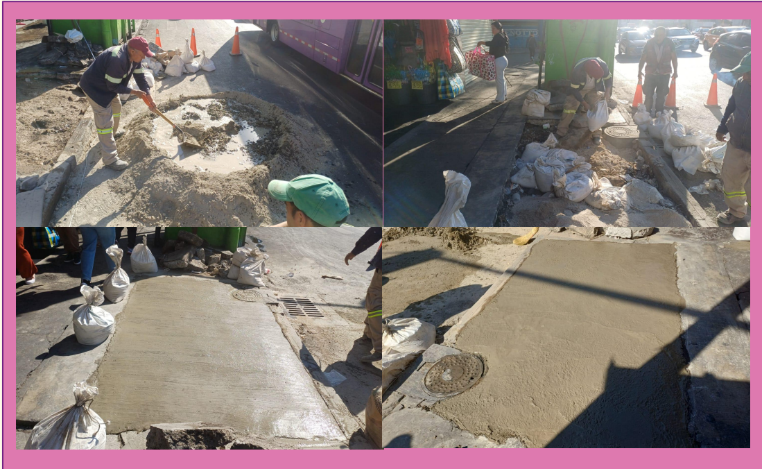
Colado de banqueta Calle Jesus Maria esquina con Av. San Pablo
