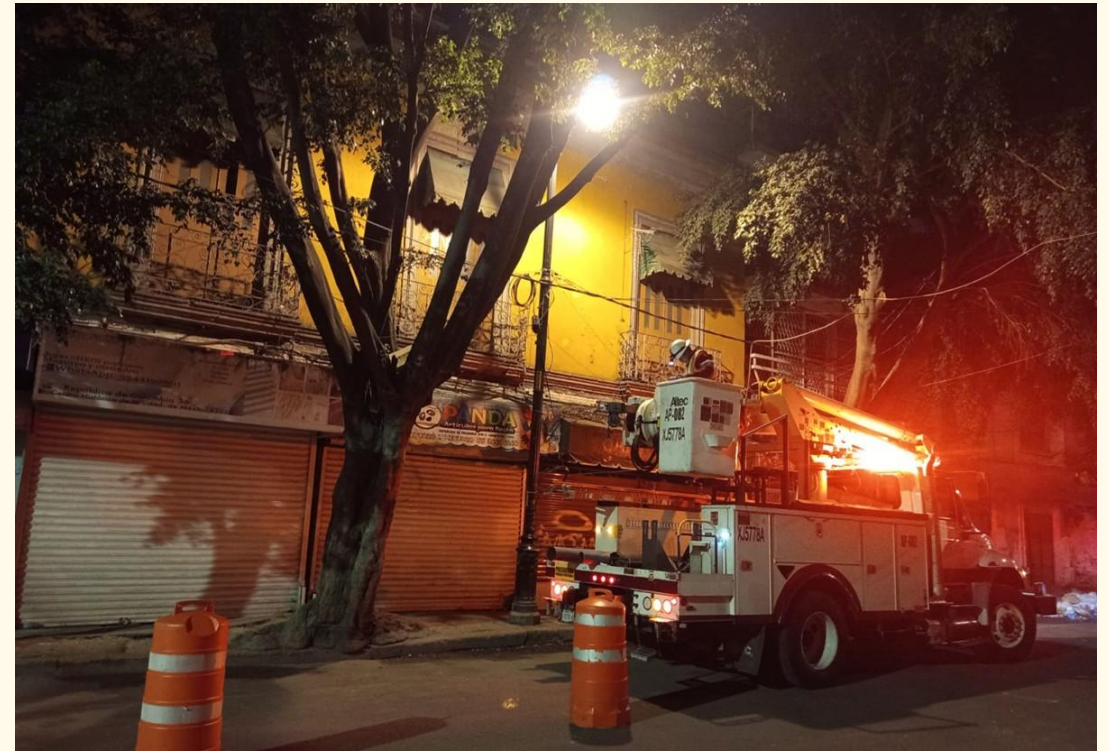
RECONEXIÓN DE LÍNEAS DE ALIMENTACIÓN
