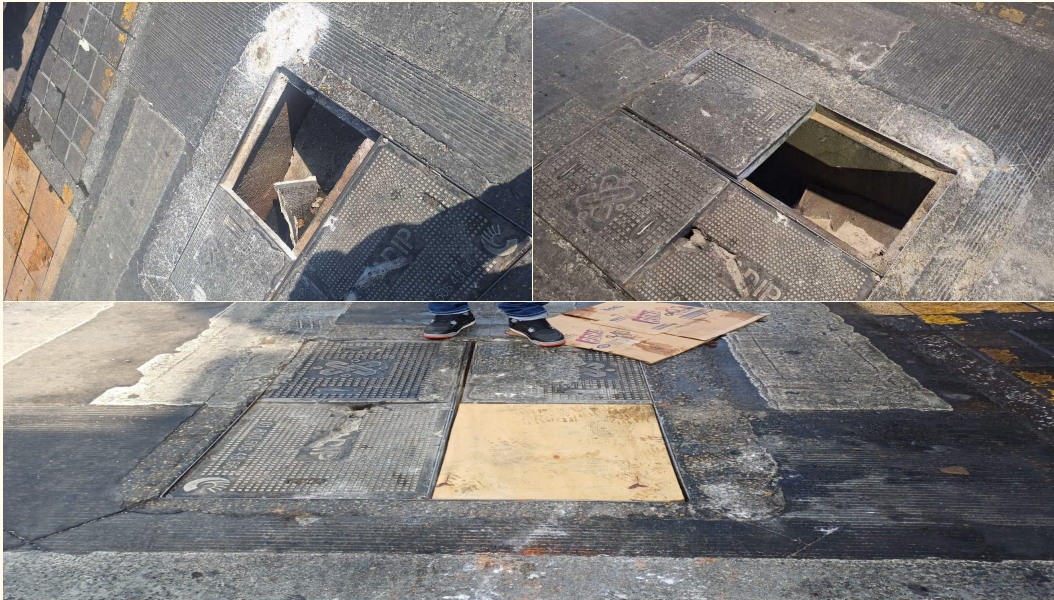
Colocación de doble hoja de triplay Av. Balderas 76 entre calle Ayuntamiento y calle Victoria
