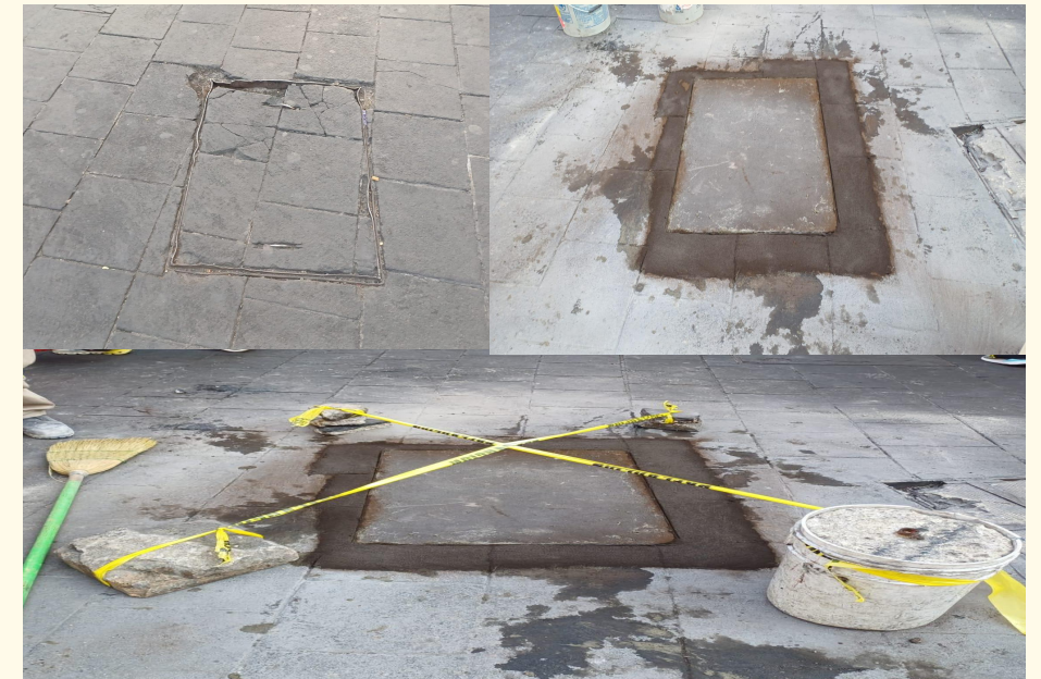
Sustitución de registro en mal estado en Calle de el Carmen esq. con Calle República de Venezuela.
