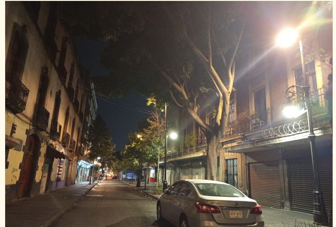
RECONEXIÓN DE LÍNEAS DE ALIMENTACIÓN
