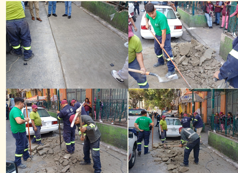
Demolicion de piso de concreto Calle Peña y Peña esq con calle Manuel Doblado.
