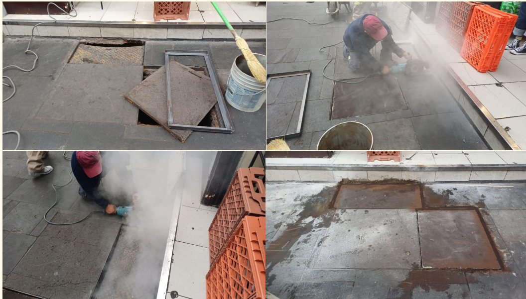
Colocación de dos registros Av. 20 de Noviembre #126 entre calle San Jerónimo y Regina
