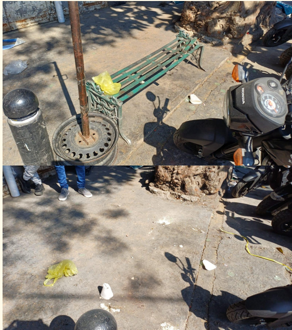
Retiro de 1 banca metálica en mal estado Calle Peña y Peña entre calle González Ortega y calle Manuel Doblado
