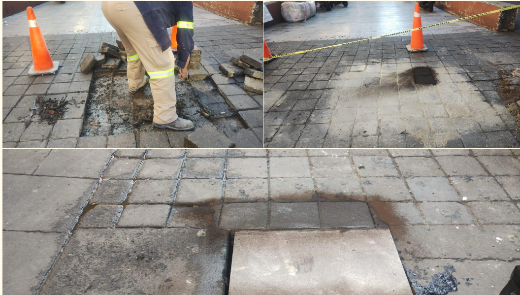
Renivelacion de 25 basaltines de 15X15 cms Calle Jesus Maria esquina con calle Zapata
