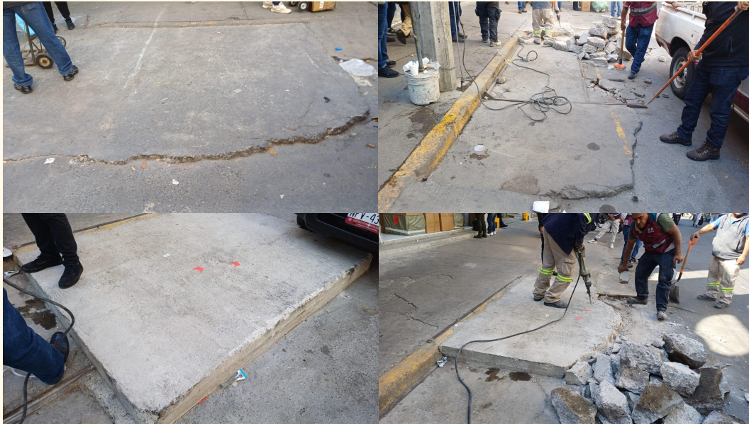
Demolición de planchas de concreto en arroyo vehicular Calle Peña y Peña entre González Ortega y Manuel Doblado
