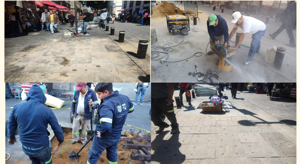
Mantenimiento de registros de captación Pluvial Calle República de Argentina entre Donceles Gonzales Obregon
