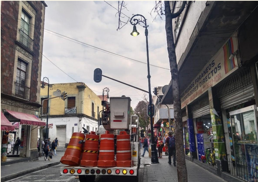
REPOSICIÓN DE LUMINARIA
