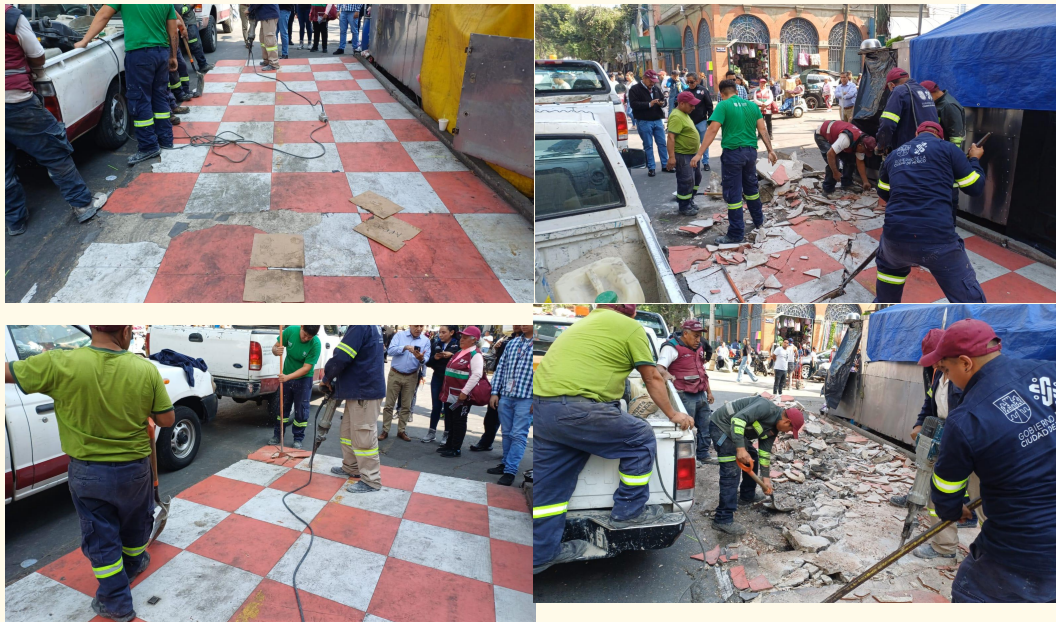
Demolición de piso de concreto Calle Peña y Peña esq. con calle Manuel Doblado.
