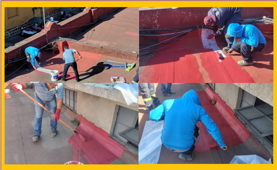
Limpeza y refuerzo de impermeabilizante República de Venezuela #72 (IEMS)
