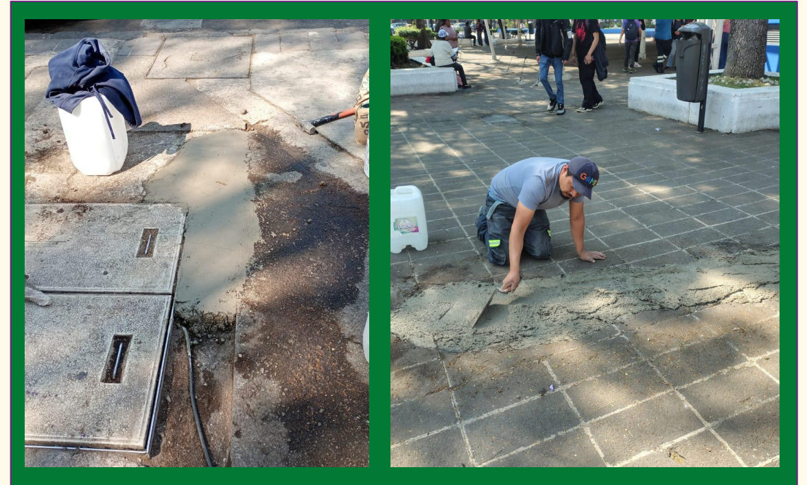
Reparación de baches. Plaza de la Ciudadela y Plaza del Danzón Calle Enrico Martínez esquina calle Emilio Dondé
