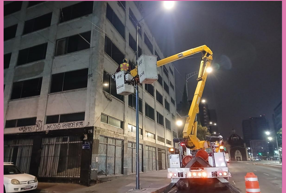
RECONEXIÓN DE LÍNEAS DE ALIMENTACIÓN Y CAMBIO DE FOTOCELDA
