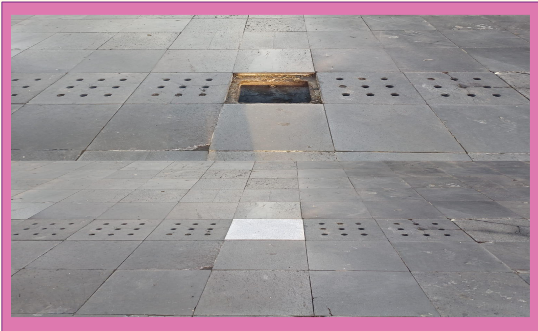
Sustitución de una loseta Plaza Empedradillo
