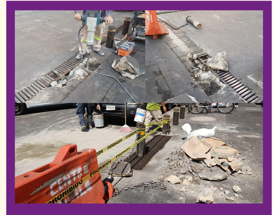
Retiro de rejilla Irving y colado Calle Republica Argentina esq con calle San ildefonso.
