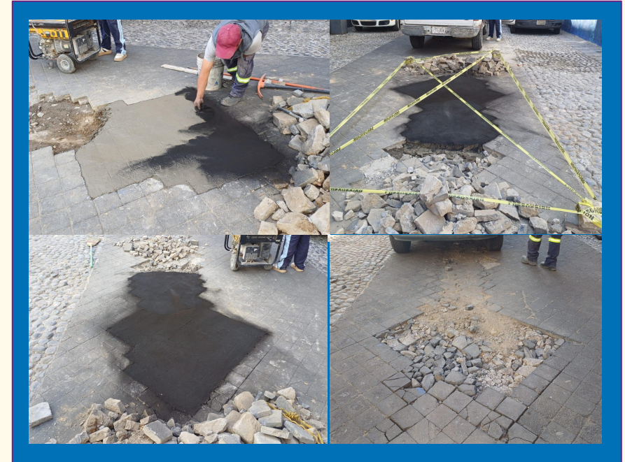
Colado de piso Calle San Ildefonso
