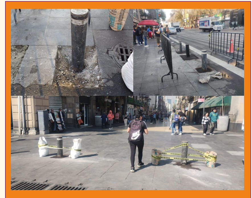
Colocación de bolardos. Calle Madero esquina Eje Central Lázaro y en Madero y Plaza de la Constitución
