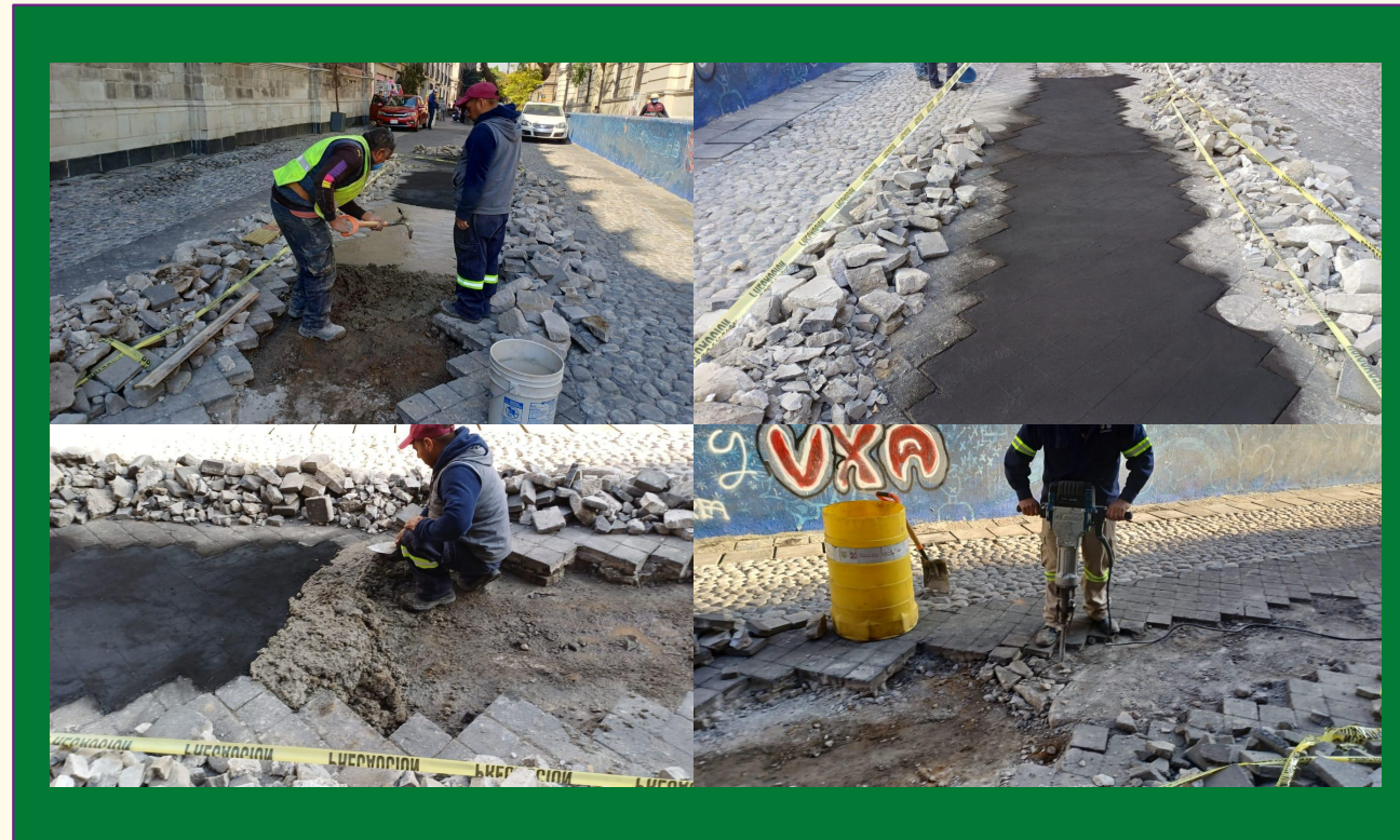
colado de piso calle san ildefonso.
