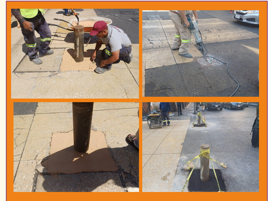
Colocación de bolardos Calle Madero esquina con calle Palma
