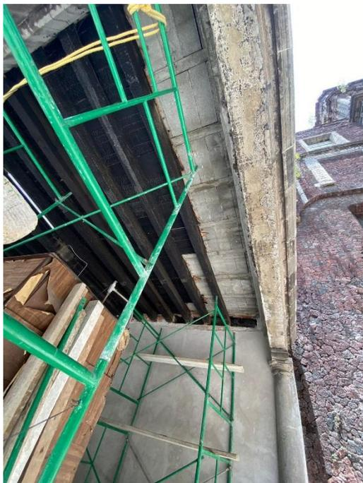
Liberación de vigería y tablado de madera por encontrarse con presencia de carbón, para su posterior sustitución.
