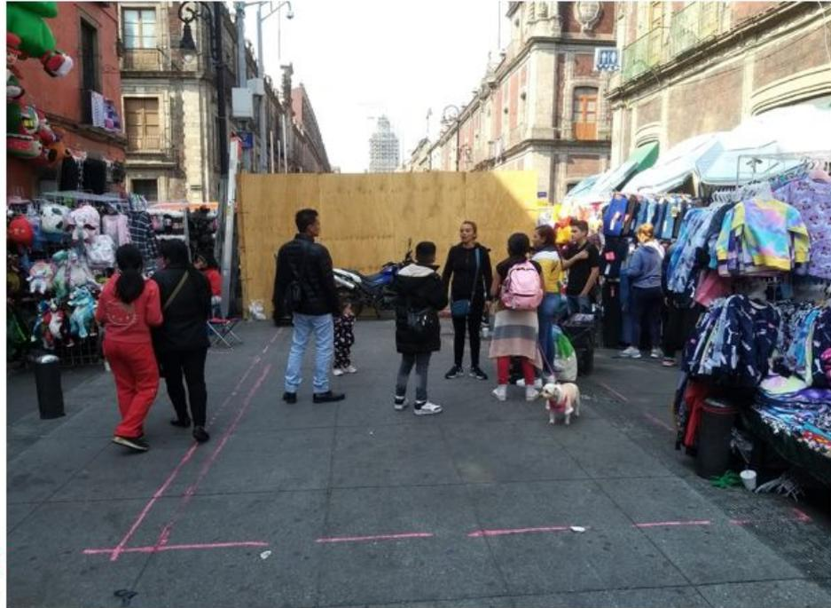
2. Ya se cuenta con el trazo físico en sitio para la ampliación del tapial y del área a utilizar para la construcción de la caja de válvulas.
