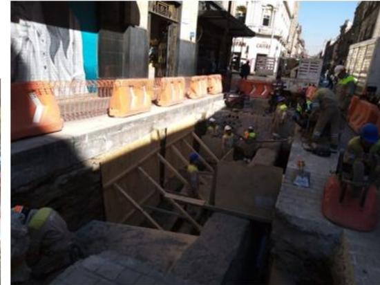
5. Protección con ademe a base de madera del talud de la excavación, para continuar con los trabajos por medios manuales.
