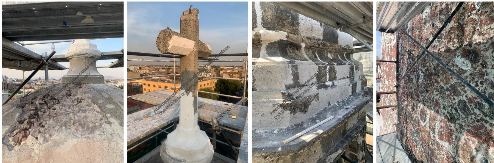
Liberación de aplanado deteriorado en cupulín de campanario. Integración de juntas y resanes en elementos de cantera. Consolidación de muro de mampostería de piedra.
