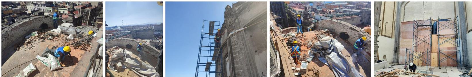
Retiro de enladrillados y aplanados deteriorados en azoteas de transepto sur y presbiterio, limpieza y consolidación de molduras de argamasa en cornisas de tambor de cúpula; habilitado de encofrado de protección en retablo de transepto sur.
