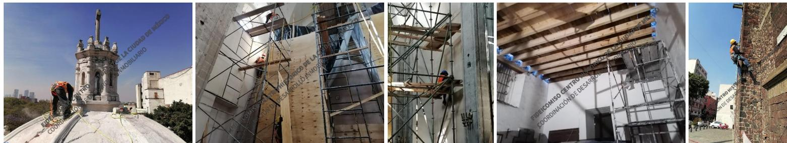
Trabajos de exploración de grietas en extradós de cúpula, encofrado de retablo y calas estratigráficas en la Capilla de la Preciosa Sangre; integración de vigas de madera y tablado en cubierta de sacristía y eliminación de flora parásita en fachada.
