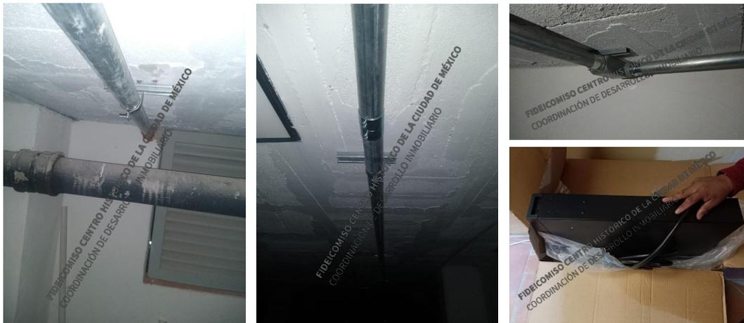
Habilitado de canalización de tubería galvanizada del circuito de energía regulada para equipos de auditorio. Suministro de UPS.
