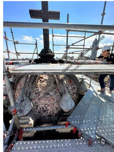
Trabajos de cocido de grietas y reintegración de fábricas en pechinas de la cúpula del Templo. Retiro y sustitución de sillares de cantera en pilastras ubicadas en el área del transepto. Retiro de impermeabilizante, pintura y el entortado deteriorado al exterior de la cúpula y cupulino de la linternilla.
