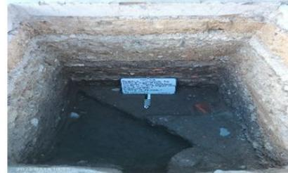
1. Se continúan trabajos de excavación por medios manuales, para la localización de una posible caja de válvulas existente.
