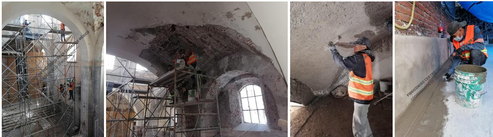
Trabajos de consolidación de grietas en muros y cúpula de capilla, inyección en bóvedas y muros, reintegración de aplanados y reintegración de losa de cubierta en sacristía.
