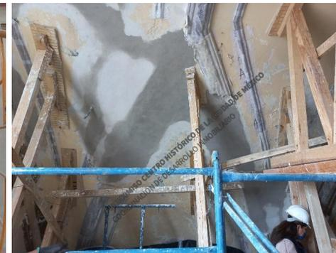
Rejunte e impermeabilización de enladrillado y recubrimiento cerámico en cúpula. Integración de tapa de pretilas. Reintegración de aplanados a base de cal-arena en interiores del templo.
