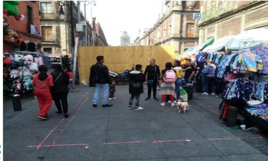
2. Ya se cuenta con el trazo físico en sitio para la ampliación del tapial y del área a utilizar para la construcción de la caja de válvulas.
