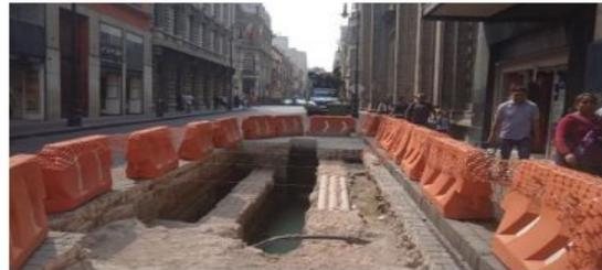
1. Se continuó con los trabajos de excavación a cielo abierto y ya han sido retiradas las canalizaciones de CFE que se encontraban fuera de servicio.
