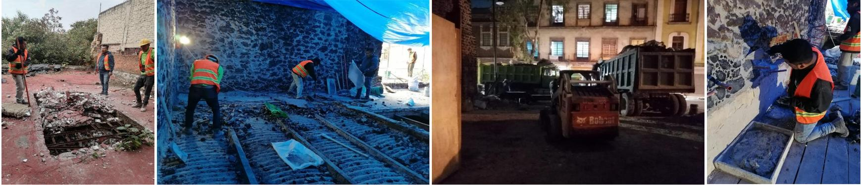
Demolición de losa de sacristía, retiro de vigas metálicas de losa de sacristía, calas estratigráficas en muros de capilla, consolidación de muros de mampostería.
