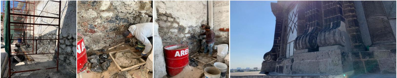
Consolidación de muro testero y retiro de empastes de cemento en tambor de cúpula.
