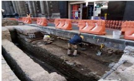
2. Se continúan trabajos de excavación por medios manuales para llegar al desplante del inicio de construcción de la caja de válvulas.
