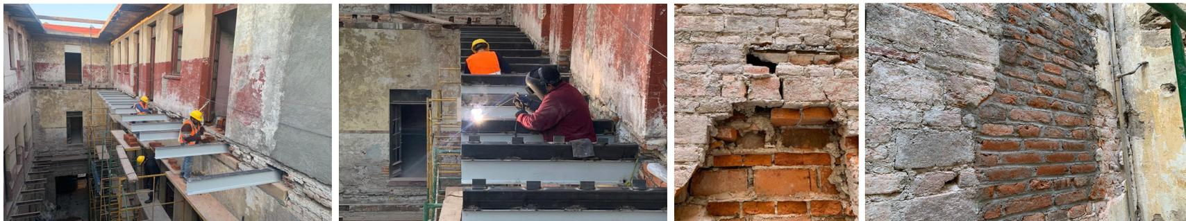
Consolidación de muros, consolidación de mechinales y habilitación de vigas metálicas en pasillo central.
