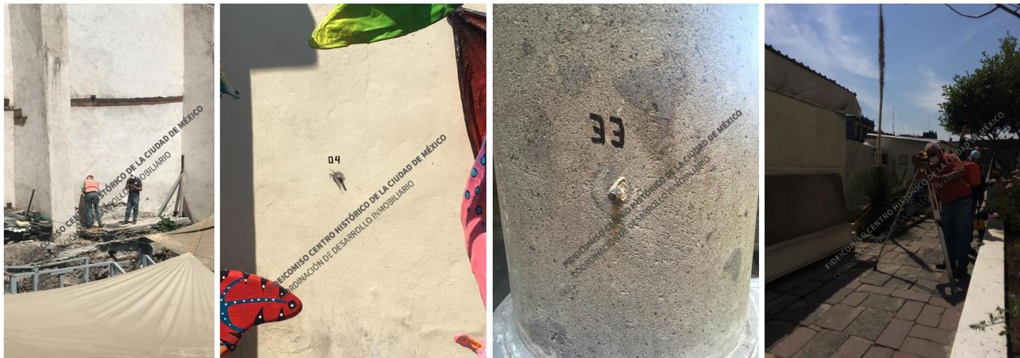
Colocación de puntos de control para lectura de niveles topográficos.
