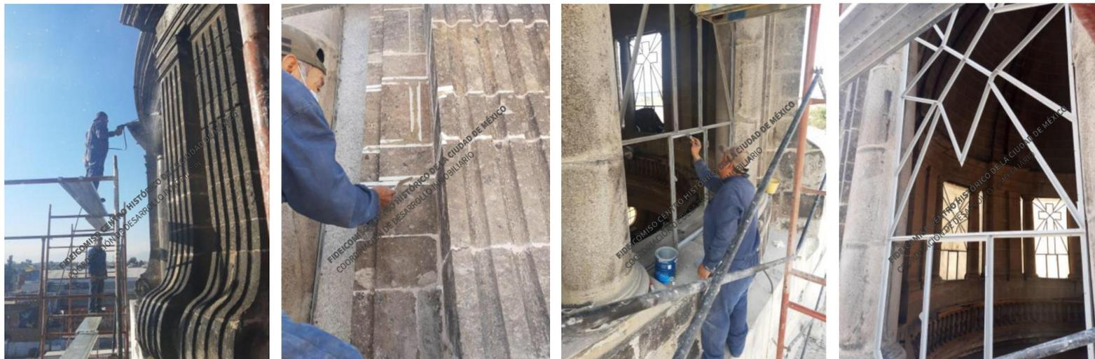
Limpeza húmeda de elementos de cantera, integración de juntas en pilastras y tratamiento integral de herrerías de ventanales en tambor de cúpula.
