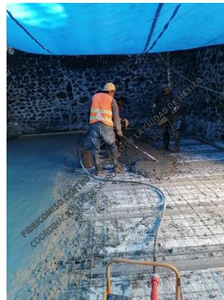
Trabajos de consolidación de grietas en muros y cúpula de capilla, inyección en bóvedas y muros, reintegración de aplanados y reintegración de losa de cubierta en sacristía.
