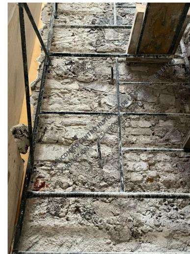
Trabajos de cosido, remamposteo e inyección de grietas en muros.
