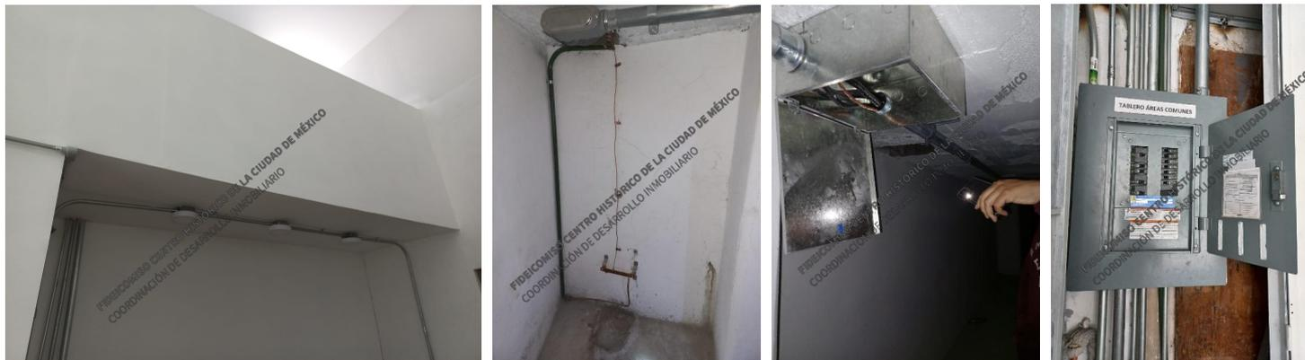
Terminación de faldones y sellos de ventanas en área de vigilancia, sistema de tierras físicas, instalación de energía eléctrica regulada y detalles solicitados por la Unidad de Verificación de Instalaciones Eléctricas.
