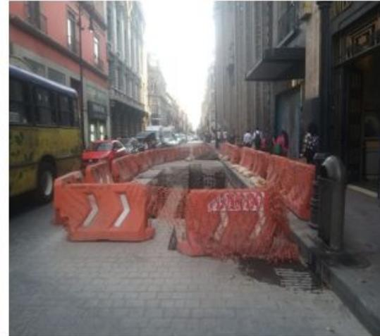
Finalmente se culminan los trabajos de excavación y se otorga la liberación del área de trabajo, por lo que se iniciarán trabajos de relleno y compactación, para dar inicio a los trabajos de la construcción de la caja de válvulas.
